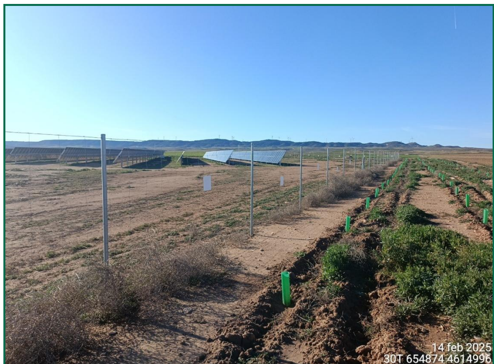
Fotografía 11. Vallado perimetral con placas anticollisión.
