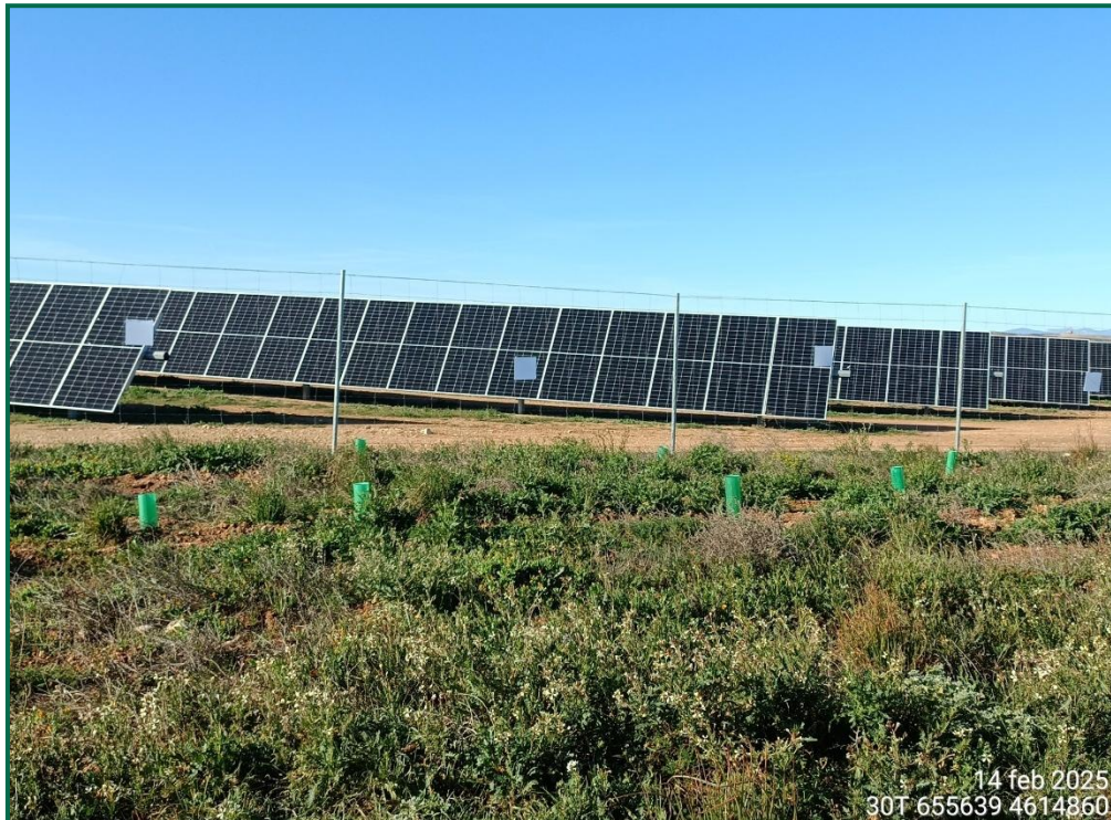
Fotografía 10. Vallado perimetral con placas anticollisión.
