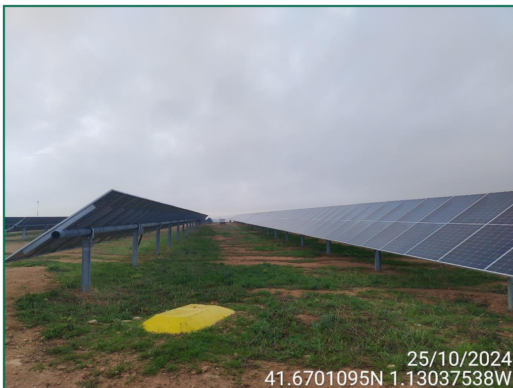
Fotografía 1. Zonas internas con vegetación entre seguidores
