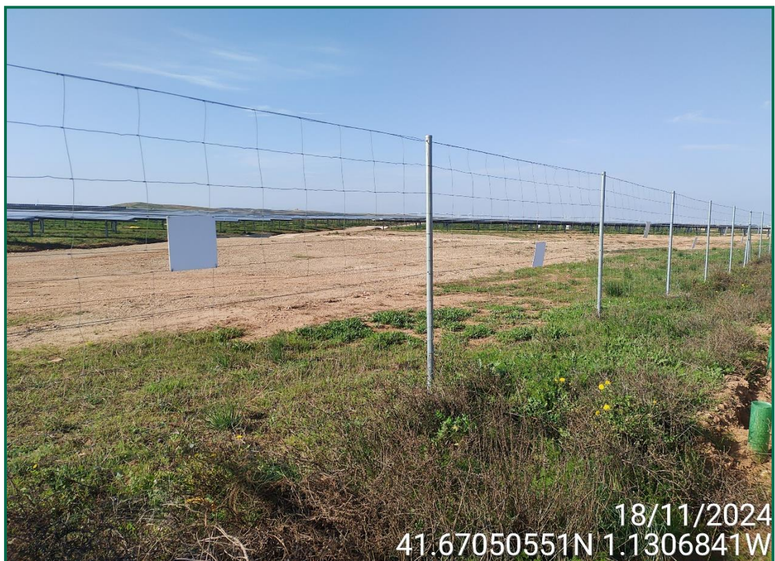
Fotografía 8. Vallado perimetral con placas anticolisión.
