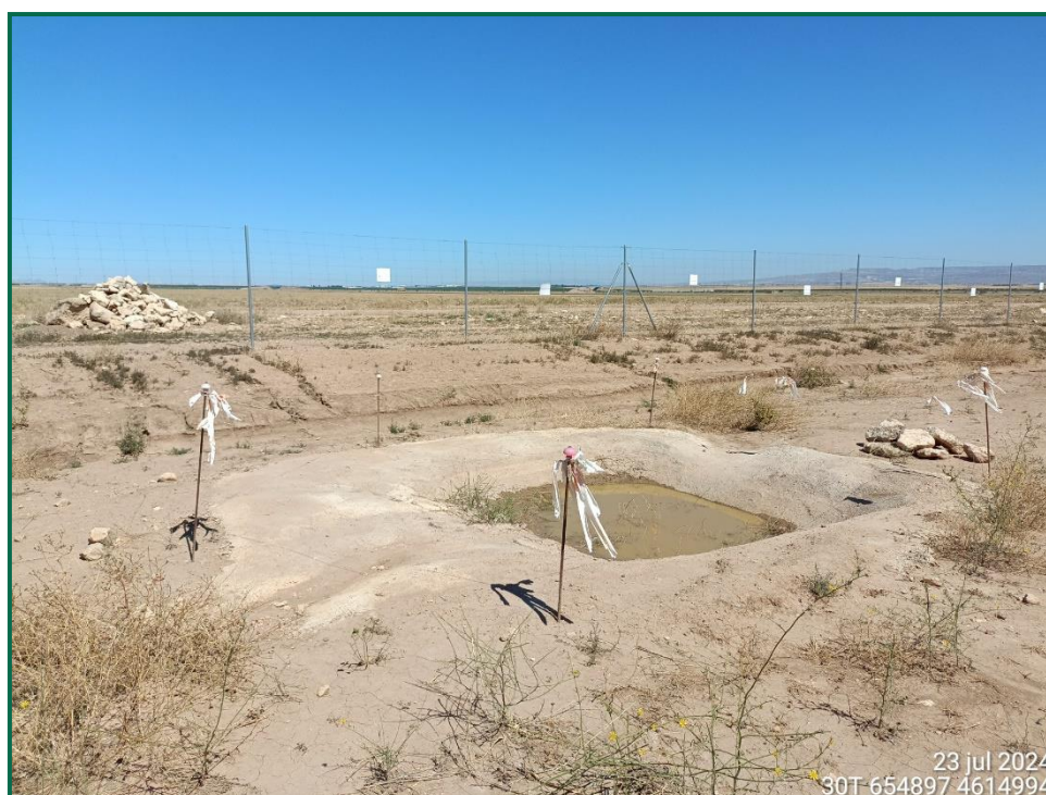
Fotografía 9. Balsete ya construido.
