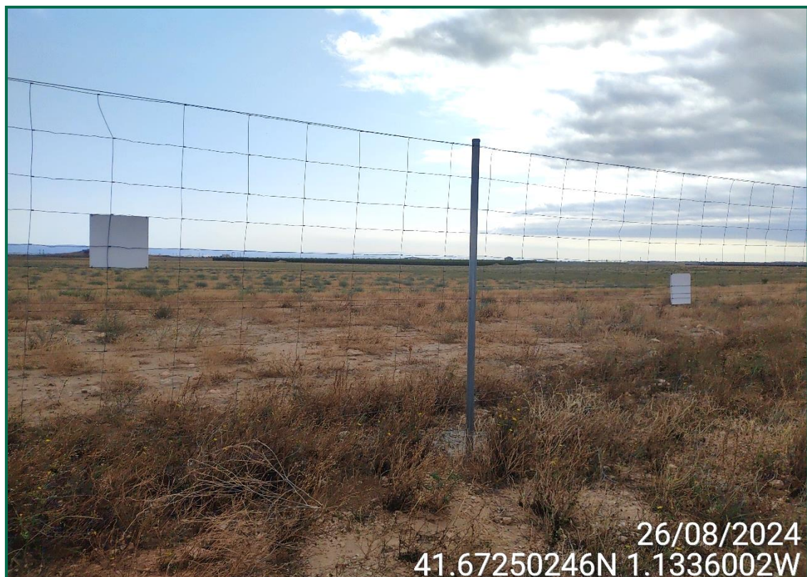
Fotografía 7. Vallado perimetral con placas anticolisión.
