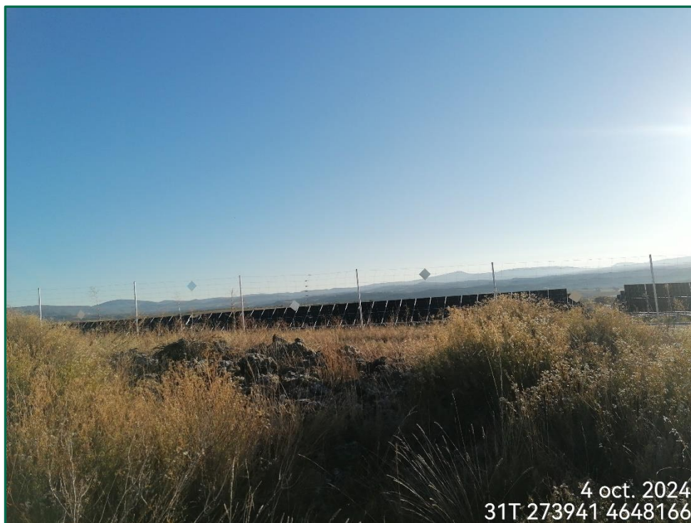
Fotografía 1. Placas solares ya colocadas.
