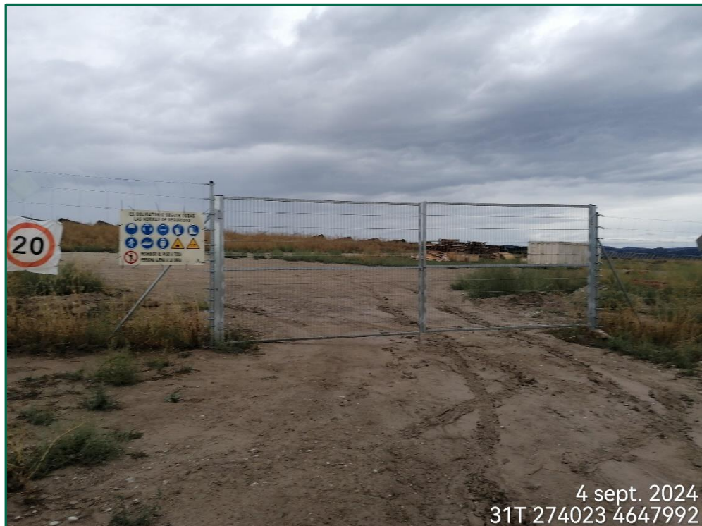
Fotografía 3. Puerta y vallado perimetral
