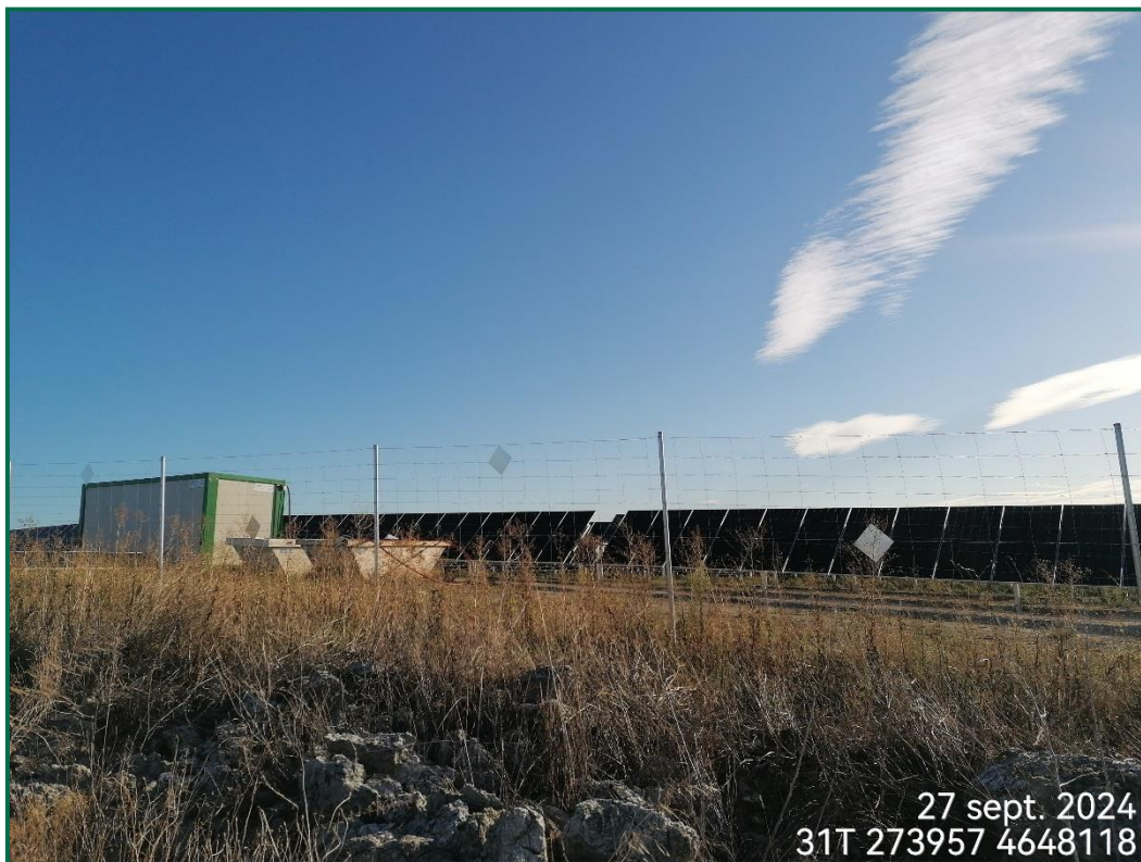
Fotografía 6. Contenedores para residuos inertes.
