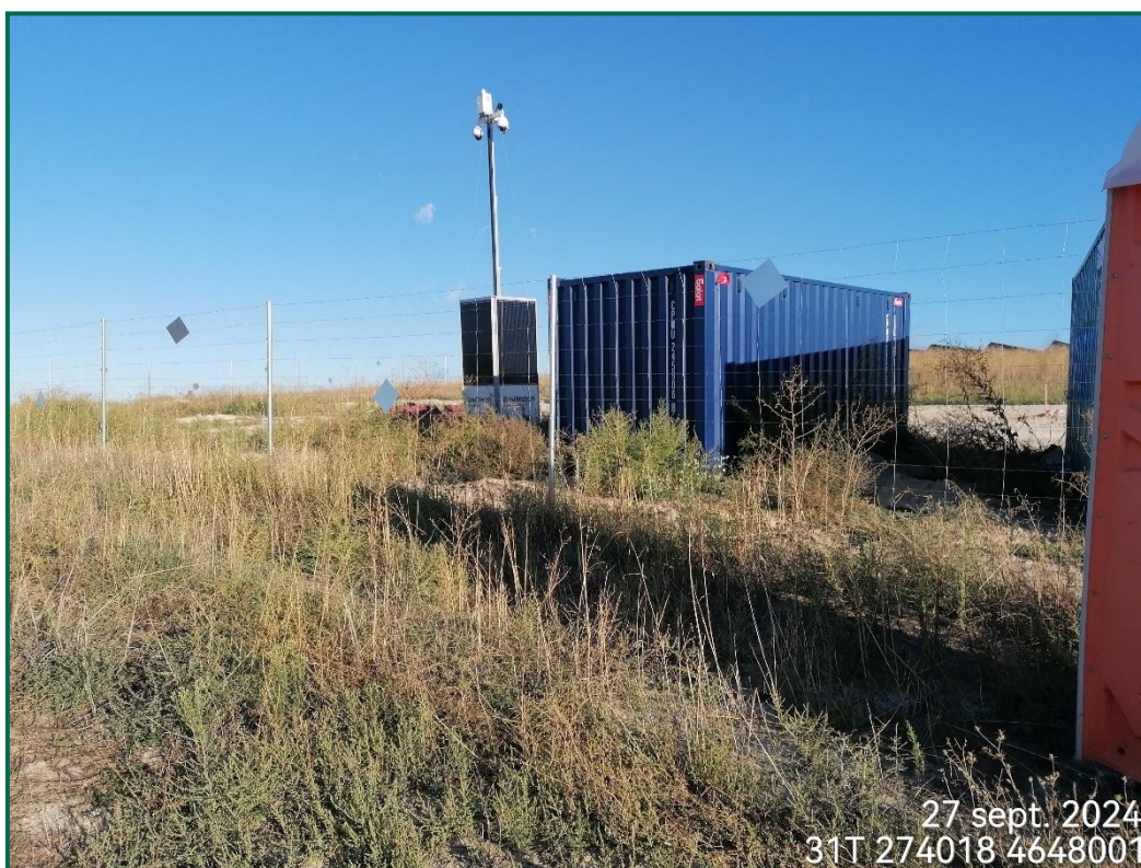
Fotografía 8. Contenedor donde se ubica el punto limpio de residuos peligrosos.
