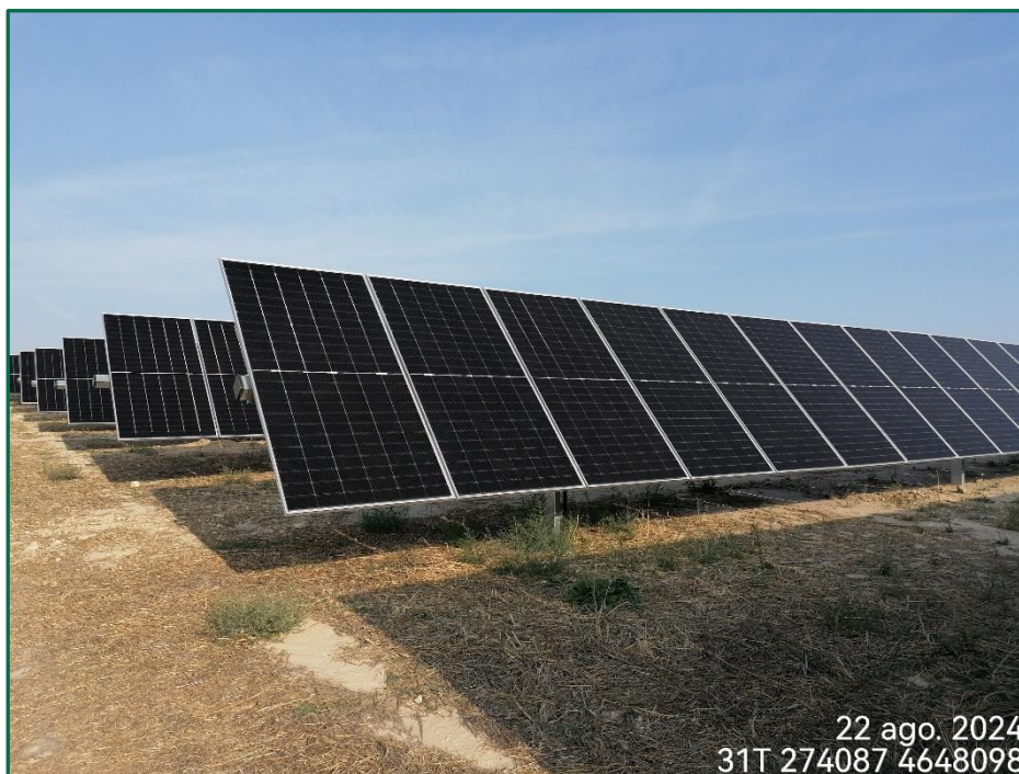
Fotografía 5. Superficie de la planta.
