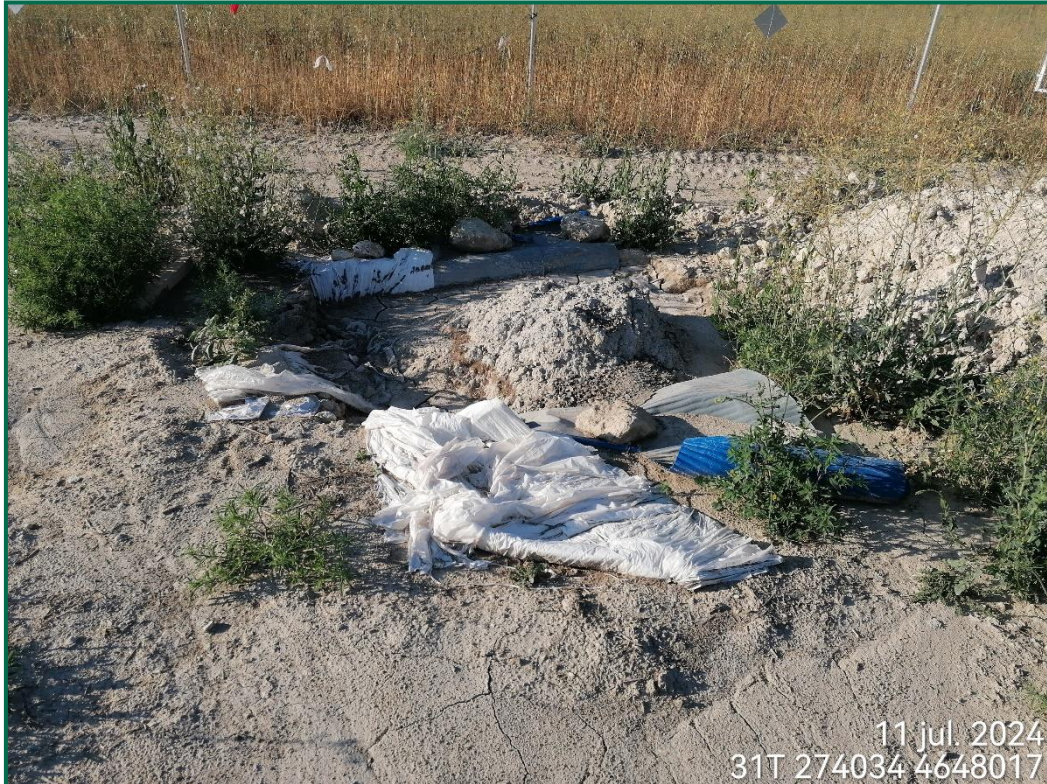
Fotografía 11. Balsa para lavado de hormigón.
