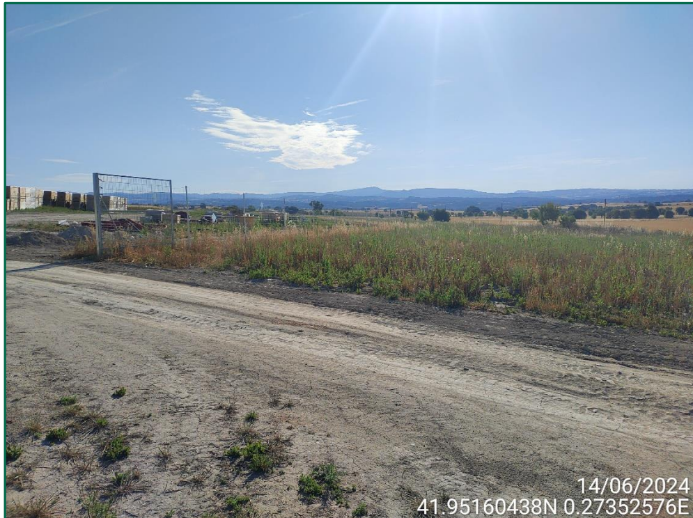
Fotografía 3. Puerta y vallado perimetral
