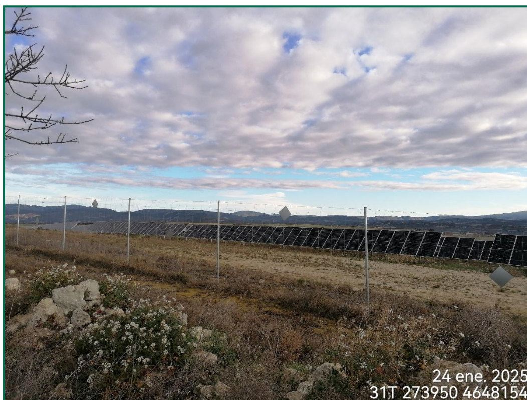
Fotografía 5. Zona donde se ubicaban los contenedores para residuos inertes.
