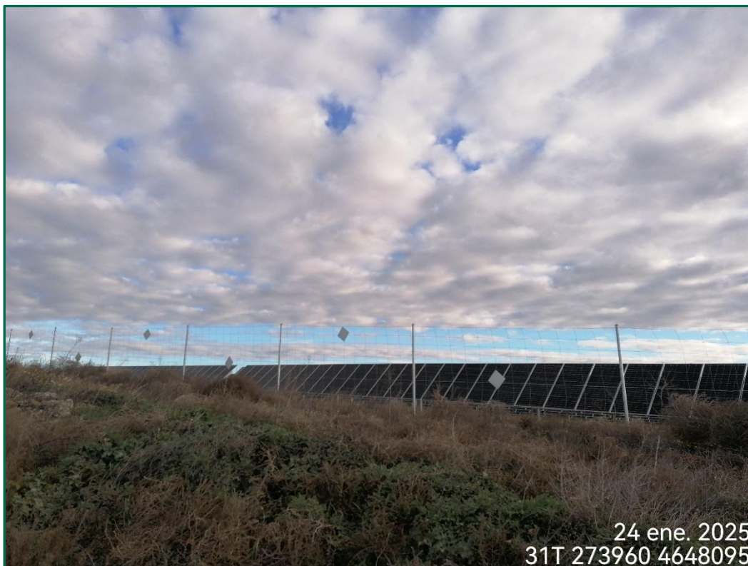
Fotografía 4. Vallado perimetral con placas anticollisión.
