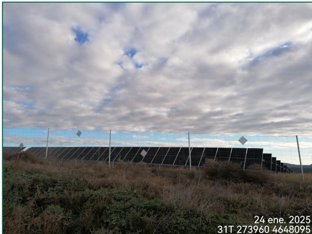
Fotografía 1. Placas solares ya colocadas.
