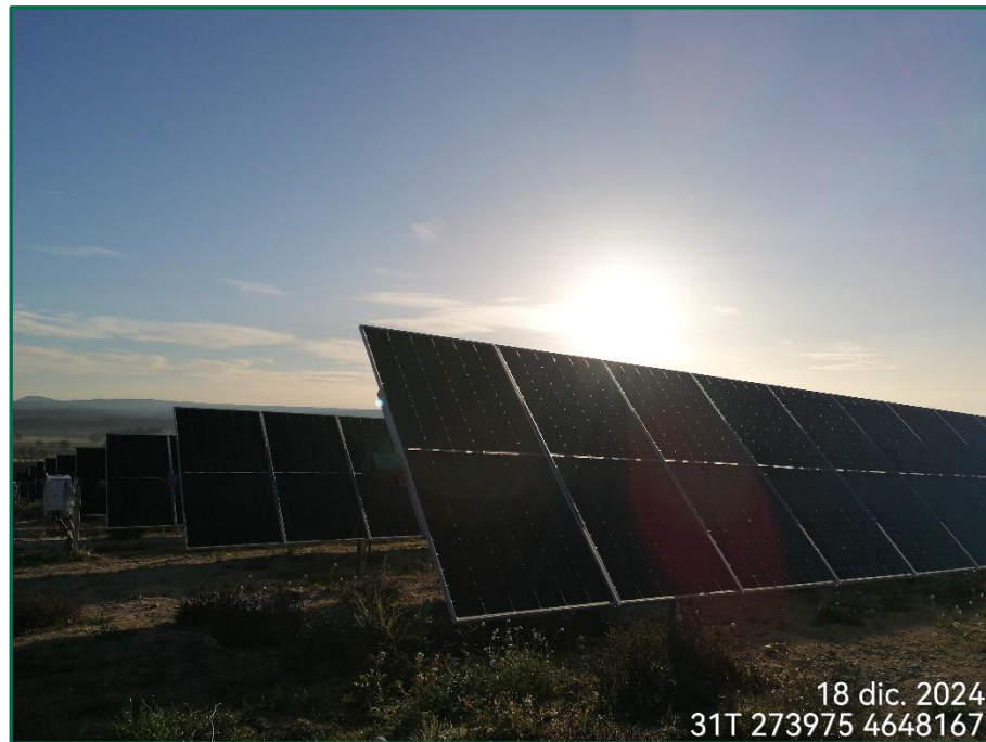
Fotografía 1. Placas solares ya colocadas.
