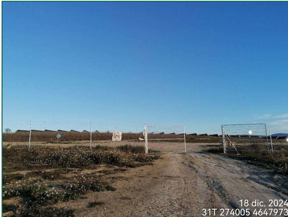
Fotografía 3. Puerta y vallado perimetral
