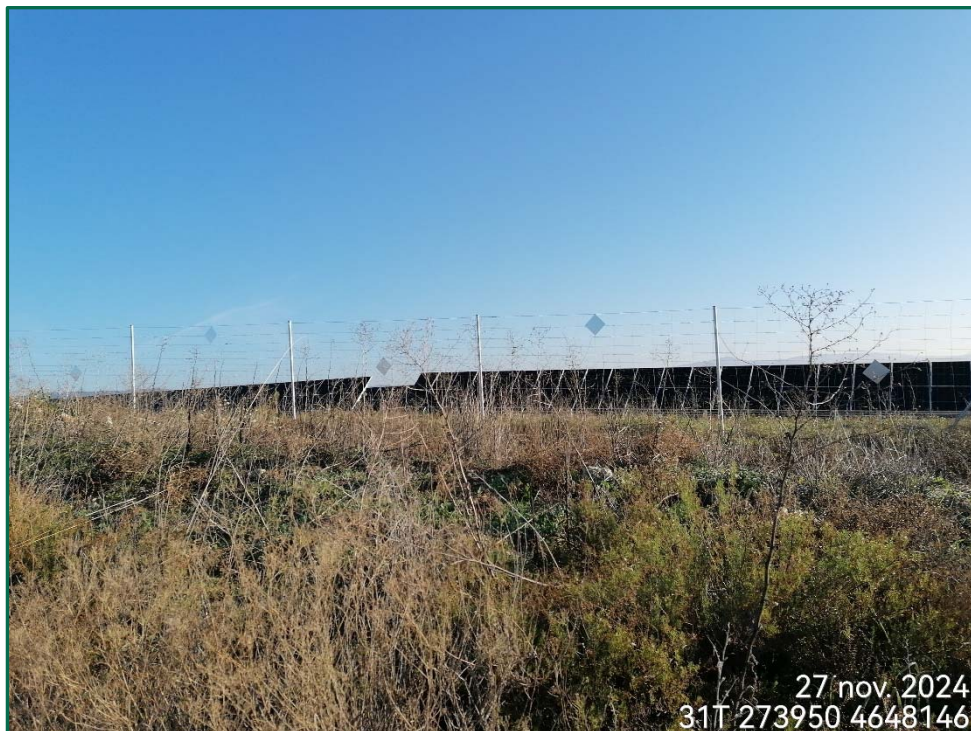
Fotografía 1. Placas solares ya colocadas.
