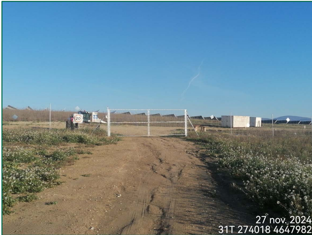
Fotografía 3. Puerta y vallado perimetral
