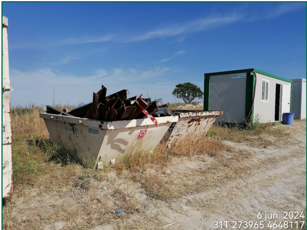
Fotografía 19. Zona de residuos inertes durante la obra.
