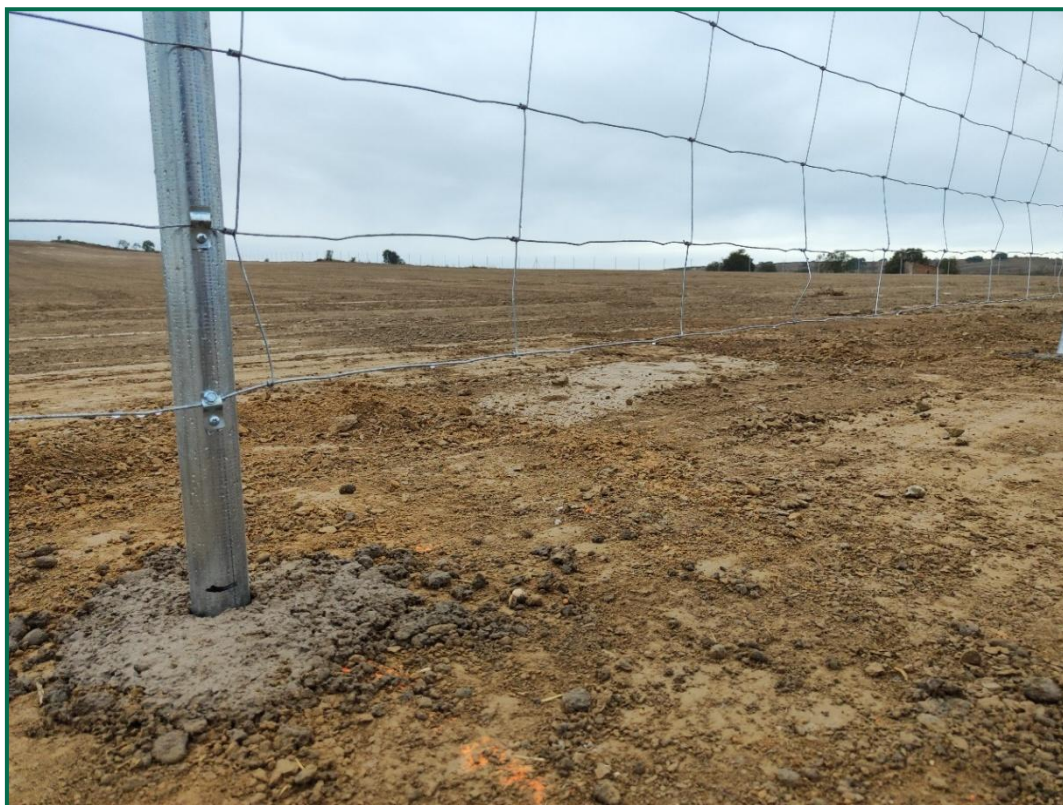
Fotografía 15. Vallado perimetral con espacio para el paso de fauna.
