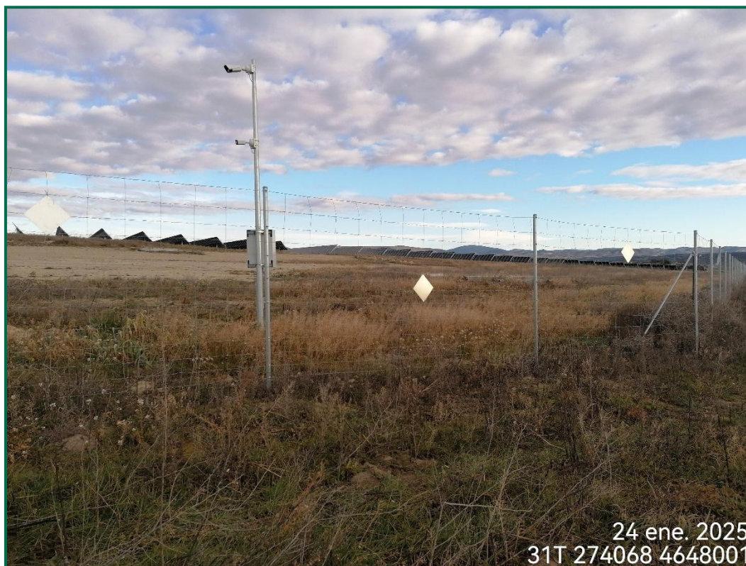
Fotografía 17. Vallado perimetral con placas anticollisión.
