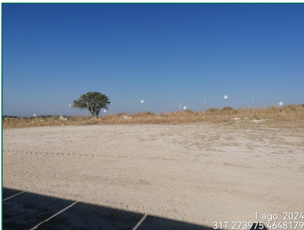
Fotografía 16. Vallado perimetral con placas anticollisión.
