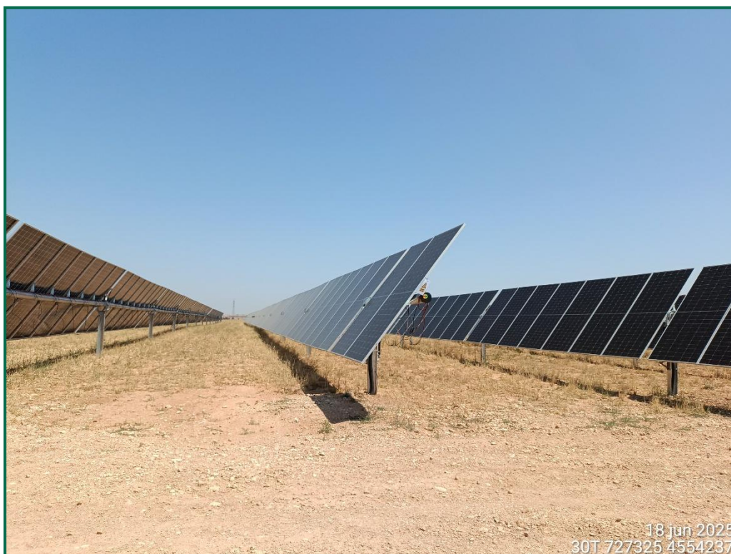
Fotografía 5. Superficie de la zona de hincado.
