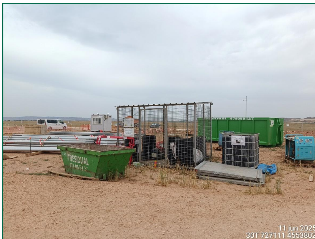
Fotografía 10. Punto limpio para residuos peligrosos.
