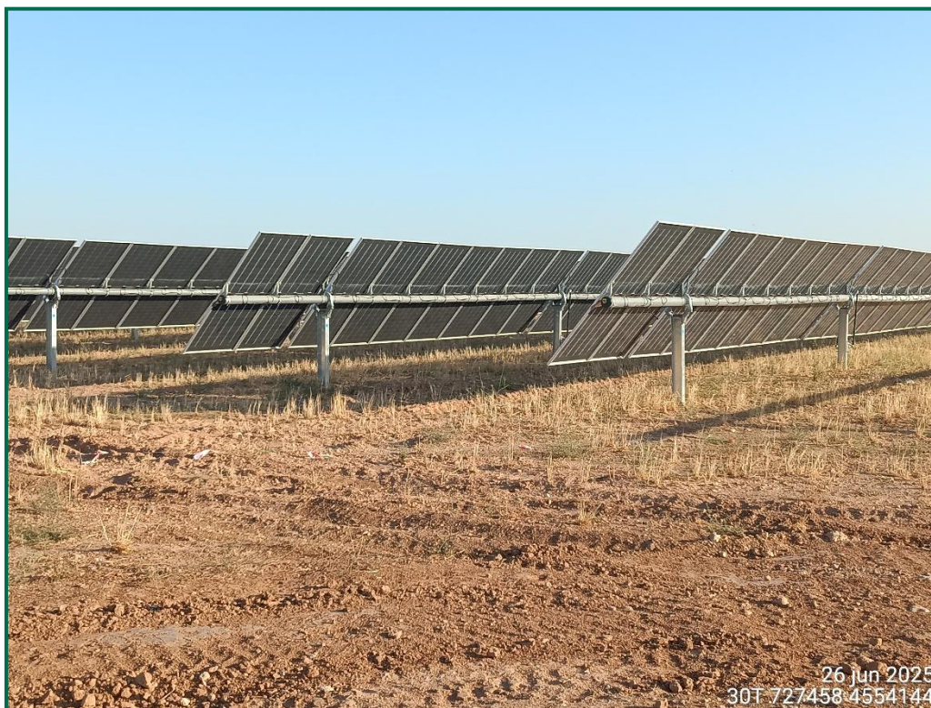
Fotografía 4. Superficie de la zona de hincado.
