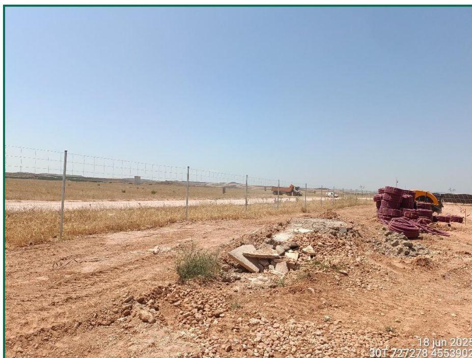
Fotografía 11. Balsa para lavado de canaletas.
