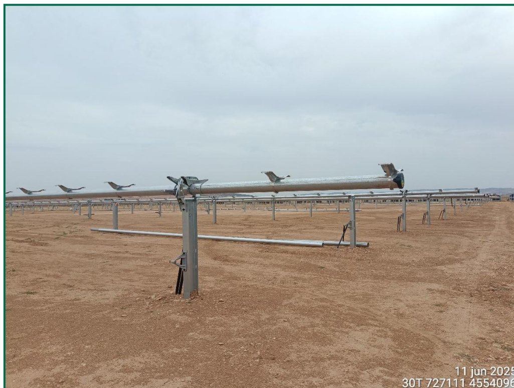
Fotografía 6. Superficie de la zona de hincado con movimiento de tierra y aporte de tierra vegetal.
