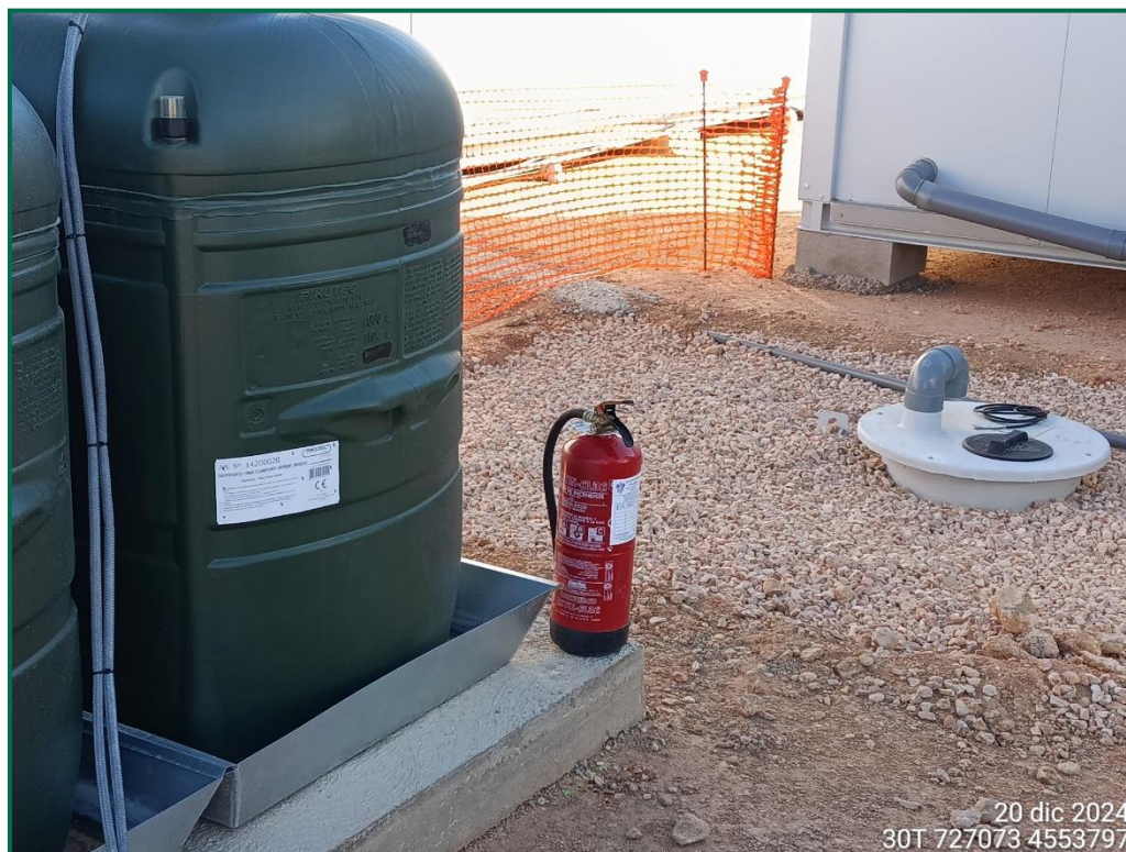
Fotografía 14. Bidones de combustible y fosa séptica.
