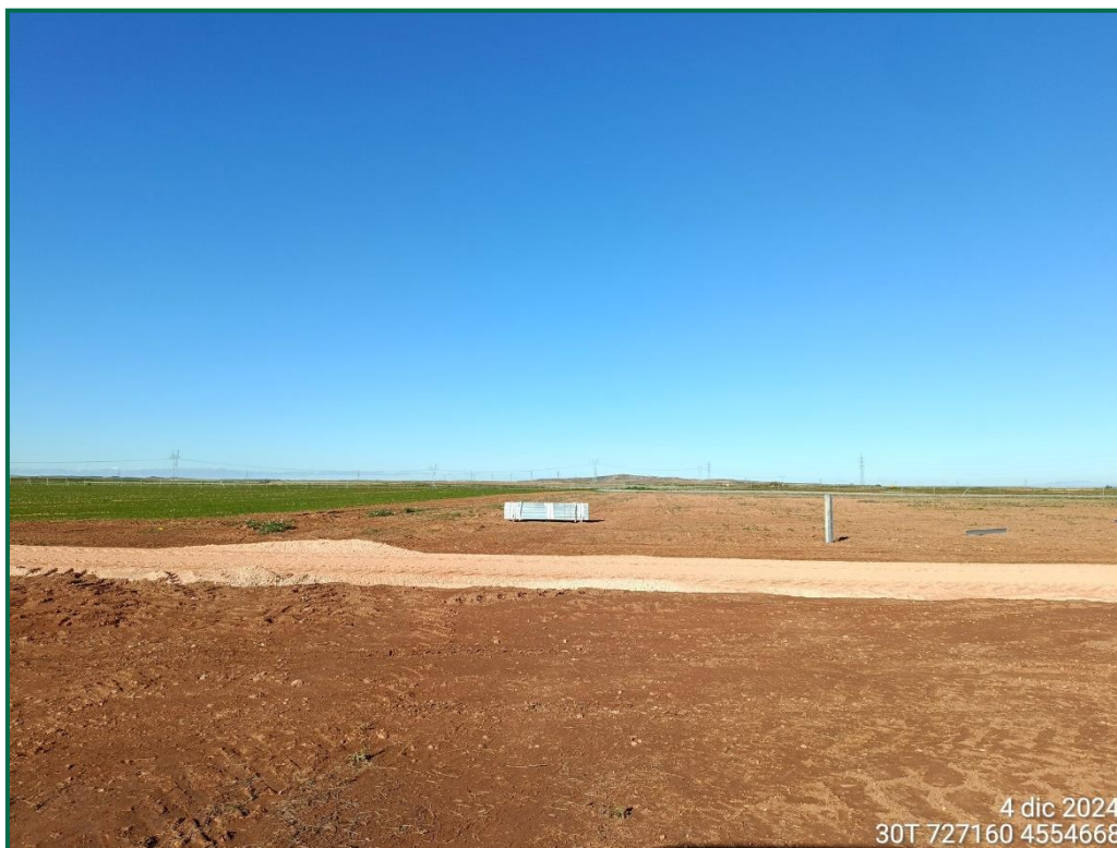
Fotografía 7. Superficie de la zona de hincado.
