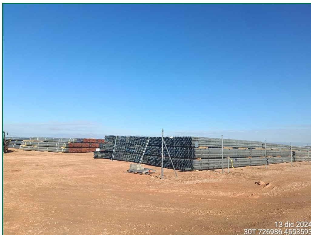
Fotografía 10. Superficie de la zona de acopios.
