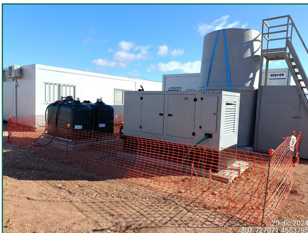
Fotografía 13. Grupo electrógeno.
