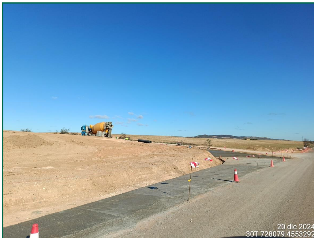
Fotografía 9. Entronque con carretera TE-35.
