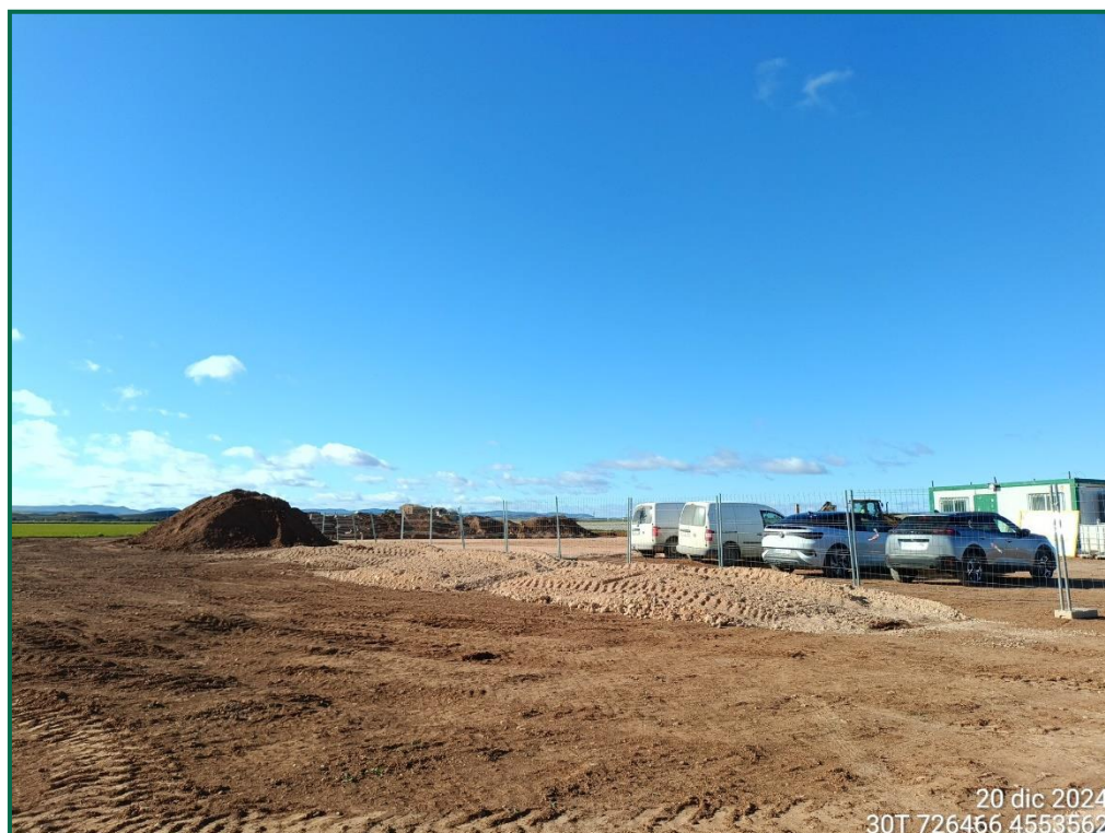
Fotografía 3. Vallado perimetral SET LA ESTANCA.
