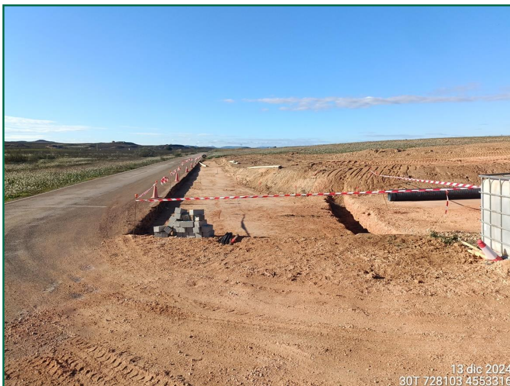
Fotografía 8. Entronque con carretera TE-35.
