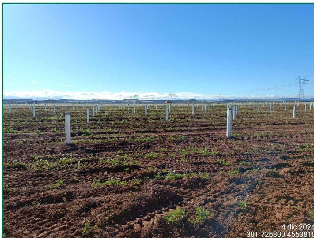
Fotografía 6. Superficie de la zona de hincado.
