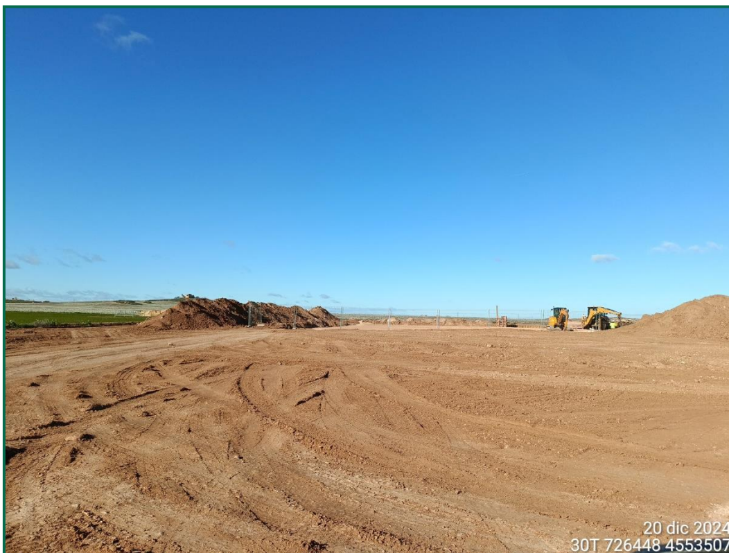
Fotografía 5. Tierra vegetal acopiada junto a zona de obras de la SET LA ESTANCA.
