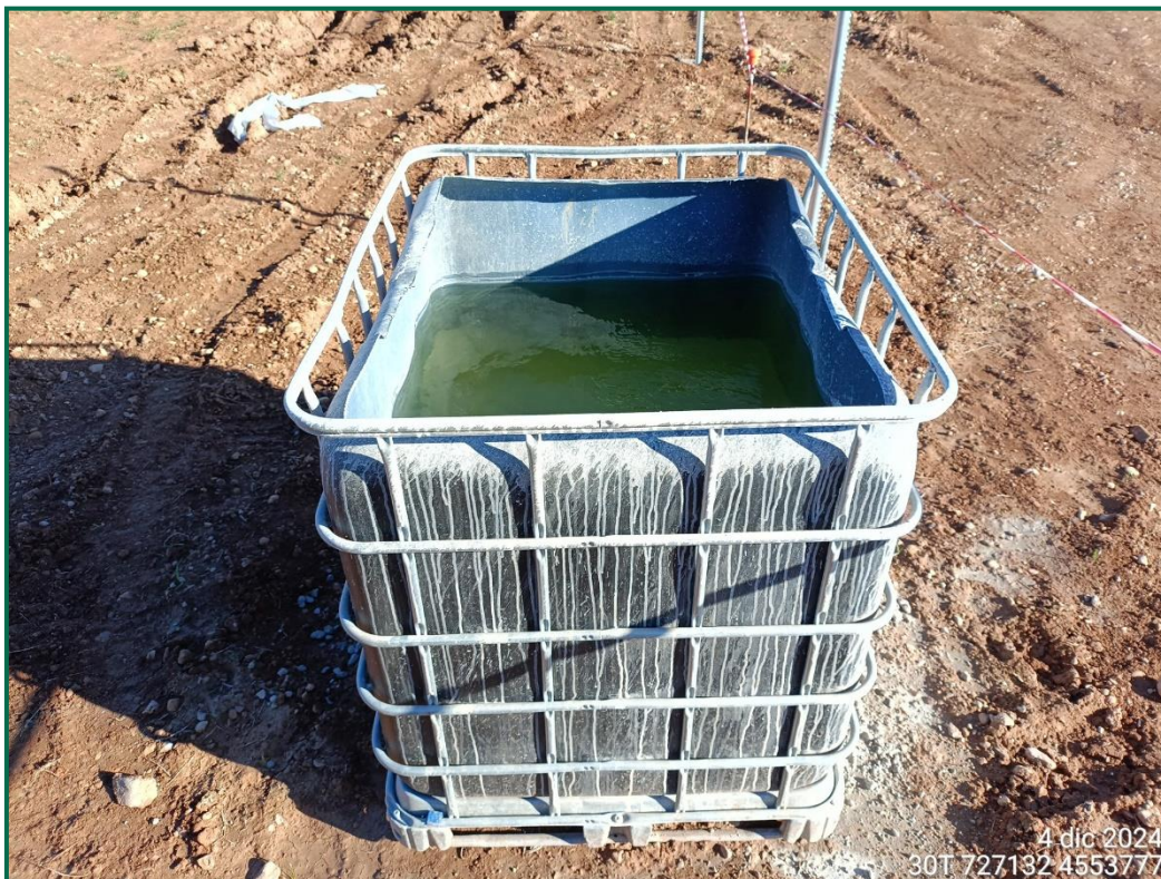
Fotografía 19. Contenedor para lavado de canaletas.
