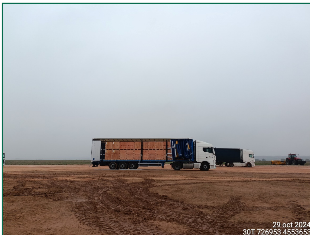
Fotografía 2. Superficie de la zona de acopios.
