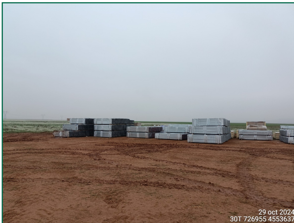
Fotografía 1. Superficie de la zona de acopios.
