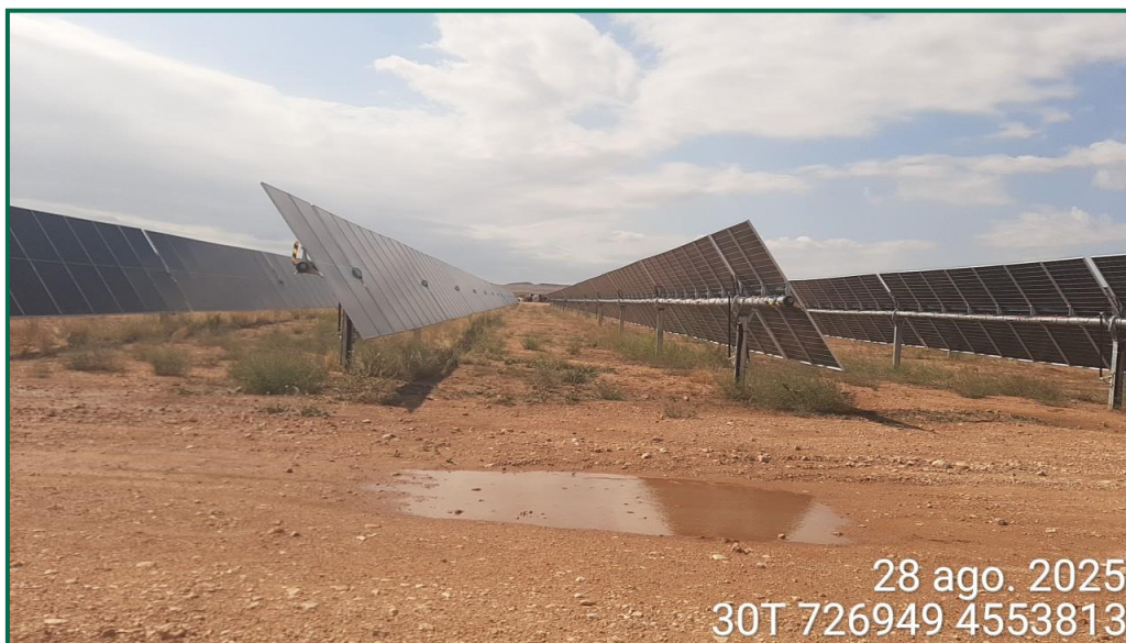
Fotografía 4. Superficie de la zona de hincado.
