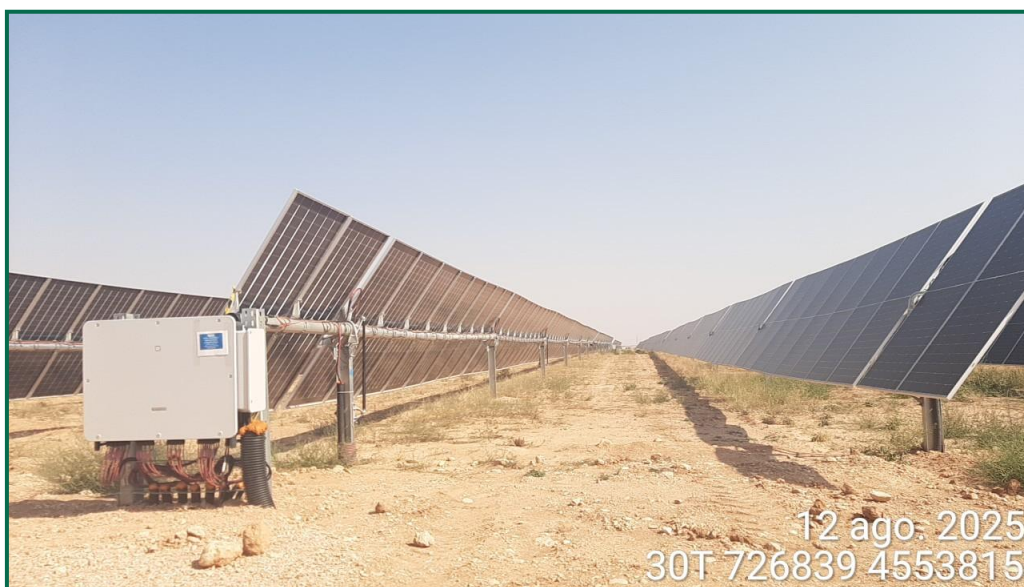
Fotografía 5. Superficie de la zona de hincado.
