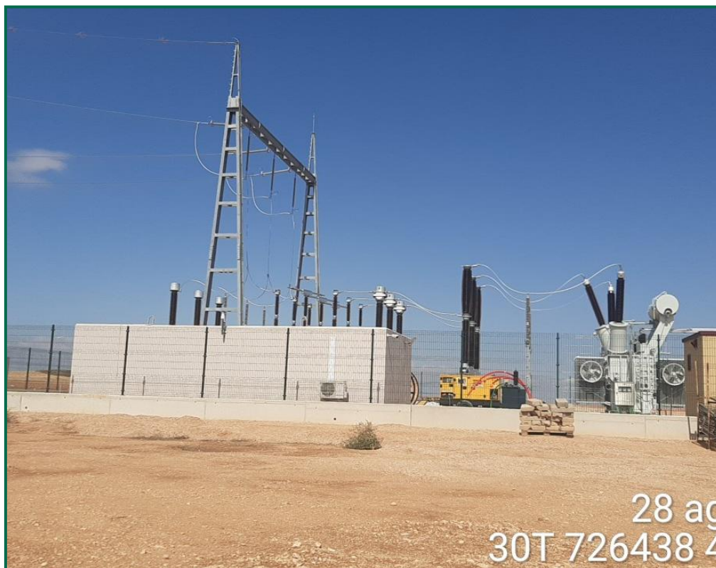
Fotografía 2. Vallado perimetral definitivo SET LA ESTANCA.
