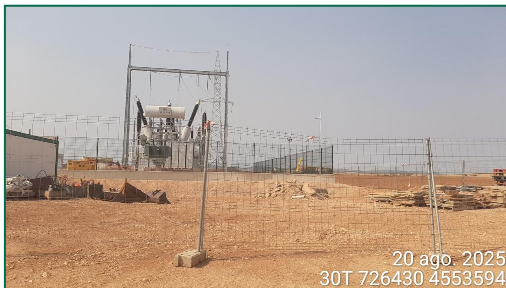
Fotografía 3. Vallado provisional SET LA ESTANCA.
