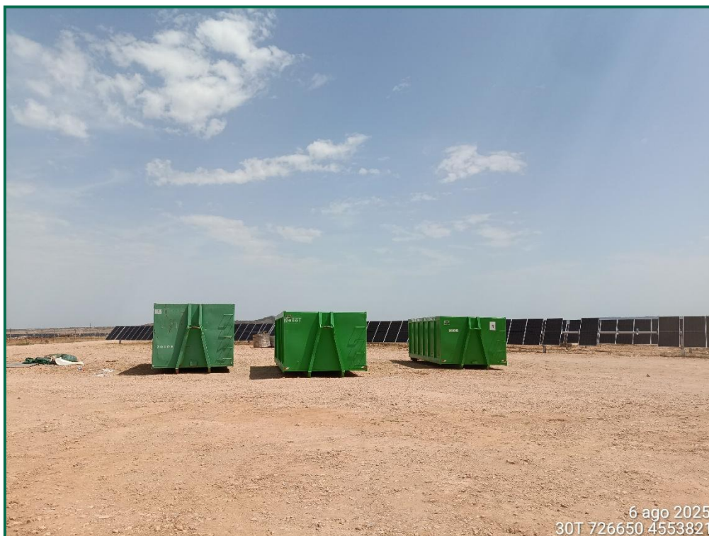
Fotografía 9. Punto limpio de residuos inertes.
