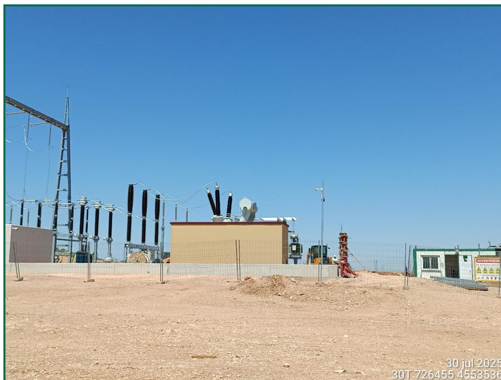
Fotografía 3. Vallado provisional SET LA ESTANCA.
