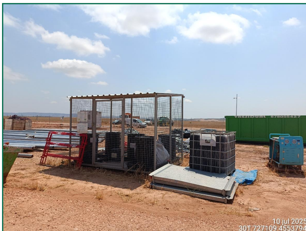
Fotografía 12. Punto limpio para residuos peligrosos.
