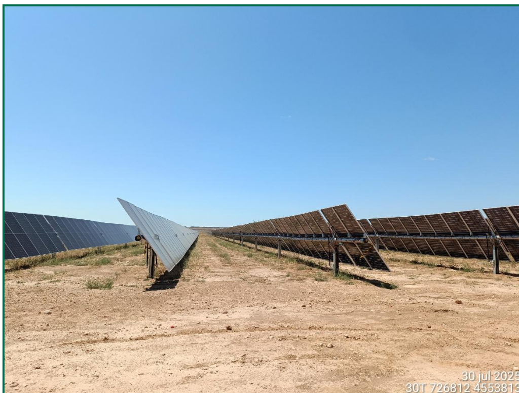
Fotografía 6. Superficie de la zona de hincado.
