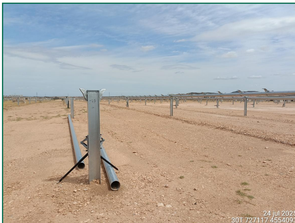
Fotografía 8. Superficie de la zona de hincado con movimiento de tierra y aporte de tierra vegetal.
