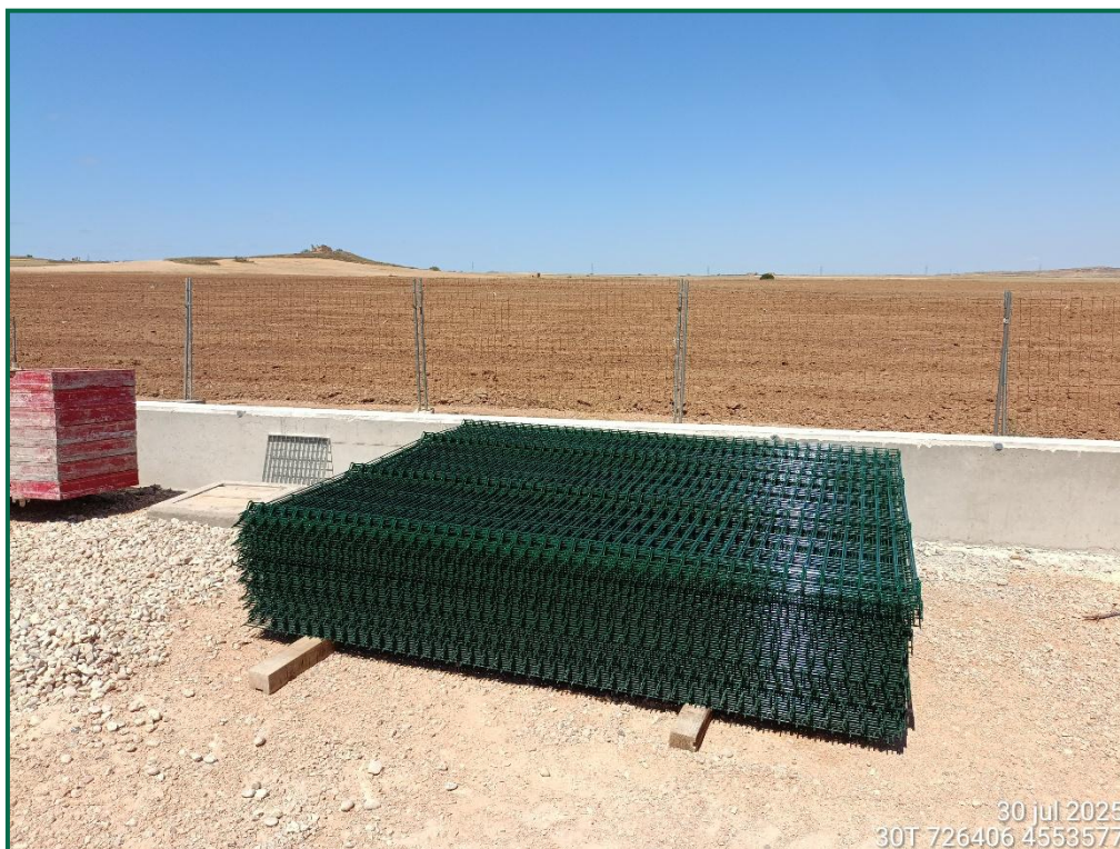
Fotografía 4. Vallado definitivo preparado para instalarse en SET LA ESTANCA.
