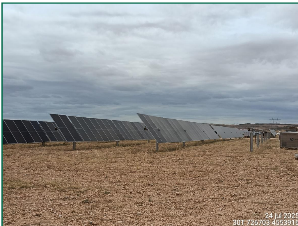
Fotografía 7. Superficie de la zona de hincado.
