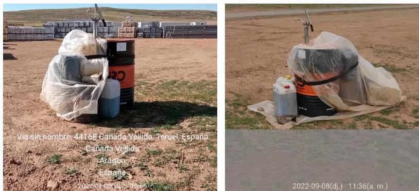
*Ilustración 9. Colocación de plástico protector bajo bidones de gasolina.*
