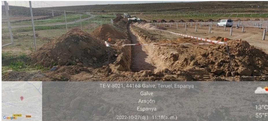
Ilustración 13. Zanjas de media tensión en zona 2 balizadas
