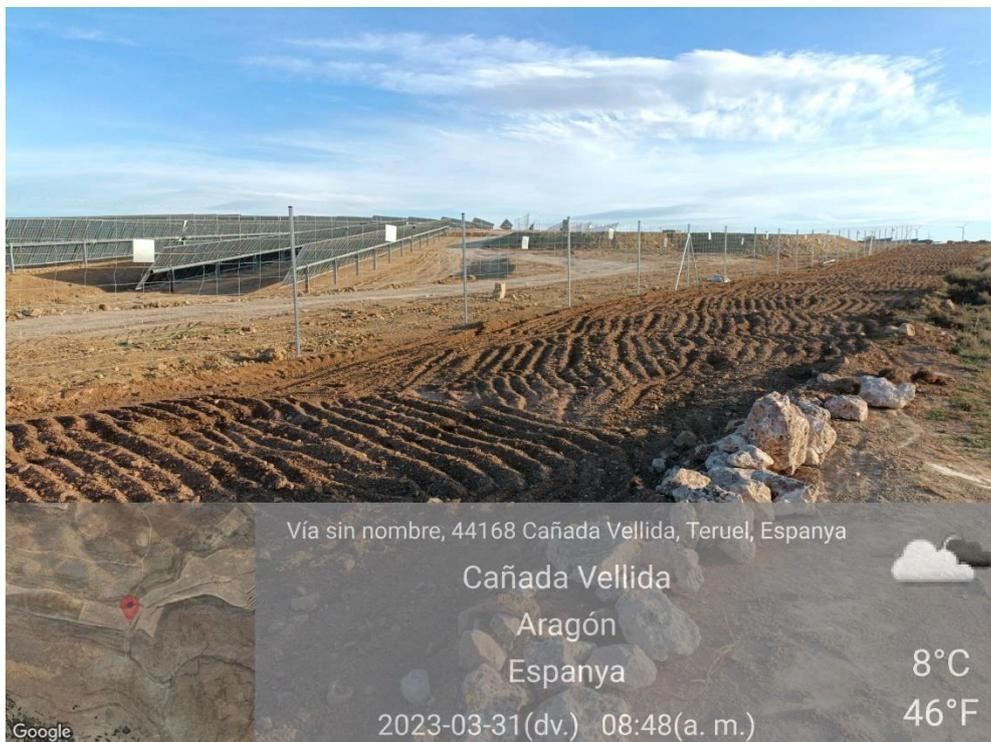
Ilustración 25. Arado y separación del vial restaurado de la zona 5
