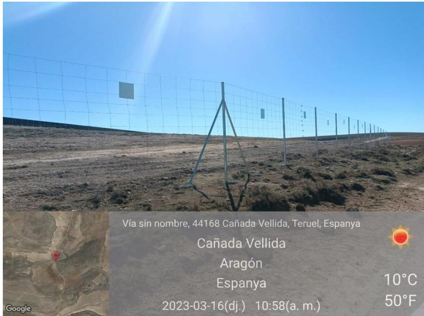
Ilustración 26. Placas anticollisión en el vallado
