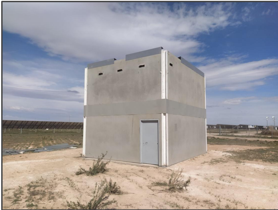
Fotografía 7. Exterior del primillar de nueva construcción.
