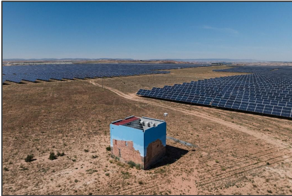
Fotografía 10. Exterior del primillar, pintado.
