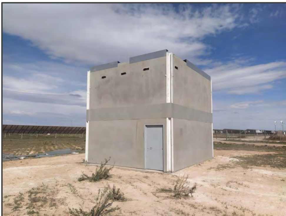
Fotografía 9. Exterior del primillar de nueva construcción.
