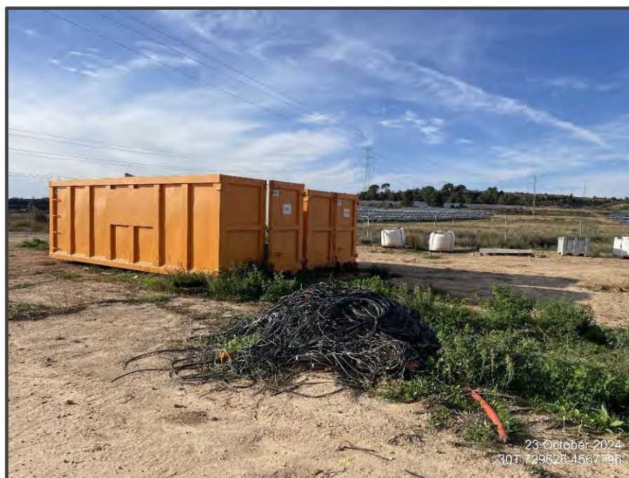
Fotografía 33. Zona de acopio de placas solares deterioradas
