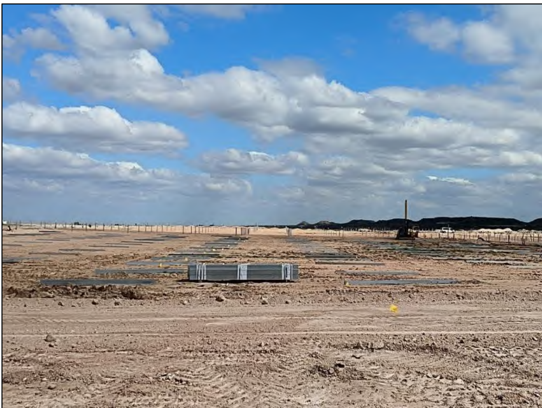
Figura nº 7. Trabajos de hincado en el IT53 de la planta “Híjar 1”.
