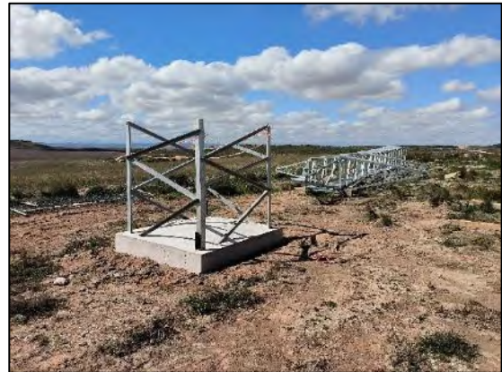
Figura nº 43. Situación Apoyo T14
