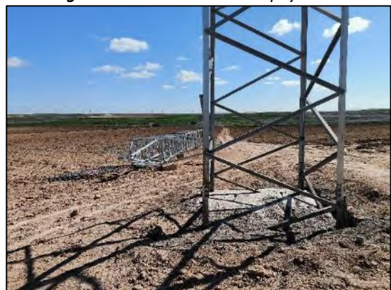
Figura nº 37. Situación Apoyo T20
