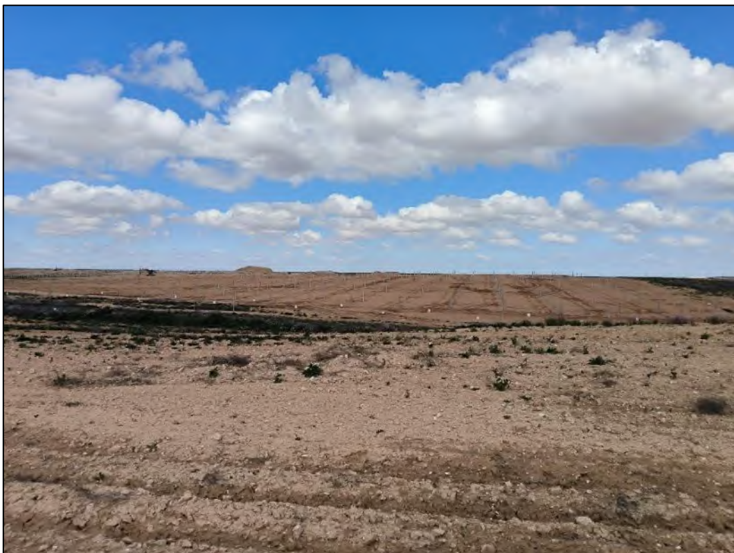
Figura nº 3. Trabajos de hincado completados en el ITS4 de la planta "Híjar 1".
