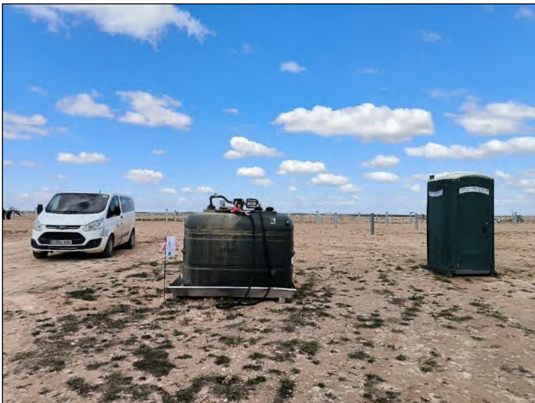
Figura nº 71. Control de vertidos accidentales de depósitos de combustible mediante cubetas de retención
