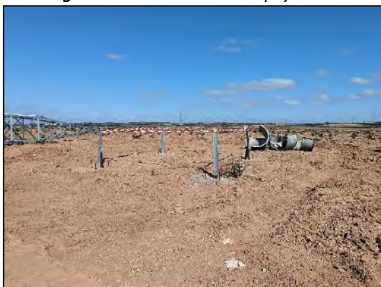
Figura nº 36. Situación Apoyo T21
