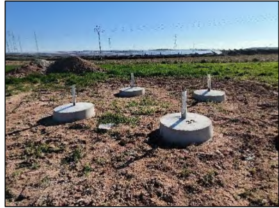
Figura nº 25. Situación Apoyo T32
