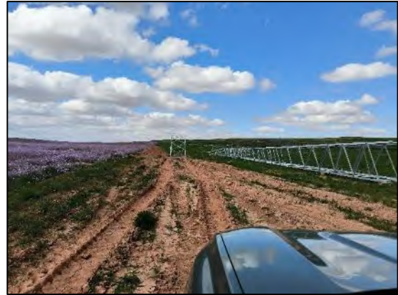
Figura nº 49. Situación Apoyo T08
