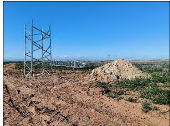
Figura nº 27. Situación Apoyo T30
