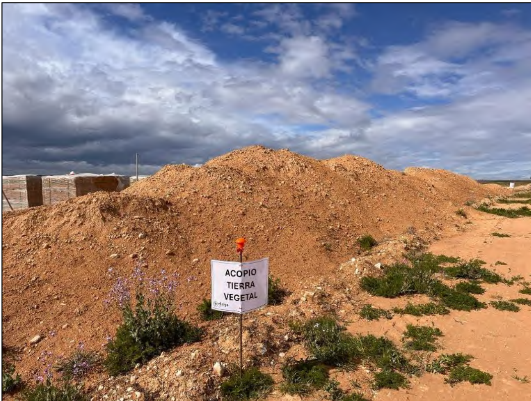
Figura nº 80. Acopio de tierra vegetal junto acopio de módulos.
