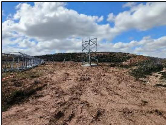
Figura nº 46. Situación Apoyo T11
