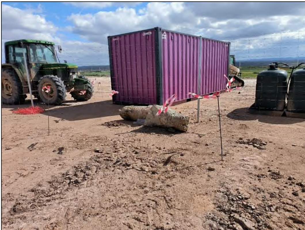
Figura nº 109. Depósito temporal de los mojones en acopio principal, hasta su traslado definitivo.
