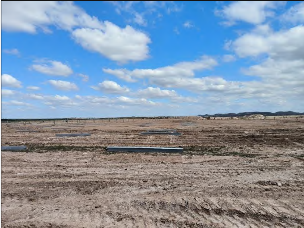
Figura nº 8. Trabajos de hincado en el ITS2 de la planta “Híjar 1”.
