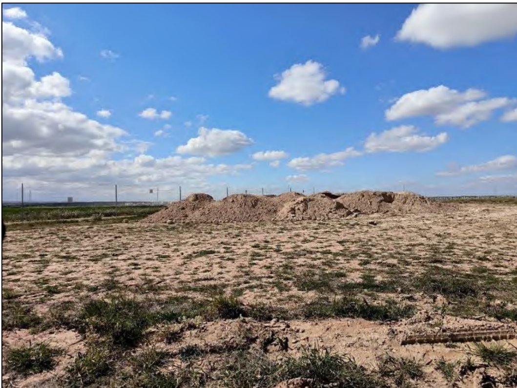
Figura nº 82. Acopio de tierra vegetal junto al vallado en el ITS6.
