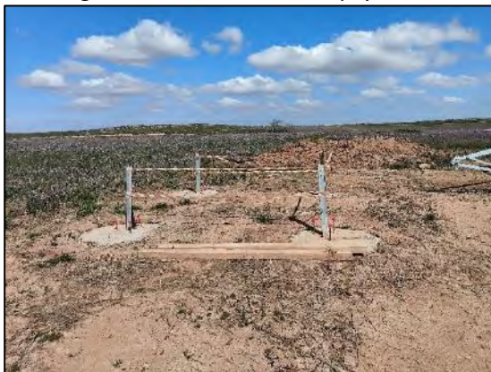
Figura nº 44. Situación Apoyo T13
