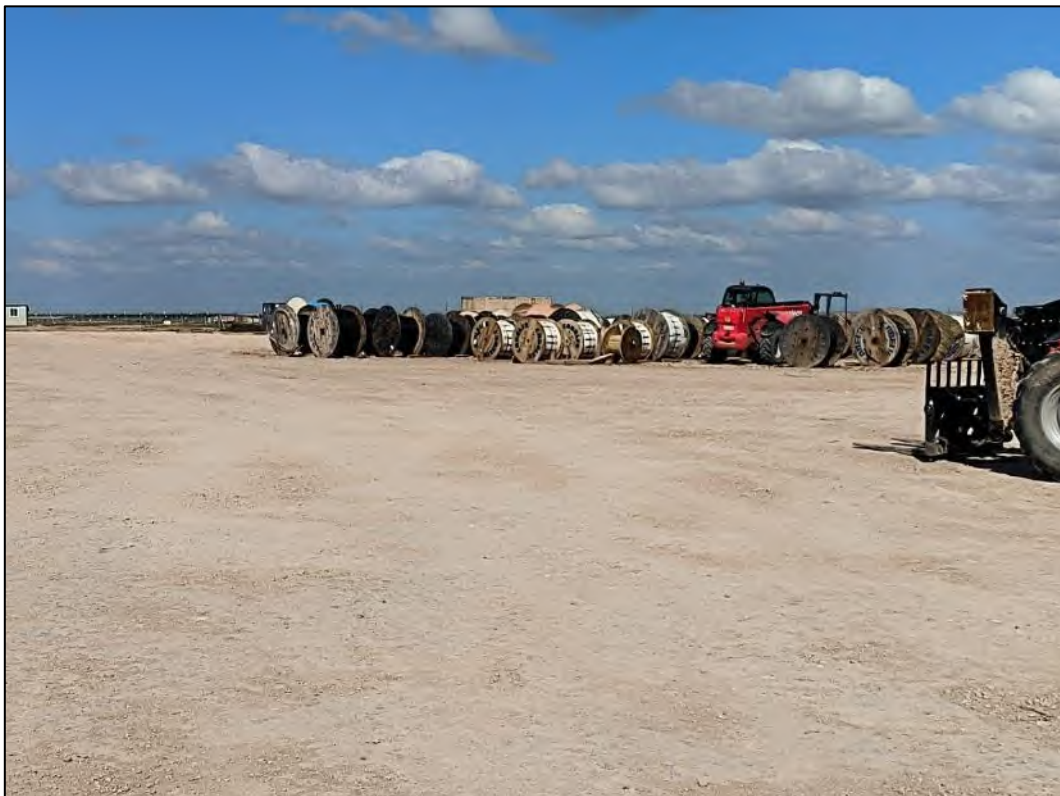
Figura nº 17. Almacén de cableado en acopio principal.
