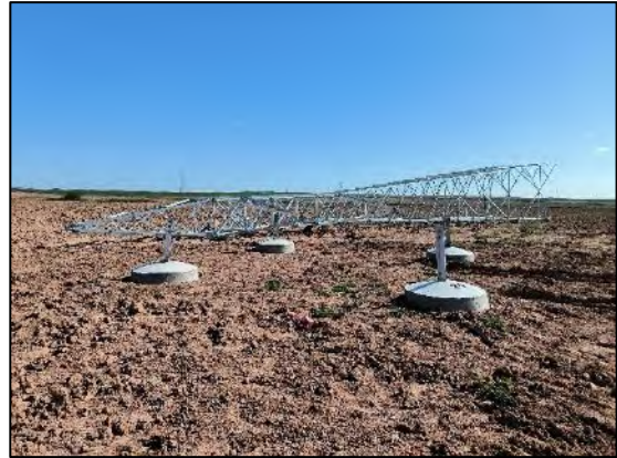
Figura nº 33. Situación Apoyo T24
