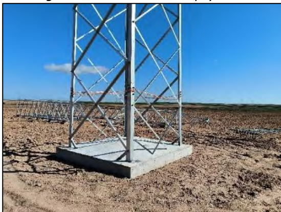
Figura nº 34. Situación Apoyo T23
