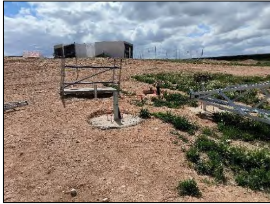
Figura nº 56. Situación Apoyo T01
