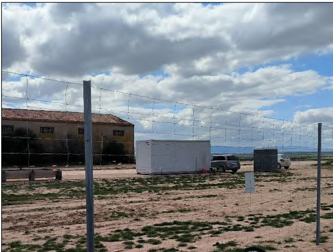
Figura nº 1. Punto de control de acceso a planta
