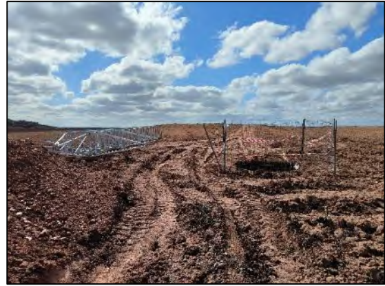
Figura nº 41. Situación Apoyo T16
