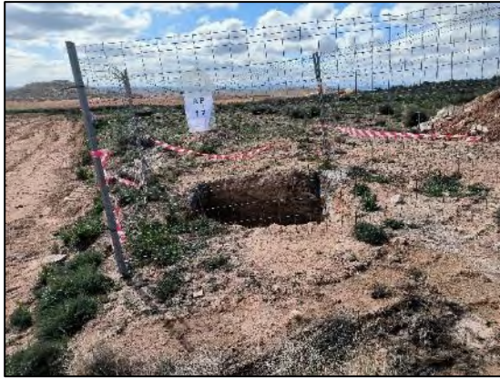
Figura nº 40. Situación Apoyo T17
