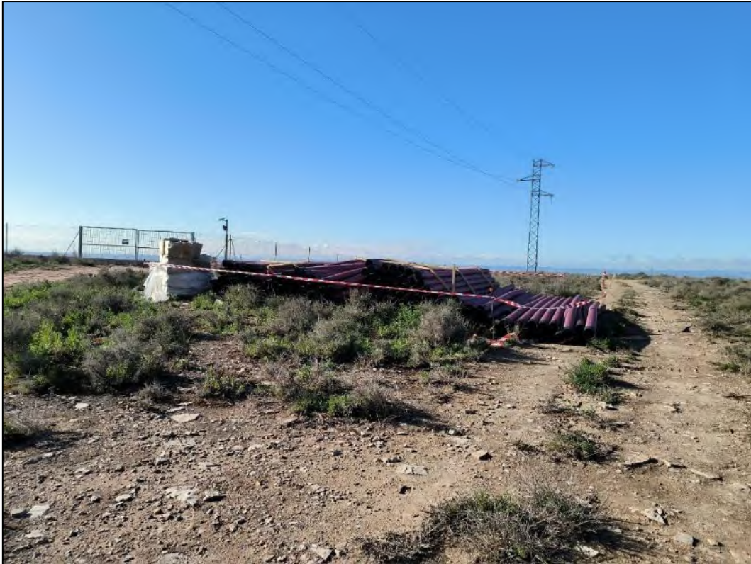
Figura nº 20. Acopios destinados a la instalación del tramo subterráneo de la línea eléctrica
