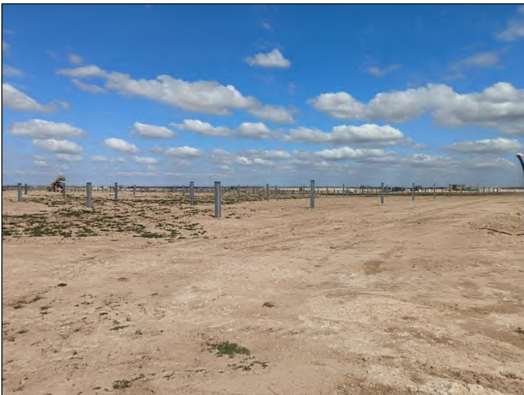
Figura nº 5. Trabajos de hincado completados en el ITS6 de la planta "Híjar 1".
