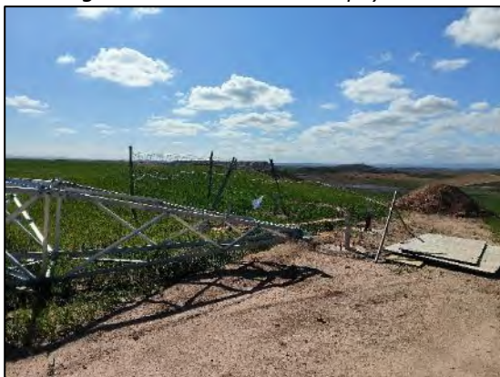
Figura nº 38. Situación Apoyo T19
