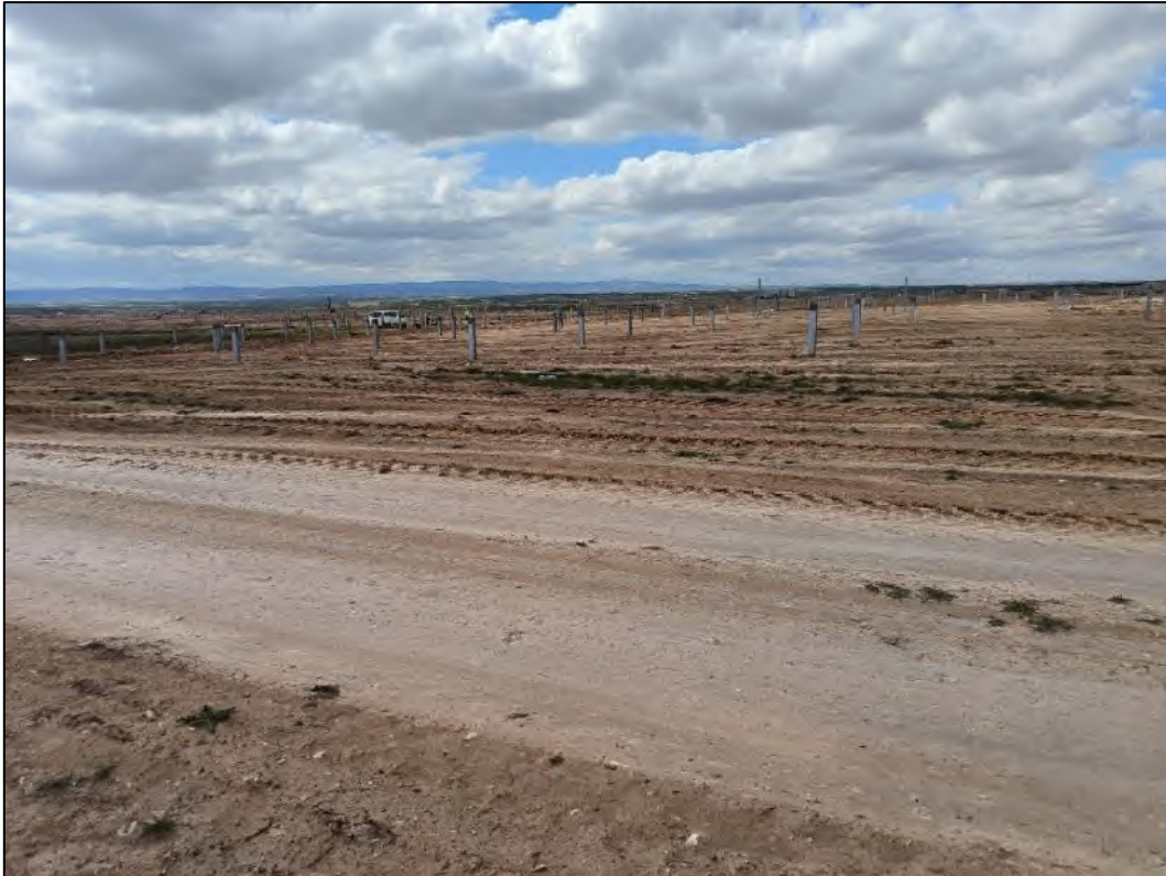
Figura nº 4. Trabajos de hincado completados en el ITS1 de la planta "Híjar 1".
