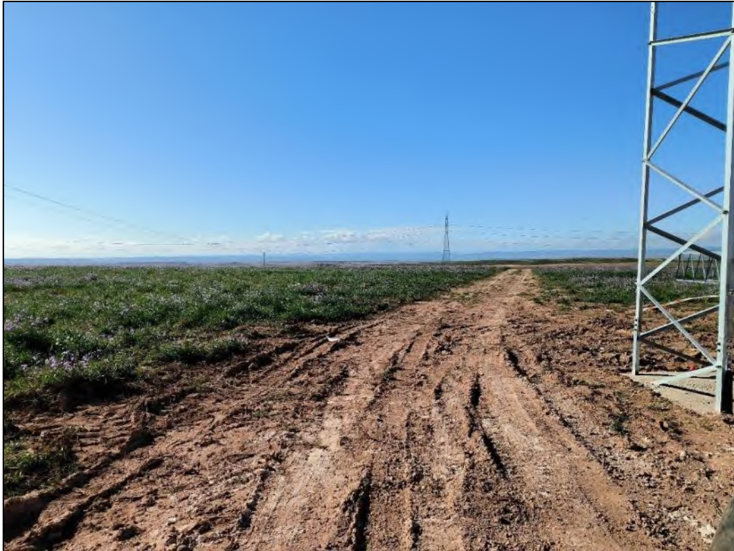
Figura nº 69. Camino de acceso sobre superficie agrícola entre apoyos de la línea eléctrica.
