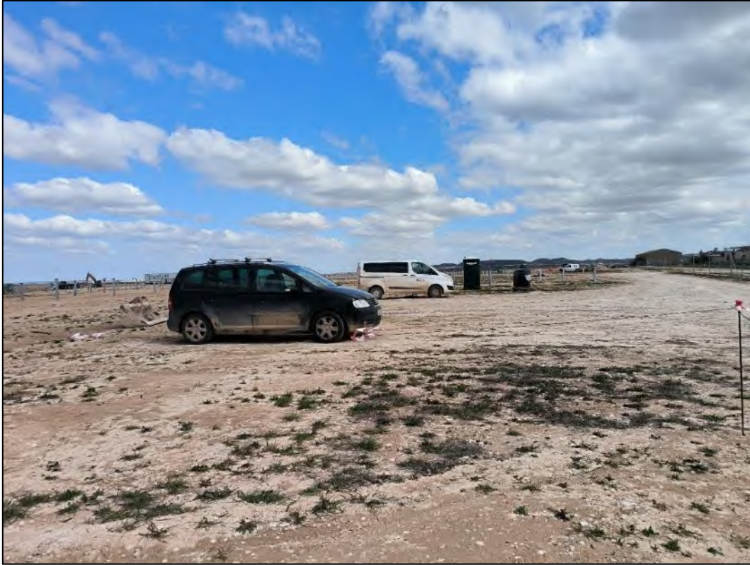
Figura nº 65. Estacionamiento de vehículos de obra, dentro de la superficie de la planta.
