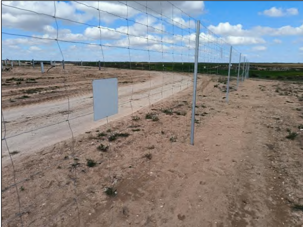
Figura nº 83. Placas metálicas instaladas sobre el vallado de acuerdo a DIA.
