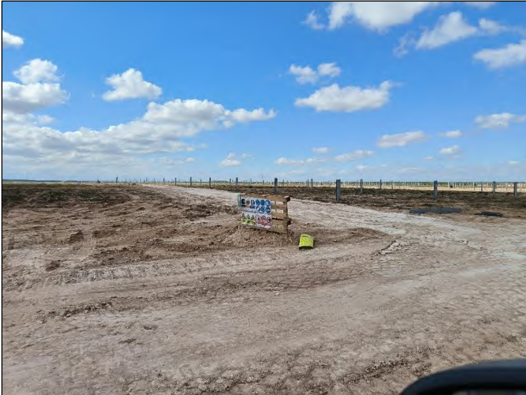
Figura nº 67. Acondicionamiento de camino interior en la planta.
