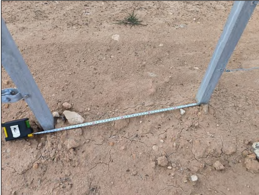
Figura nº 85. Detalle de paso de fauna de 53 cm de ancho por 79cm de alto en el vallado.
