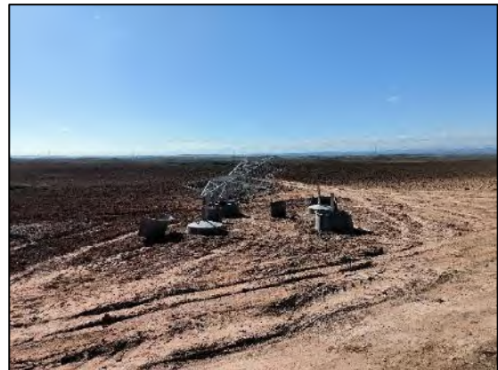
Figura nº 31. Situación Apoyo T26
