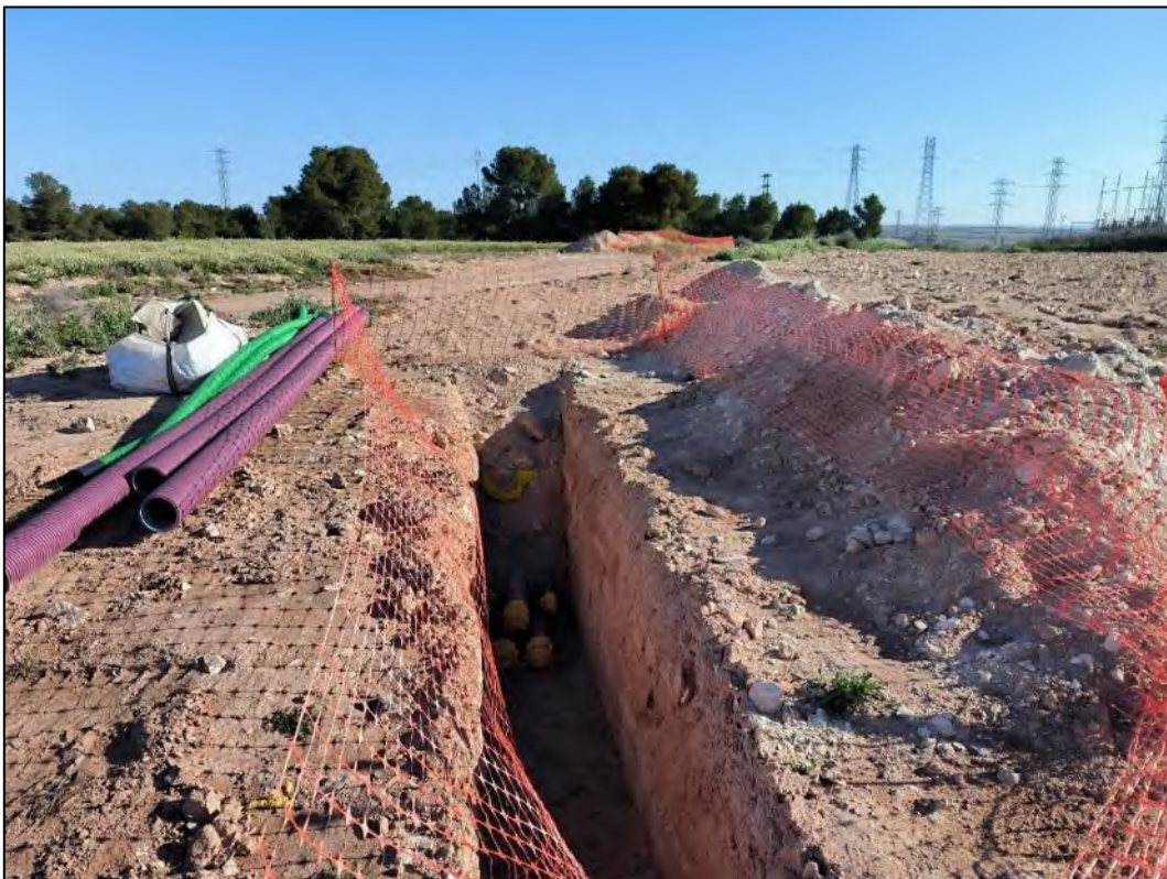
Figura nº 21. Trabajos de instalación del tramo subterráneo de la línea eléctrica
