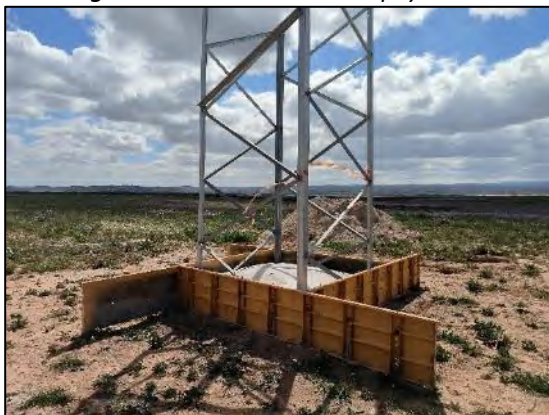
Figura nº 50. Situación Apoyo T07
