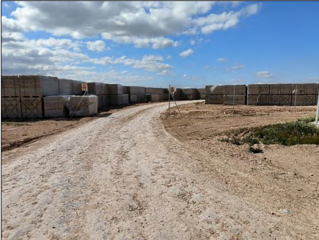
Figura nº 18. Acopio de módulos fotovoltaicos.
