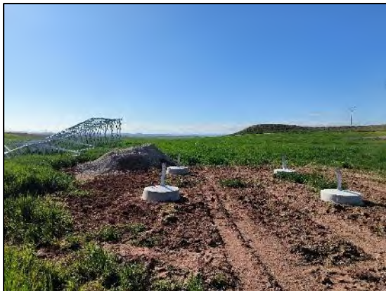
Figura nº 30. Situación Apoyo T27
