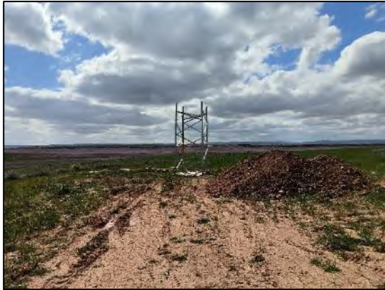
Figura nº 48. Situación Apoyo T09
