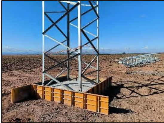
Figura nº 32. Situación Apoyo T25
