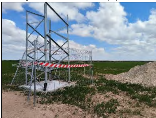
Figura nº 54. Situación Apoyo T03
