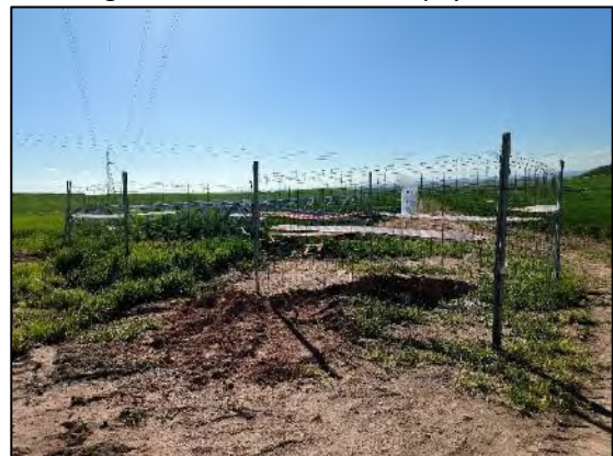
Figura nº 29. Situación Apoyo T28
