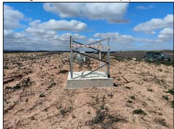
Figura nº 51. Situación Apoyo T06
