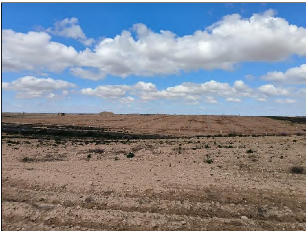
Figura nº 87. Trabajos de hincado finalizados en el ITS4 más próxima al corral de Torre de Valdemaguín.
