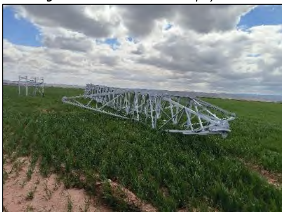
Figura nº 52. Situación Apoyo T05
