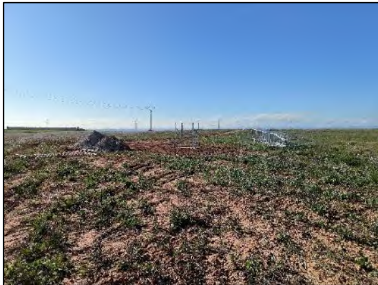
Figura nº 26. Situación Apoyo T31
