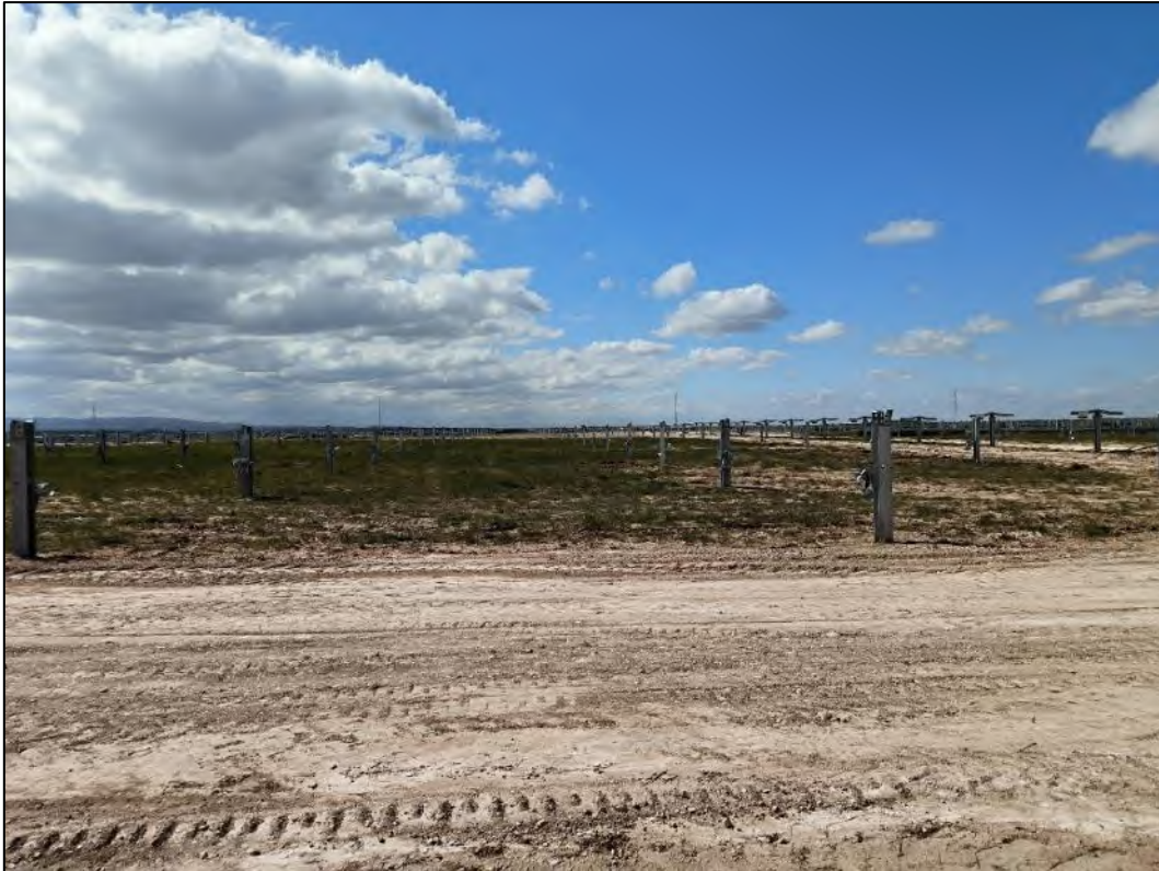
Figura nº 6. Trabajos de instalación de soportes de paneles fotovoltaicos en el IT55.
