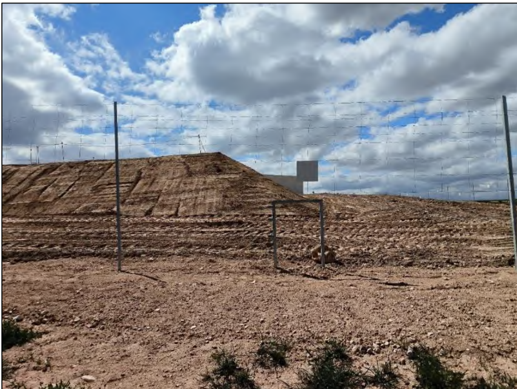
Figura nº 19. Instalación del vallado perimetral de acuerdo al condicionado de la DIA en Híjar 1
