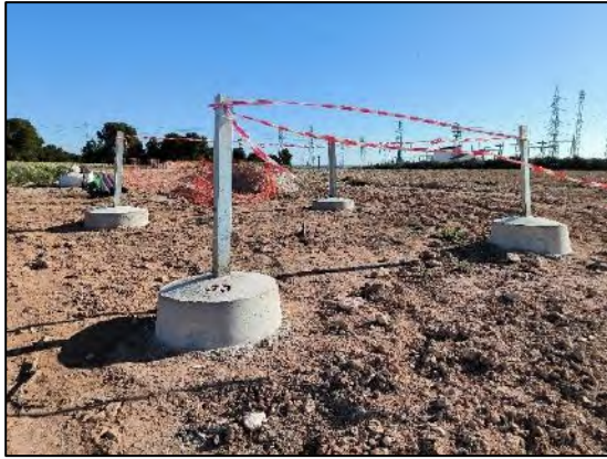
Figura nº 24. Situación Apoyo T33
