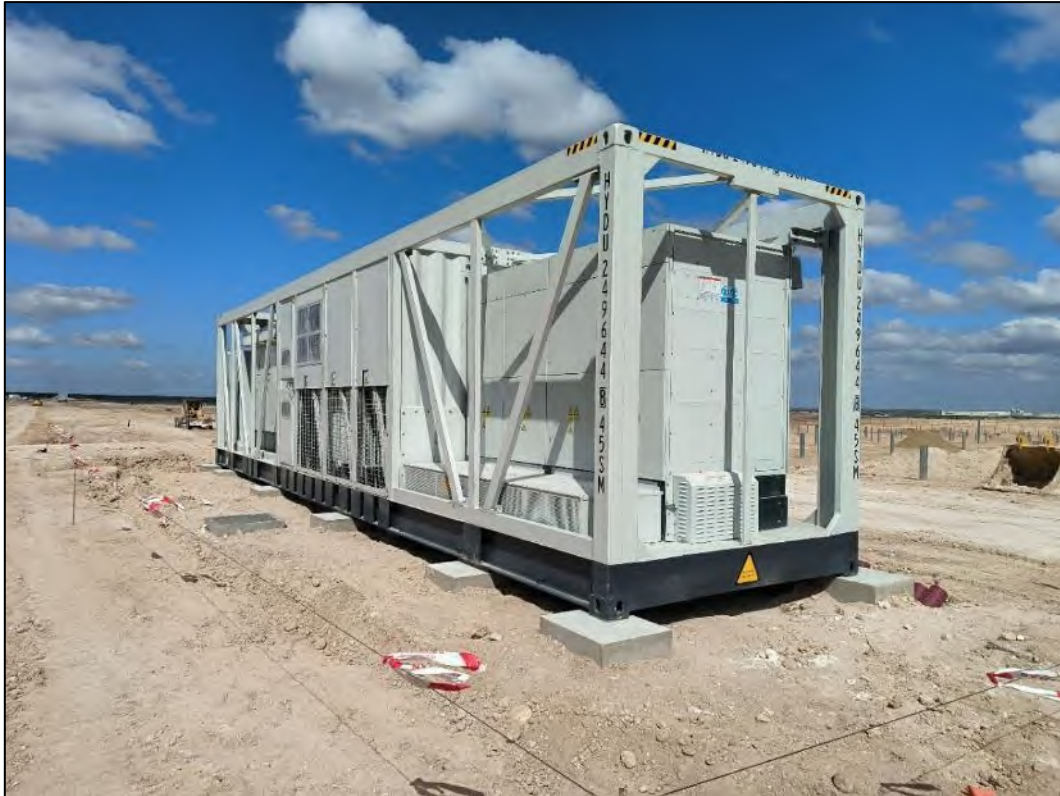
Figura nº 2. Instalación de centro de transformación.
