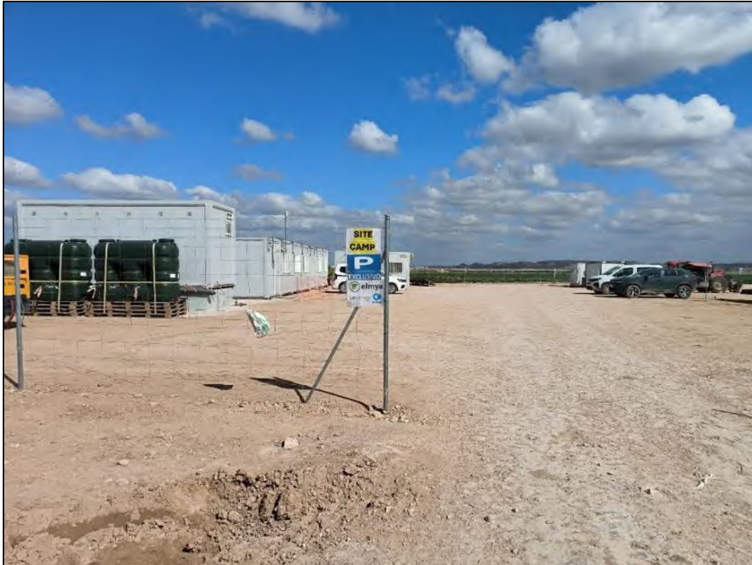
Figura nº 16. Zona de acceso a estacionamiento en zona de oficinas.
