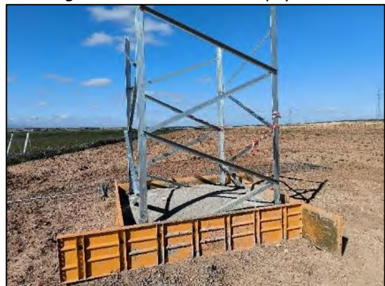
Figura nº 35. Situación Apoyo T22
