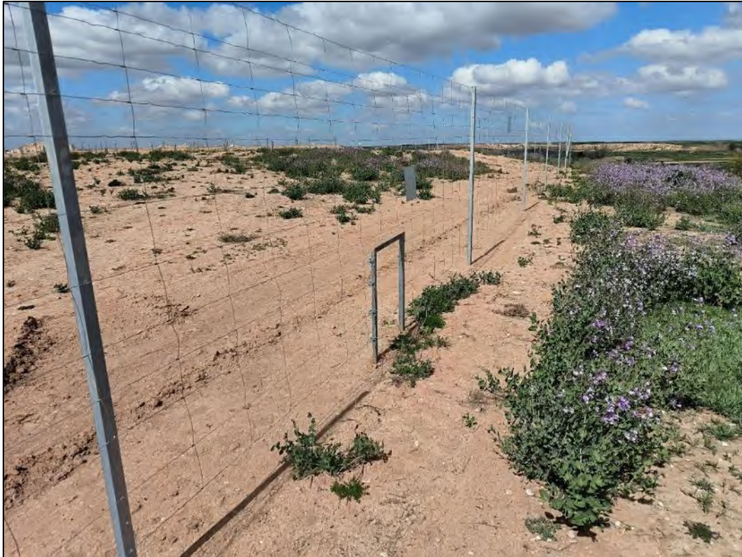
Figura nº 10. Instalación del vallado perimetral de acuerdo al condicionado de la DIA.
