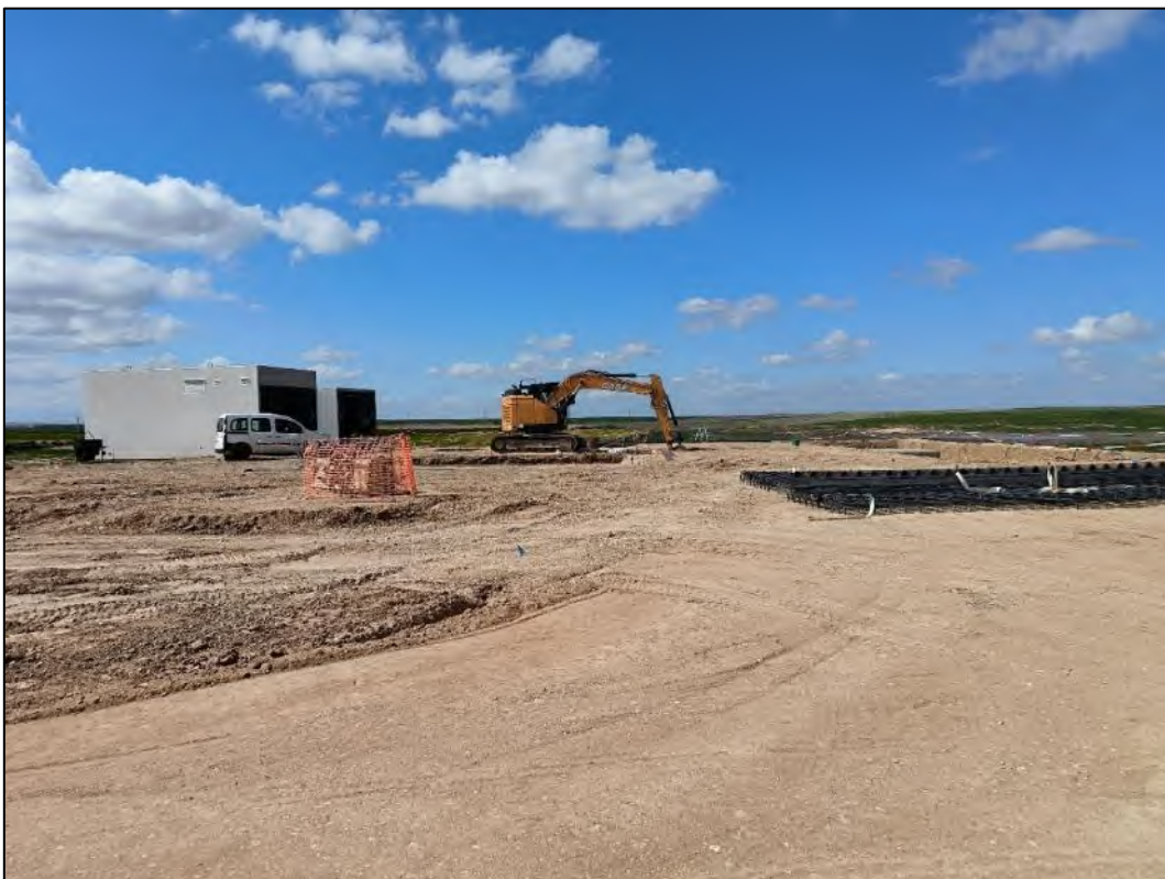
Figura nº 9. Trabajos de instalación del SET de evacuación.
