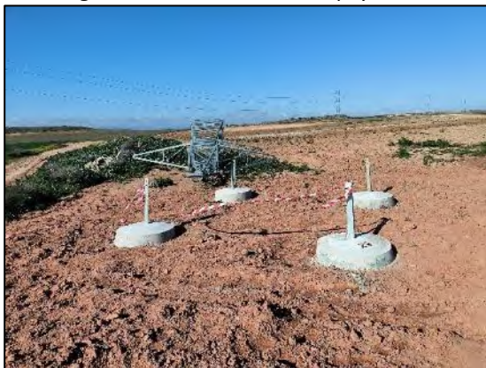
Figura nº 28. Situación Apoyo T29
