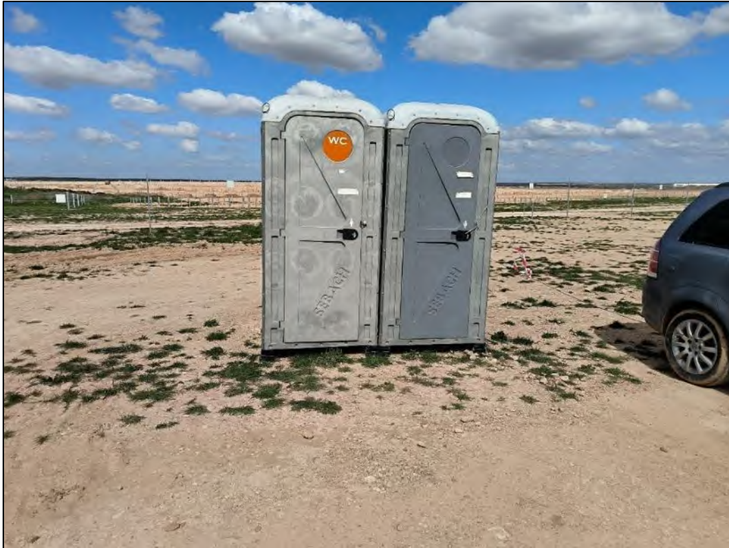
Figura nº 70. Servicios sanitarios portátiles en el perímetro de obra. Híjar 2.
