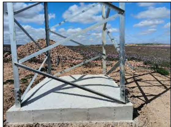
Figura nº 45. Situación Apoyo T12
