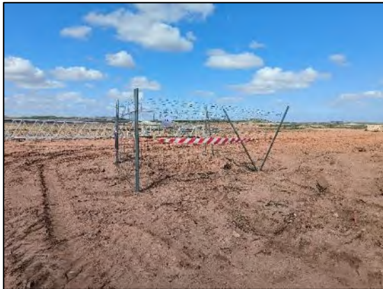
Figura nº 42. Situación Apoyo T15
