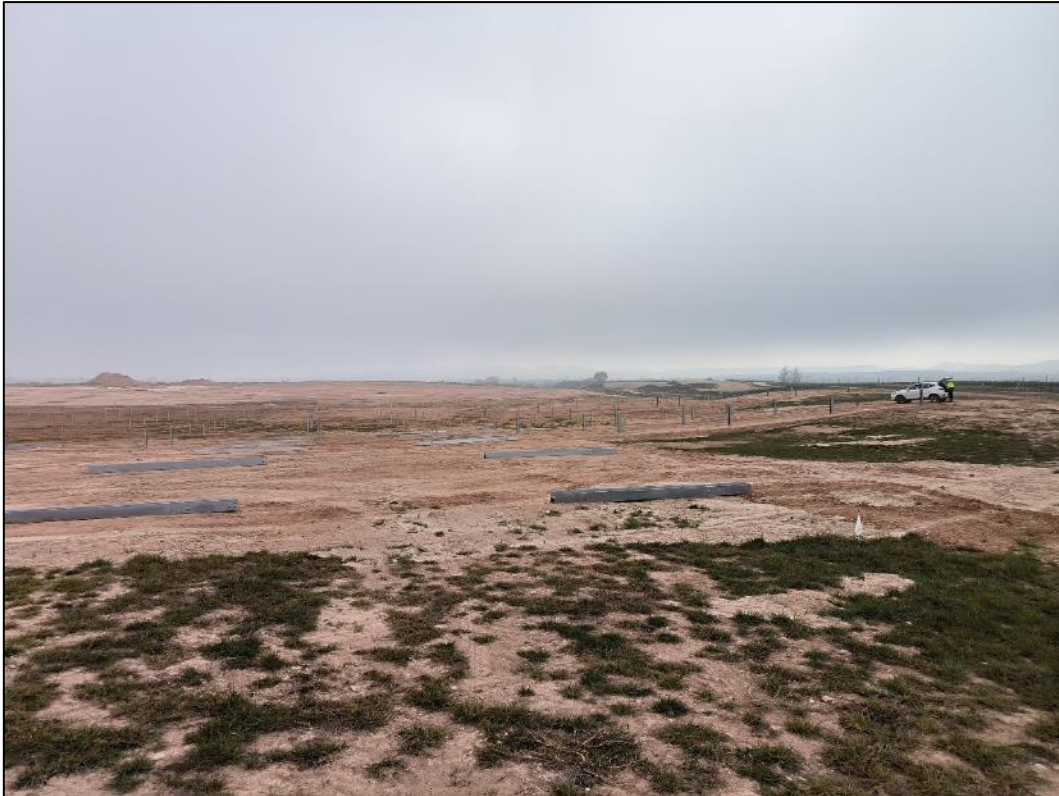
Figura nº 58. Trabajos de hincado en el ITS4 más próxima al corral de Torre de Valdemagúin.
