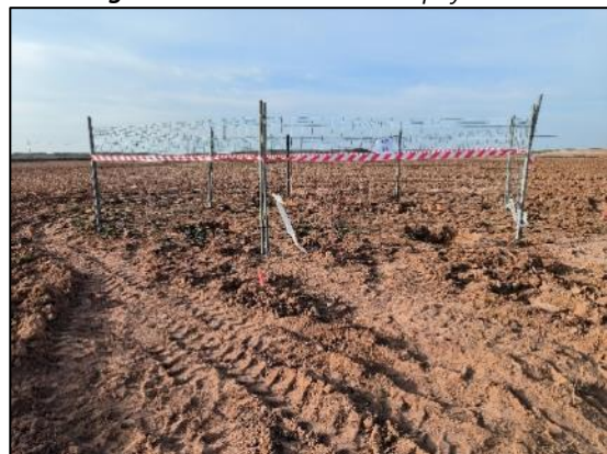
Figura nº 28. Situación Apoyo T24
