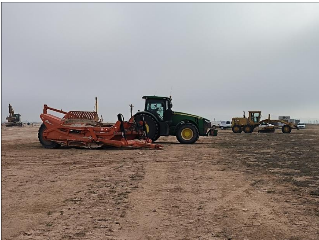
Figura nº 42. Estacionamiento de vehículos de obra, dentro de la superficie de la planta.
