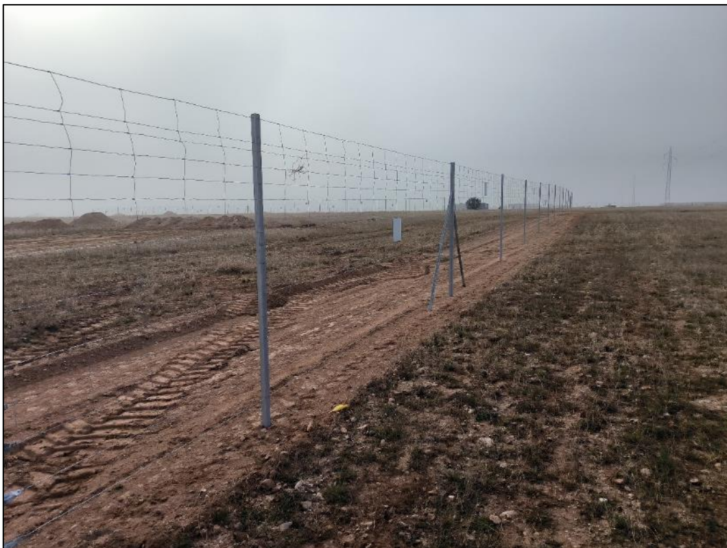
Figura nº 56. Placas metálicas instaladas sobre el vallado de acuerdo a DIA.
