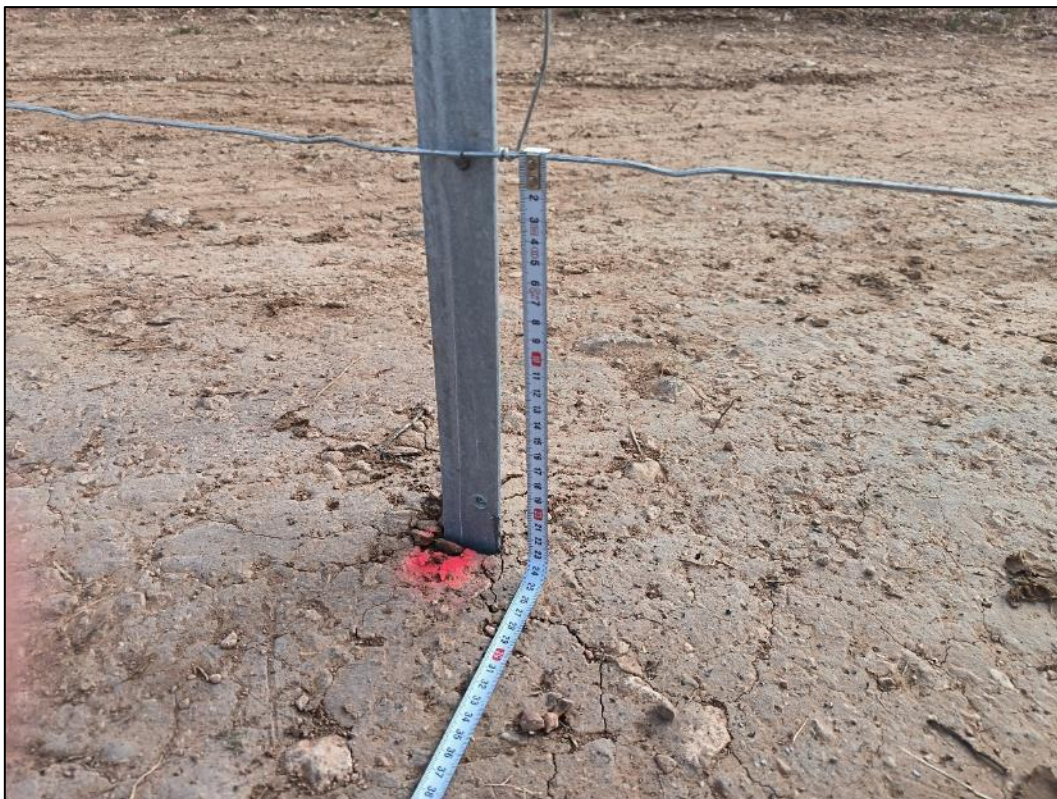
Figura nº 57. Detalle de espacio libre desde el suelo de 20 cm en el vallado.
