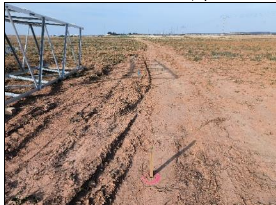
Figura nº 22. Situación Apoyo T30
