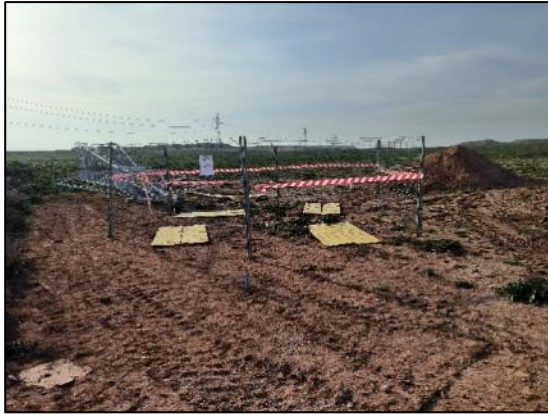
Figura nº 23. Situación Apoyo T29
