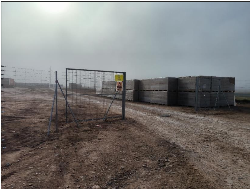
Figura nº 6. Zona de acopio de módulos.
