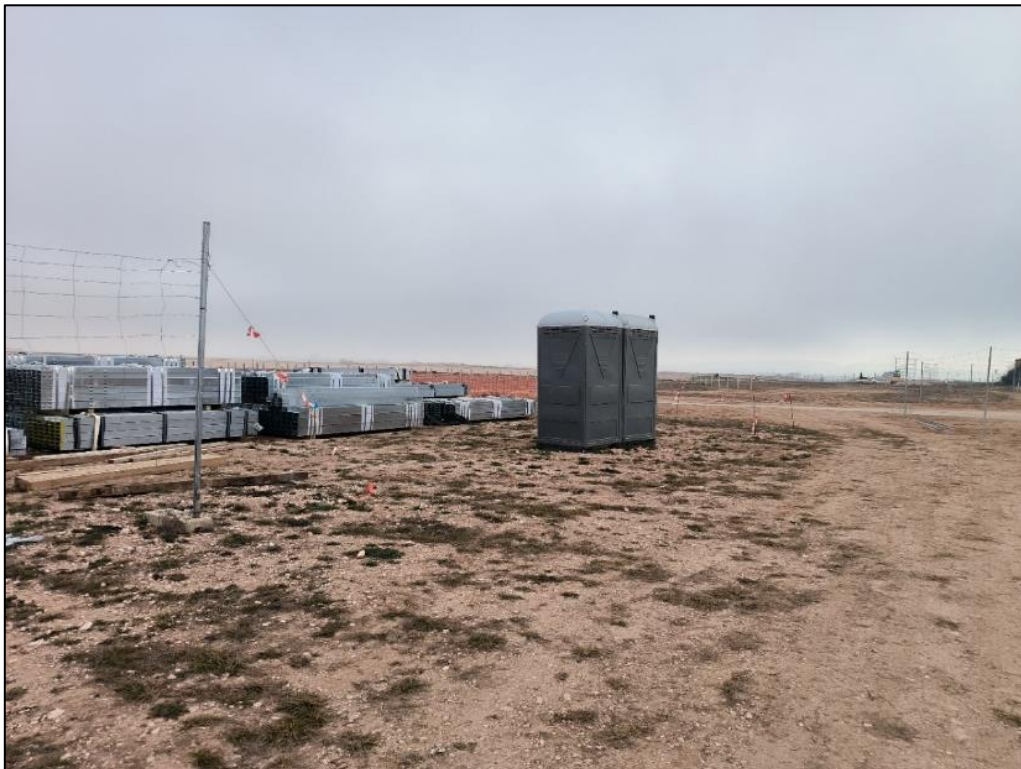
Figura nº 47. Servicios sanitarios portátiles en el perímetro de obra. Híjar 2.
