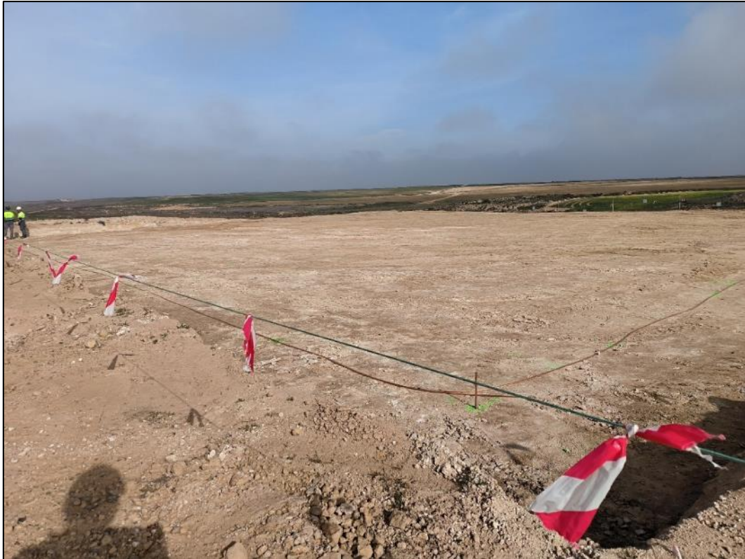
Figura nº 3. Trabajos de preparación superficie del SET de evacuación.
