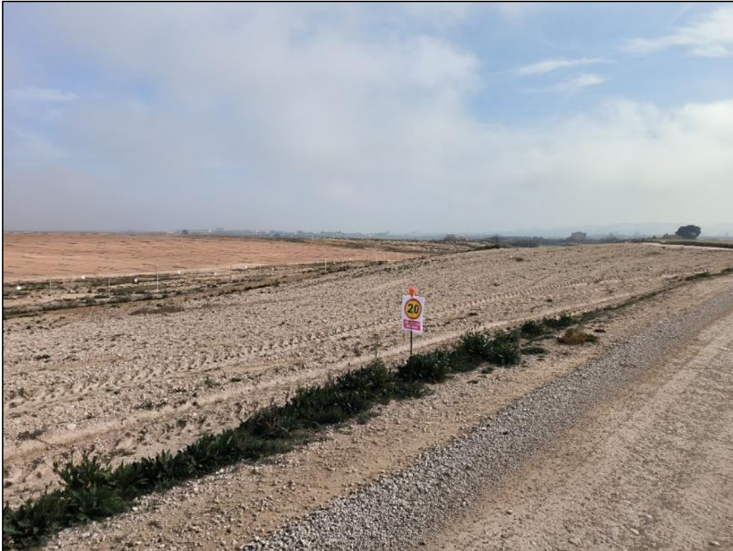
Figura nº 41. Señalización de límite de velocidad en camino de Vinaceite.
