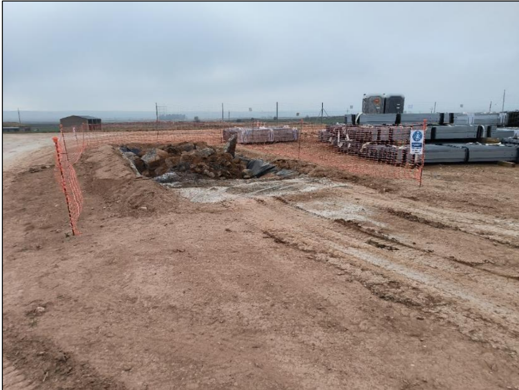
Figura nº 49. Fosa impermeabilizada de lavado de hormigón. Zona de acceso a planta.
