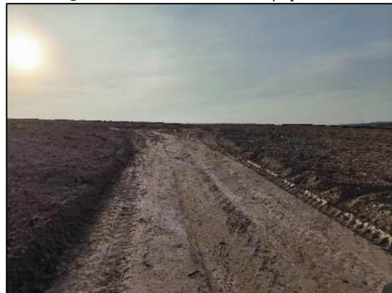
Figura nº 30. Situación Apoyo T20
