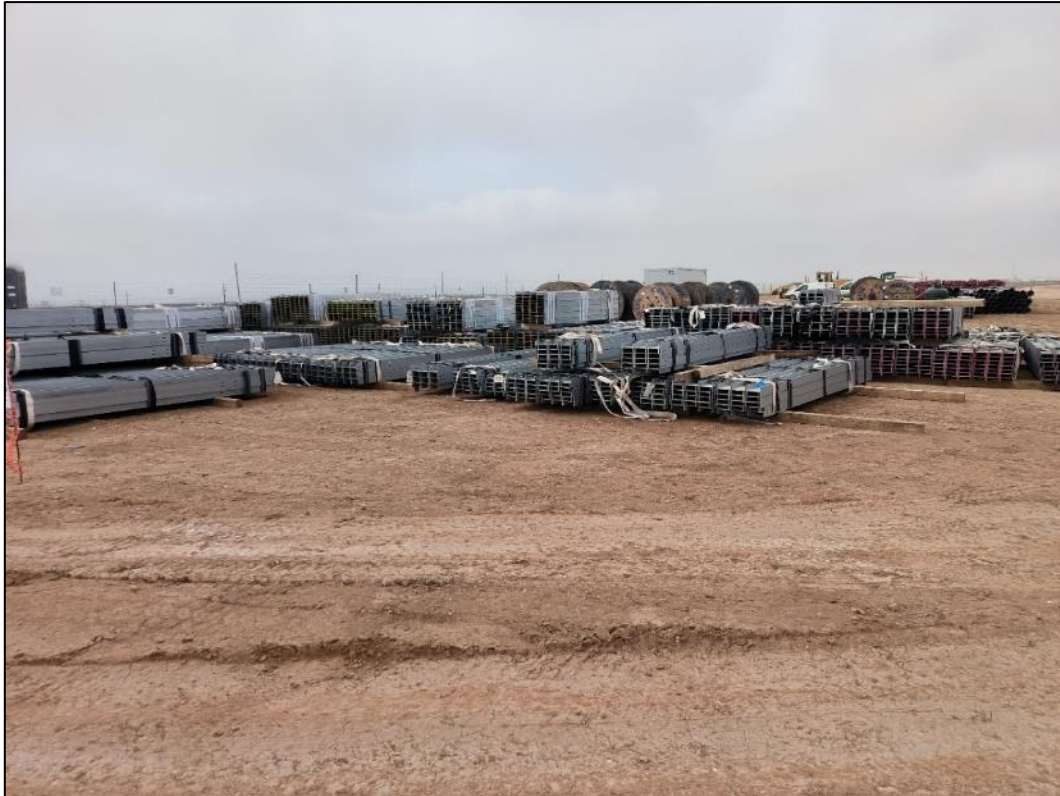
Figura nº 13. Acopio temporal de soportes de módulos fotovoltaicos en zona de planta.
