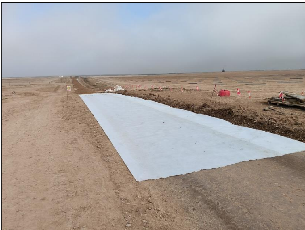
Figura nº 44. Acondicionamiento de camino interior en la planta.
