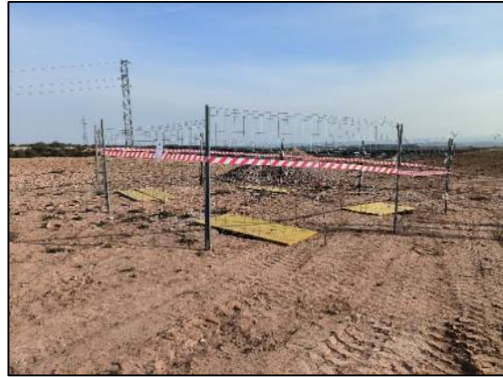
Figura nº 16. Situación Apoyo T33
