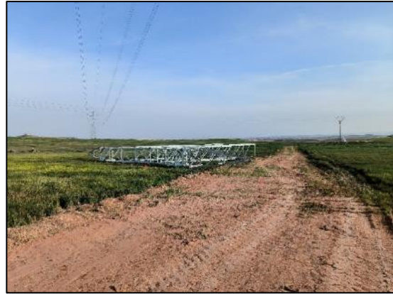
Figura nº 24. Situación Apoyo T28
