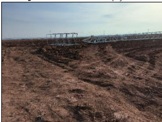
Figura nº 27. Situación Apoyo T25
