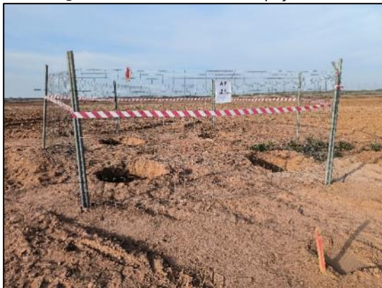
Figura nº 29. Situación Apoyo T21
