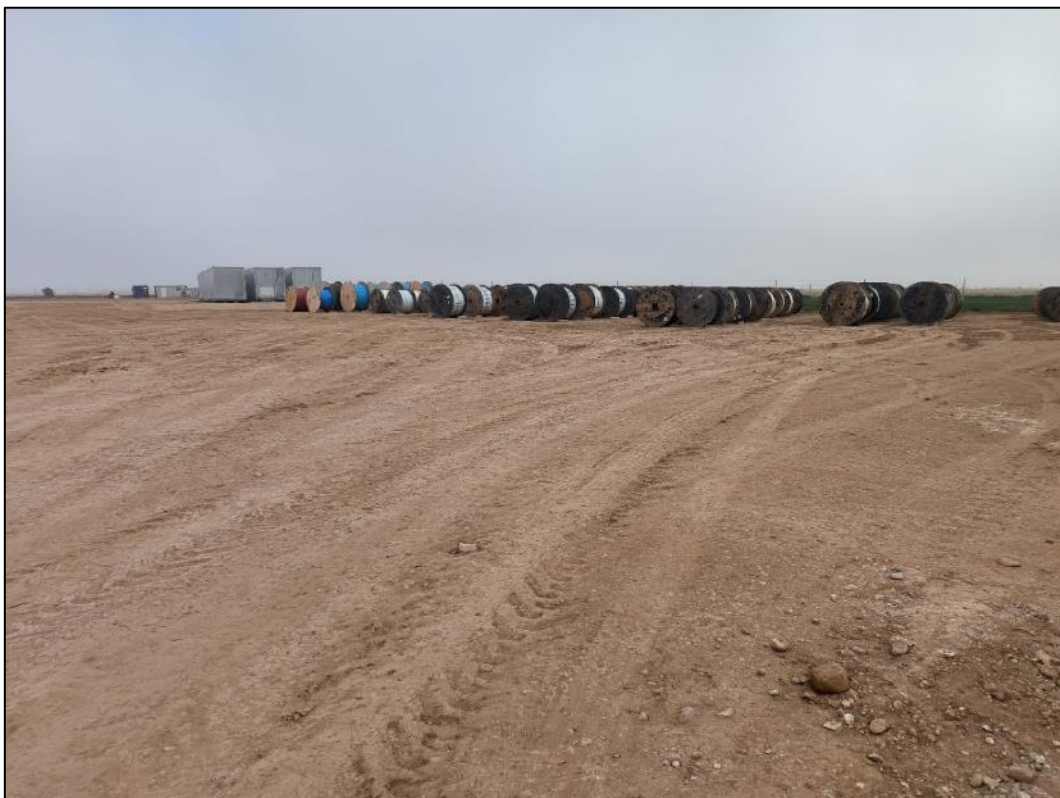
Figura nº 12. Almacén de cableado en acopio principal.
