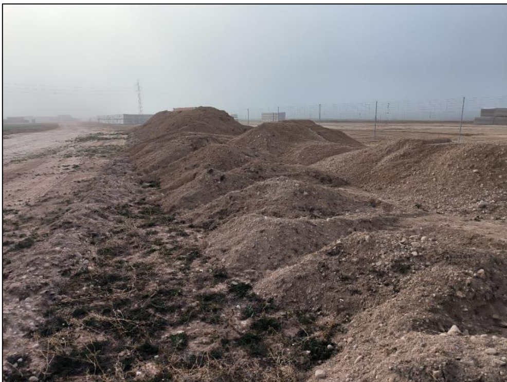
Figura nº 54. Acopio de tierra vegetal junto acopio de módulos.
