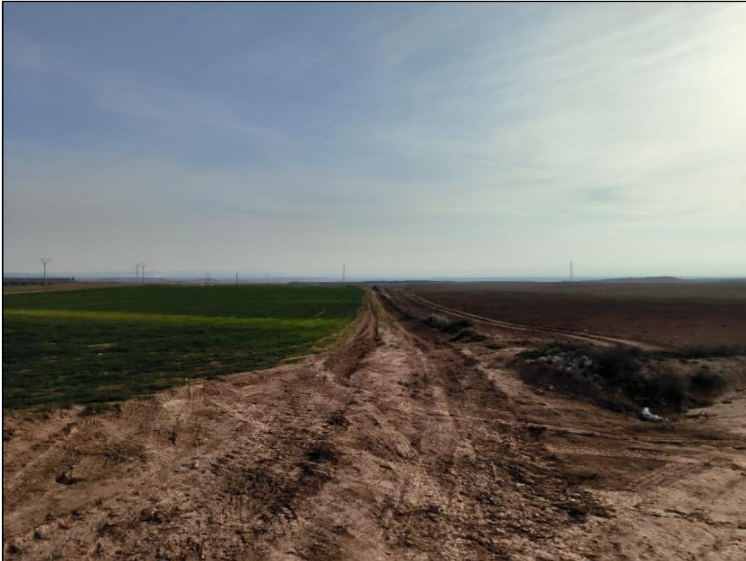
Figura nº 45. Camino de acceso sobre superficie agrícola entre apoyos de la línea eléctrica.
