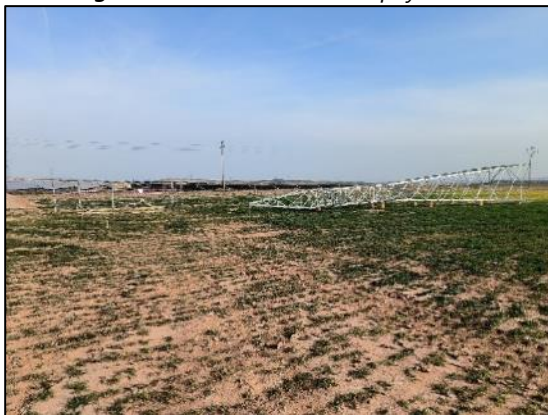
Figura nº 17. Situación Apoyo T32
