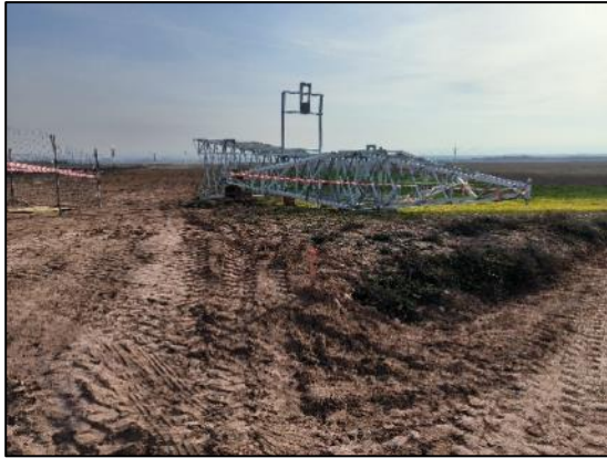
Figura nº 15. Situación Apoyo T33
