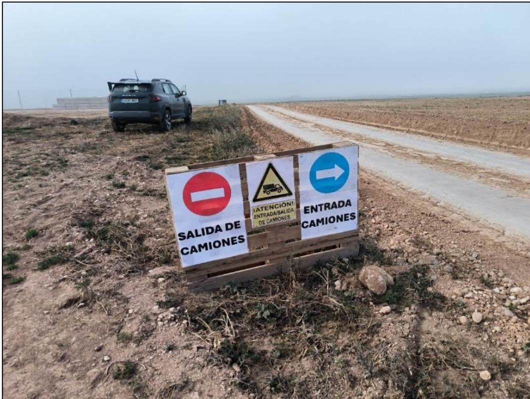
Figura nº 5. Señalización zona de acceso a acopio de módulos.
