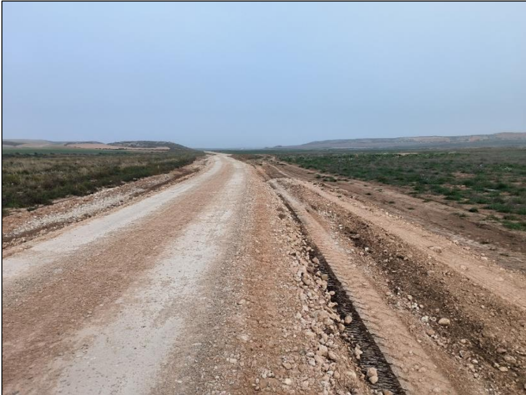
Figura nº 39. Camino acceso a la planta.
