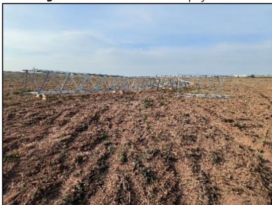
Figura nº 19. Situación Apoyo T31
