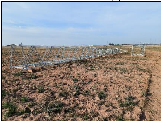
Figura nº 21. Situación Apoyo T30
