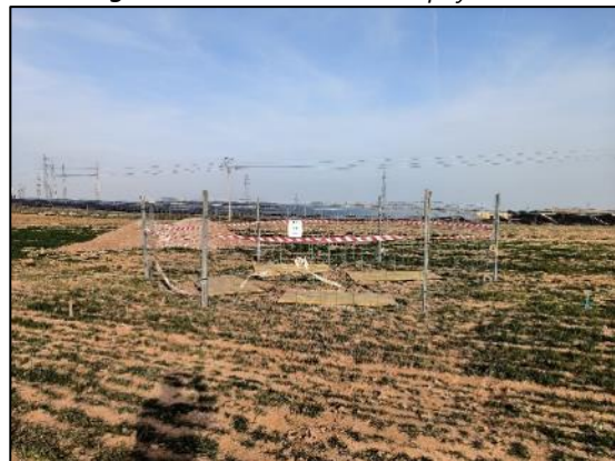
Figura nº 18. Situación Apoyo T32
