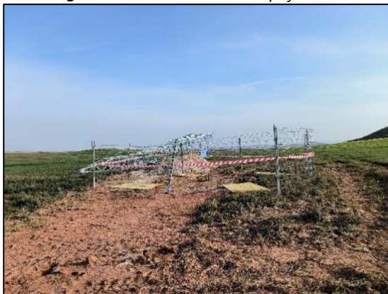
Figura nº 25. Situación Apoyo T27
