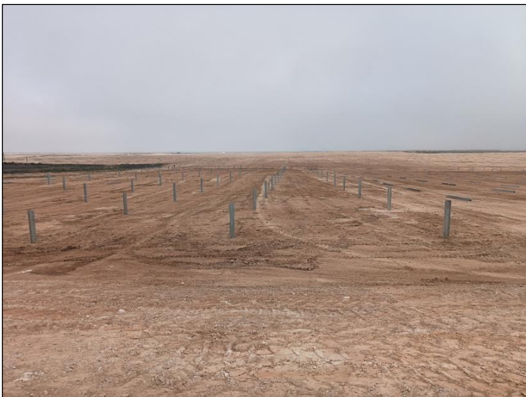
Figura nº 2. Trabajos de hincado en la esquina sureste de la planta "Híjar 1".
