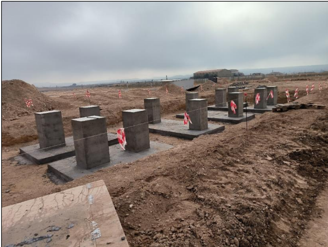
Figura nº 1. Excavación y hormigonado centros de transformación.
