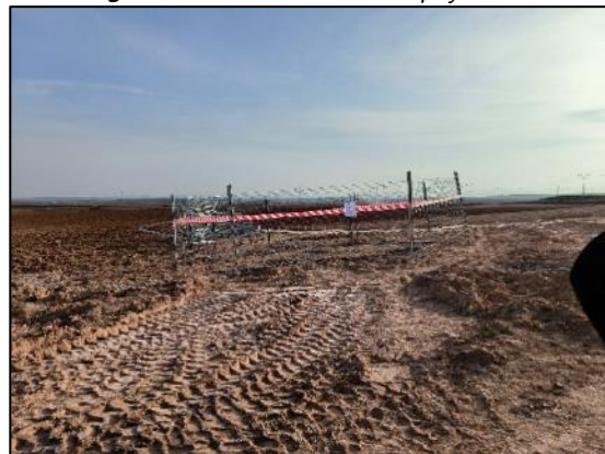
Figura nº 26. Situación Apoyo T26
