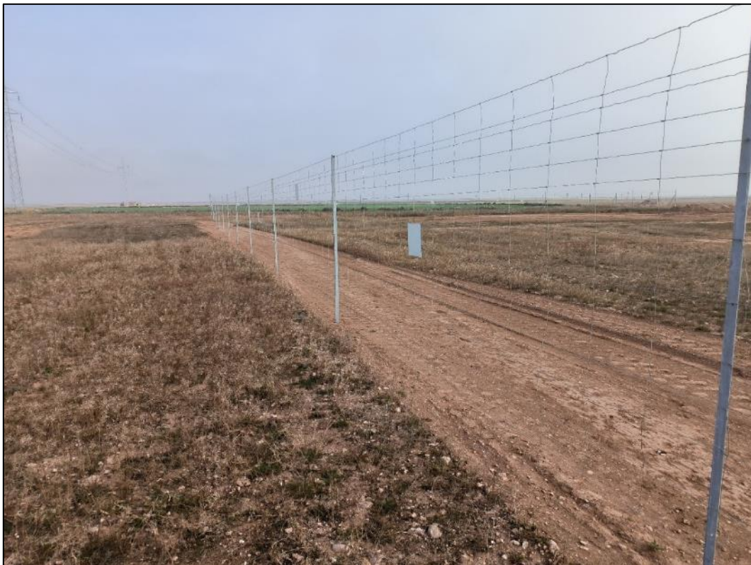
Figura nº 4. Instalación del vallado perimetral de acuerdo al condicionado de la DIA.
