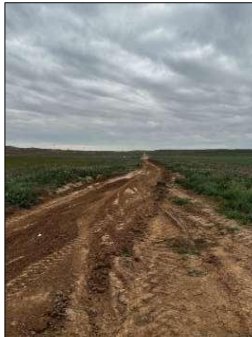
Figura nº 7. Instalación de badén prolongado para evitar la afección del camino por la estancamiento del agua, previo, saneamiento de este tramo
