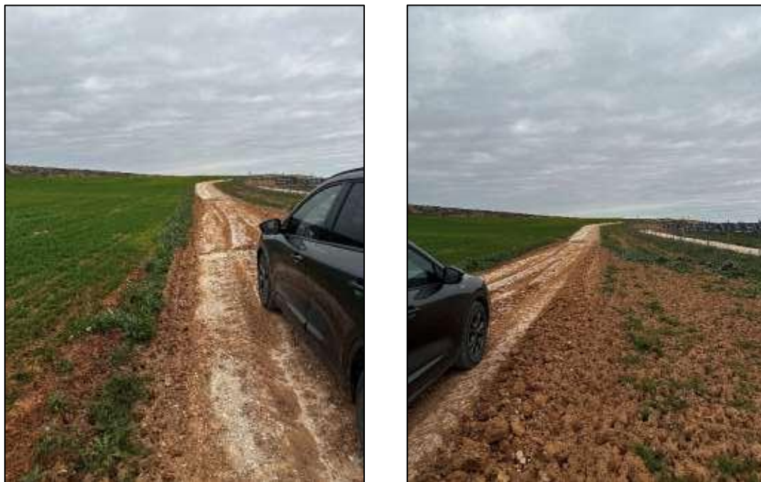
Figura nº 5. Zonas de relleno con material, junto con cunetas laterales y colocación de badén en la parte central
