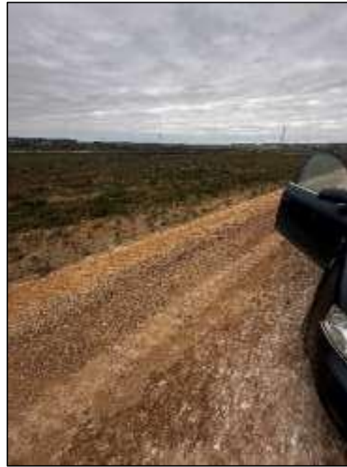
Figura nº 6. Zonas donde contrarrestar la pendiente mediante el relleno con material y elevación de la cota inferior de este punto bajo.
