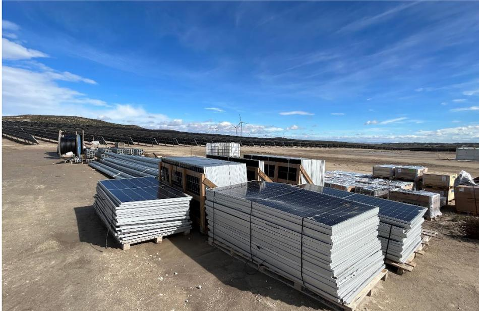
*Figura 5 Acopio del material de construcción*
