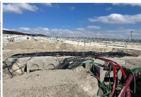
*Figura 12 Cableado de los centros de transformación*
