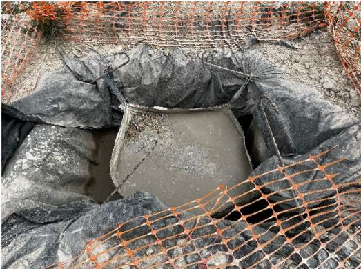
Figura 23 Lavadero de cubas de hormigón
