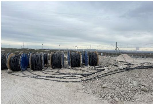
*Figura 9 Tendido de cable de baja tensión*
