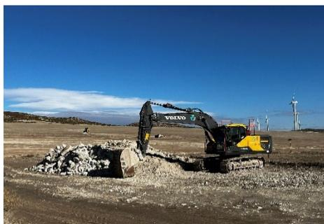
*Figura 3 Apertura de zanjas*
