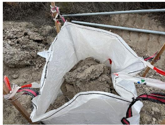
Figura 22 Retirada de los vertidos de hormigón
