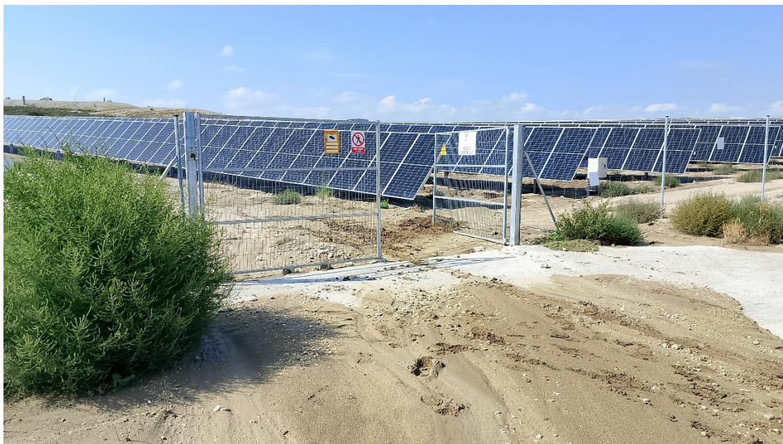
Fotografía 10. Entrada de Fede 2 Parcela 2 casi colapsada por el sedimento
