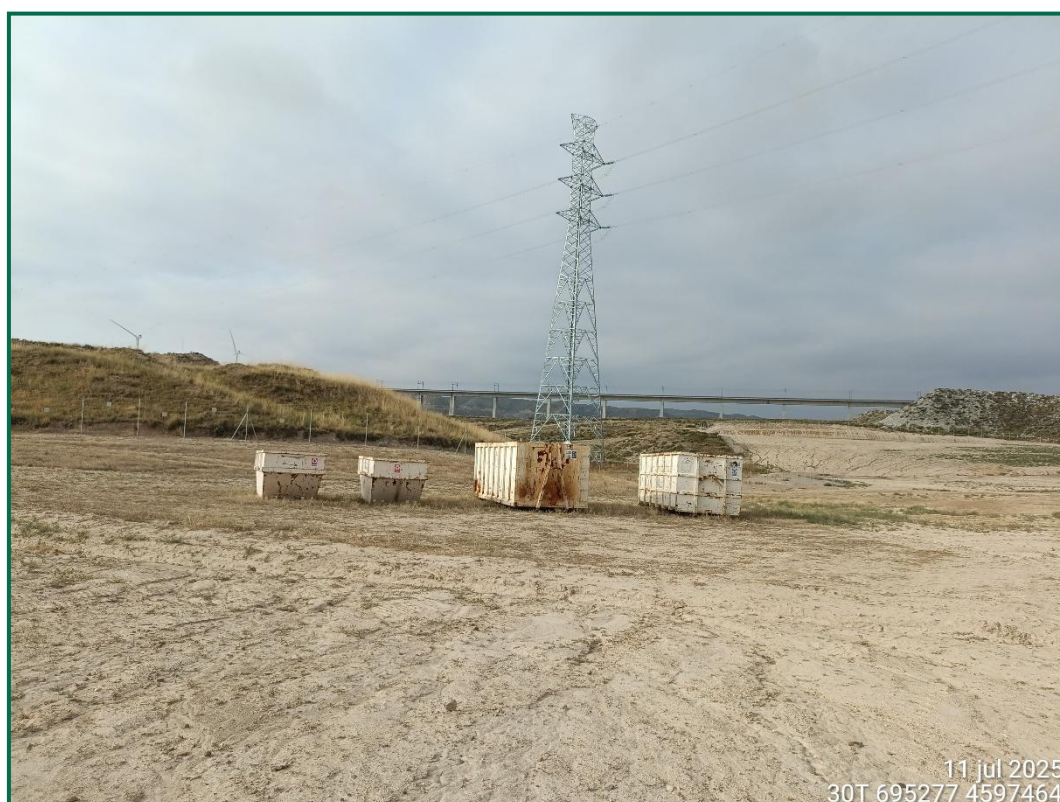
Fotografía 17. Contenedores para residuos inertes.
