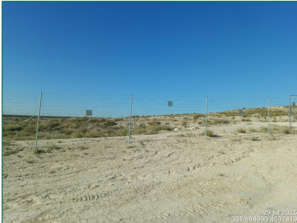
Fotografía 4. Vallado perimetral actualmente.
