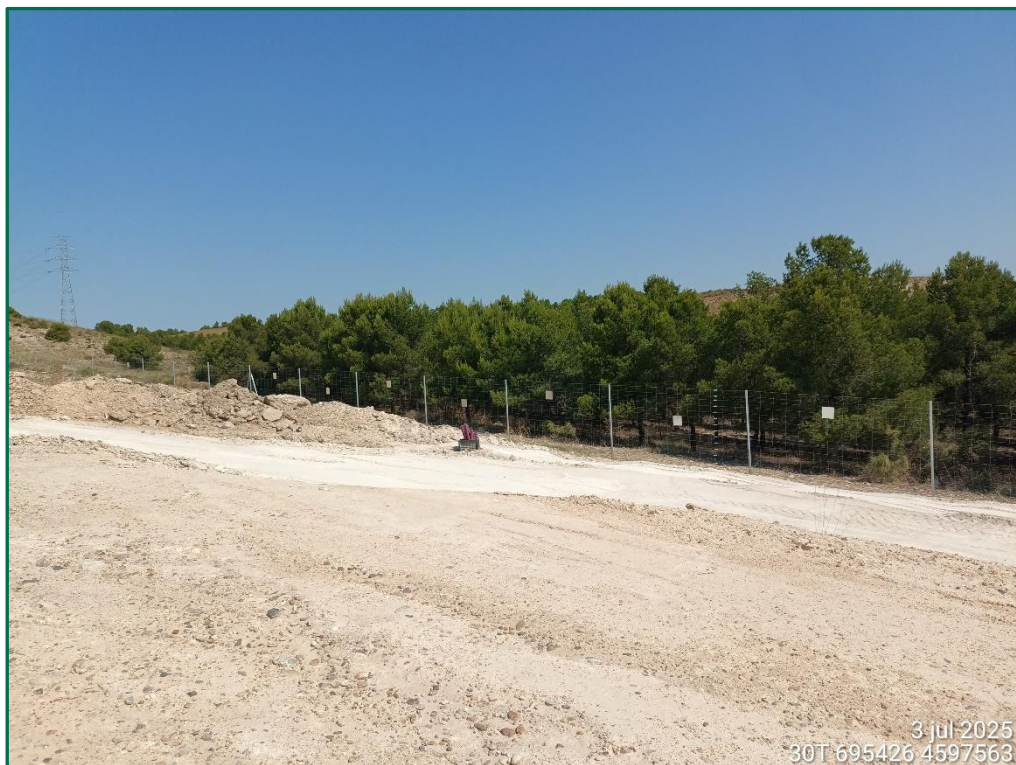
Fotografía 3. Vallado perimetral actualmente.
