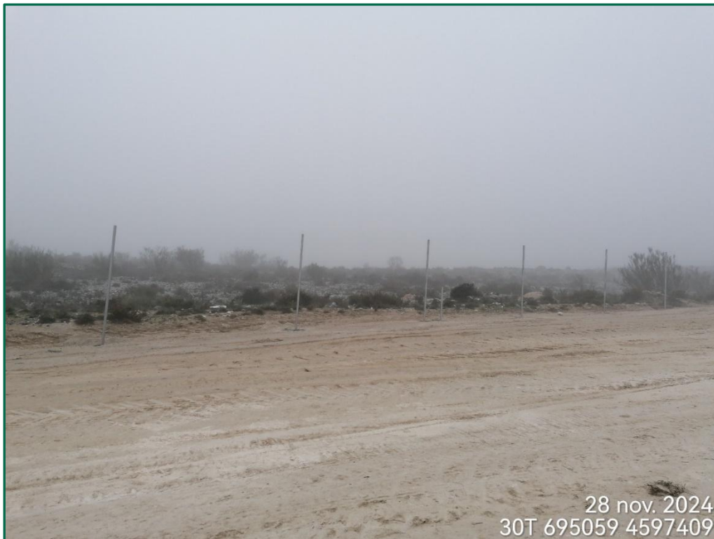
Fotografía 2. Postes de vallado (mes de noviembre).
