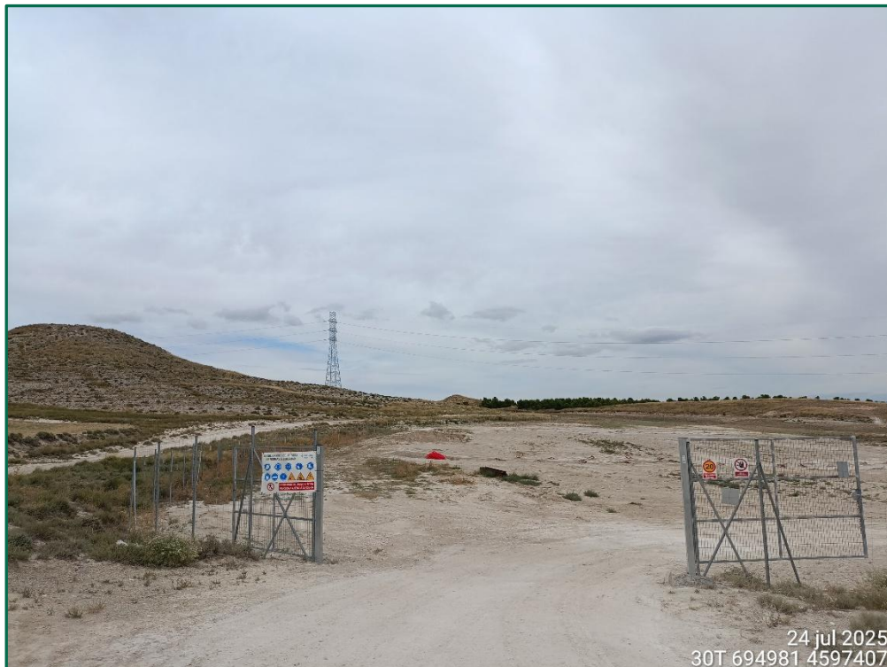
Fotografía 5. Vallado perimetral y puerta de acceso.
