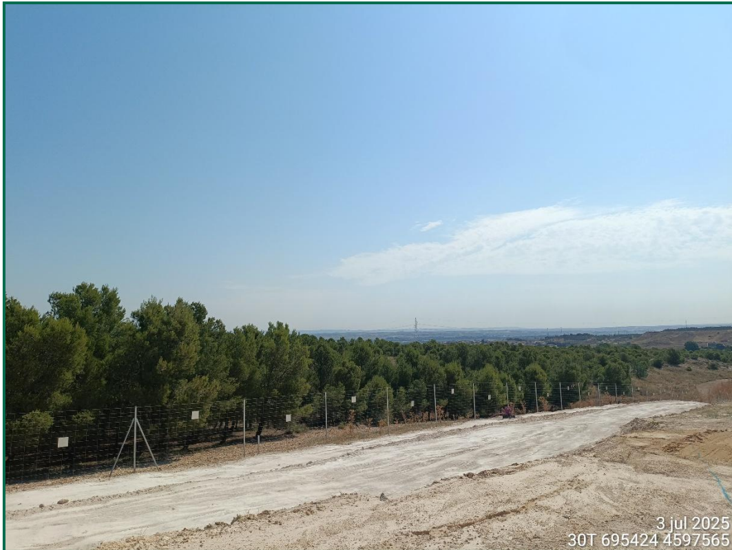
Fotografía 15. Vallado perimetral con placas anticolidión y pasos de fauna.
