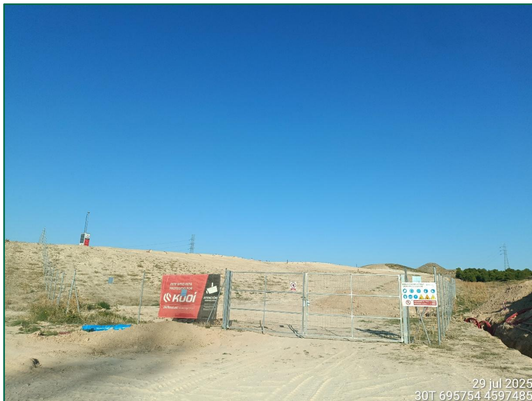
Fotografía 6. Vallado perimetral y puerta de acceso.
