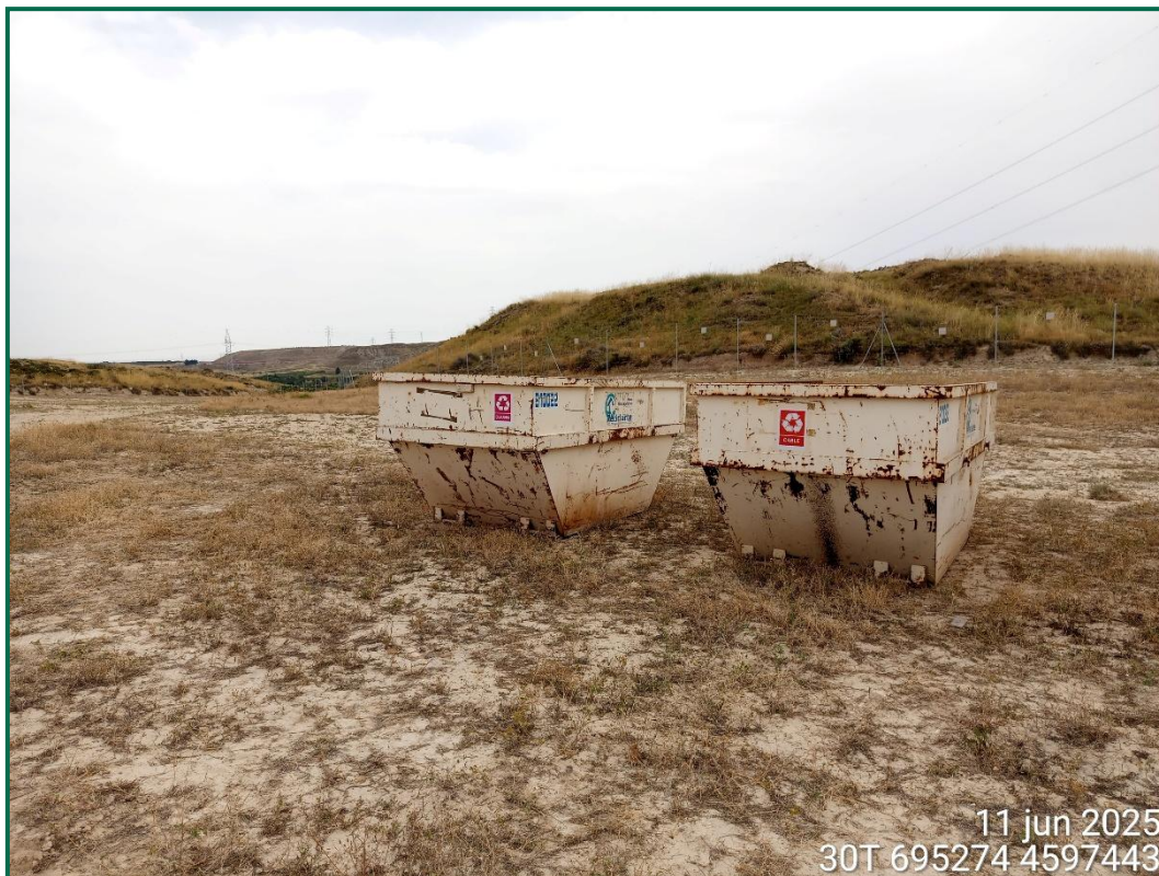
Fotografía 16. Contenedores para residuos inertes.
