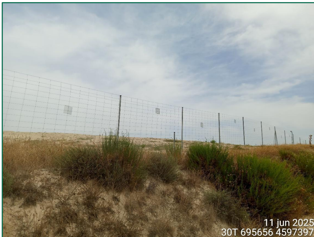
Fotografía 4. Vallado perimetral actualmente.
