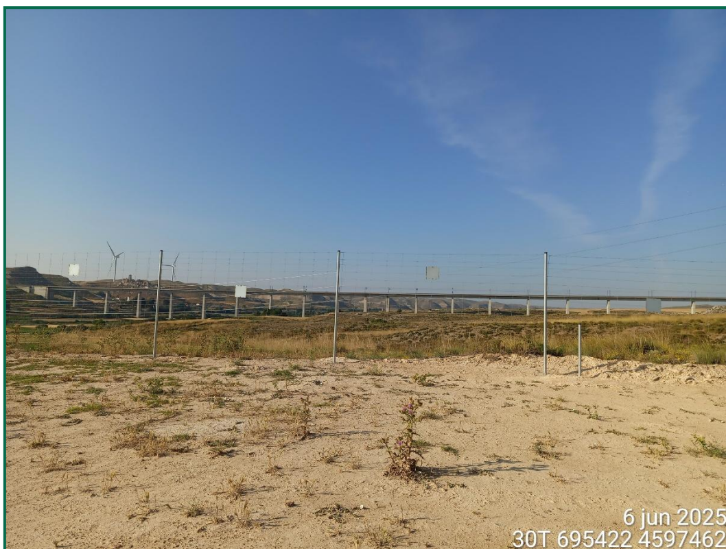
Fotografía 13. Vallado perimetral con placas anticolidión y pasos de fauna.
