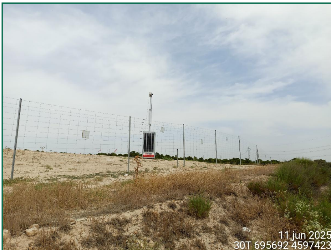
Fotografía 14. Vallado perimetral con placas anticolidión y pasos de fauna.
