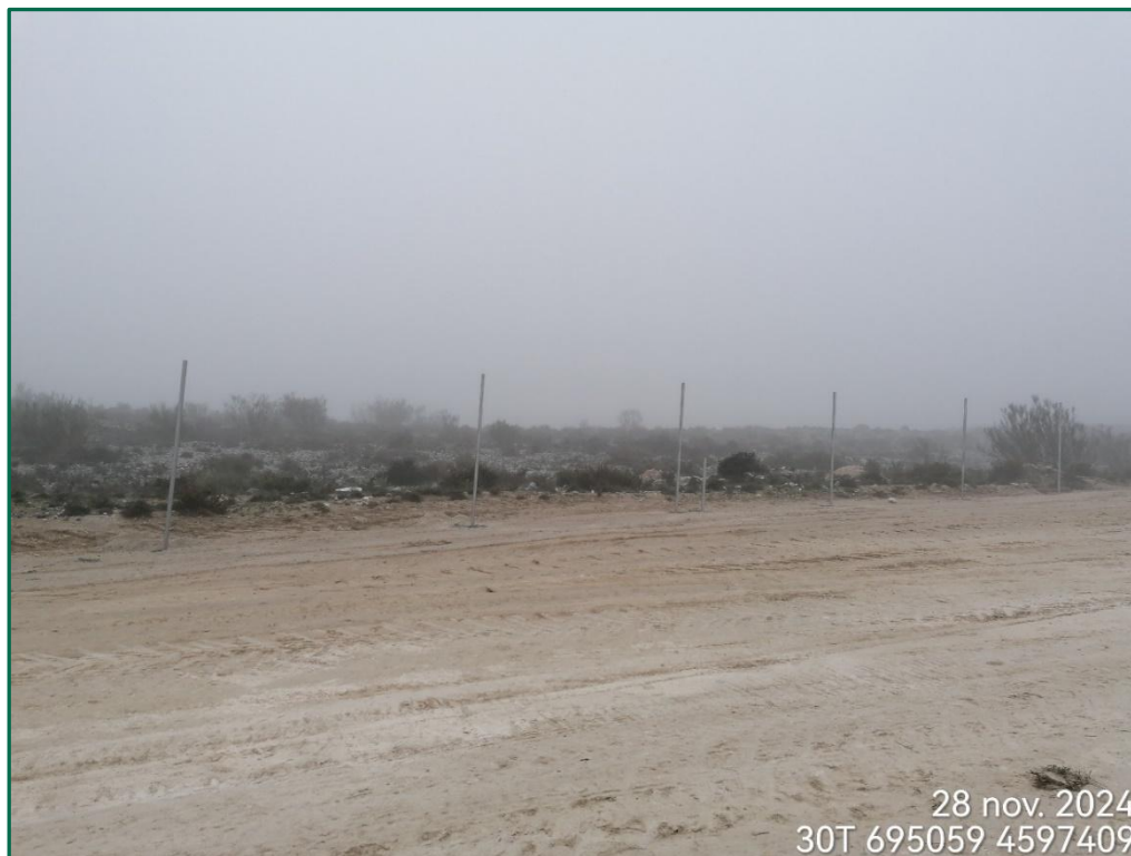
Fotografía 2. Postes de vallado (mes de noviembre).
