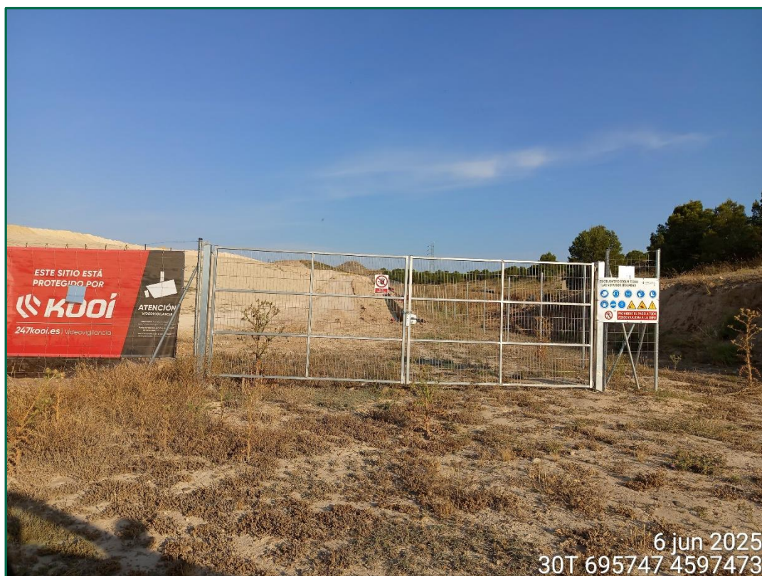
Fotografía 6. Vallado perimetral y puerta de acceso.
