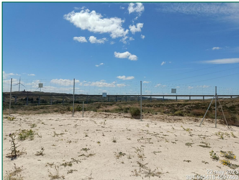
Fotografía 3. Vallado perimetral actualmente.
