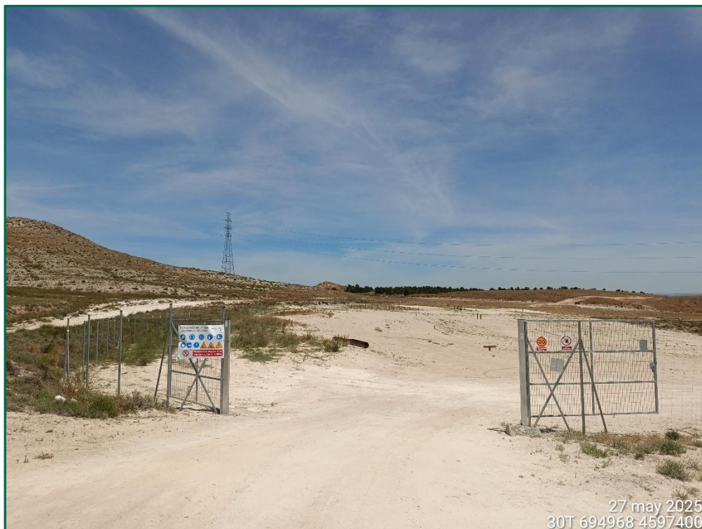
Fotografía 5. Vallado perimetral y puerta de acceso.
