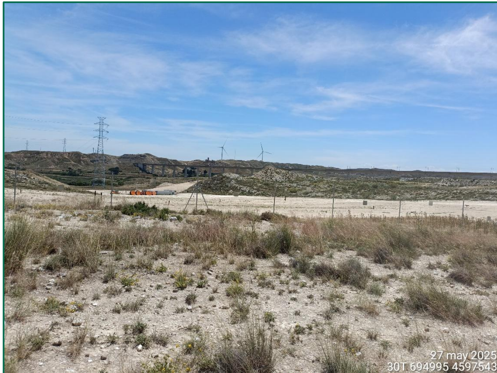
Fotografía 4. Vallado perimetral actualmente.
