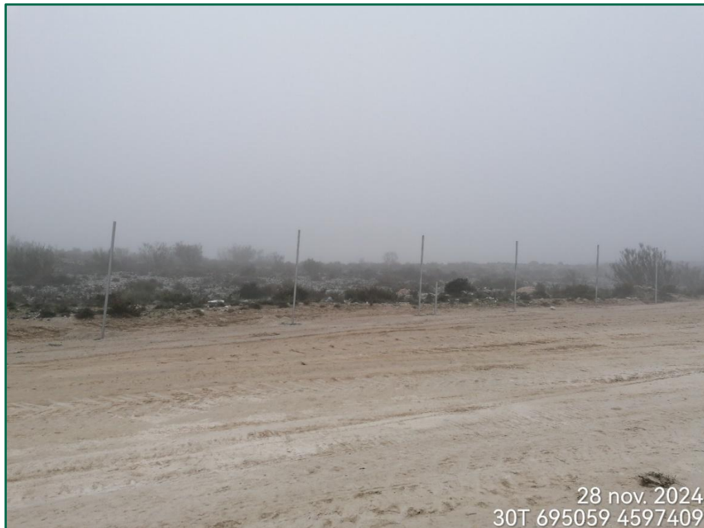
Fotografía 2. Postes de vallado (mes de noviembre).
