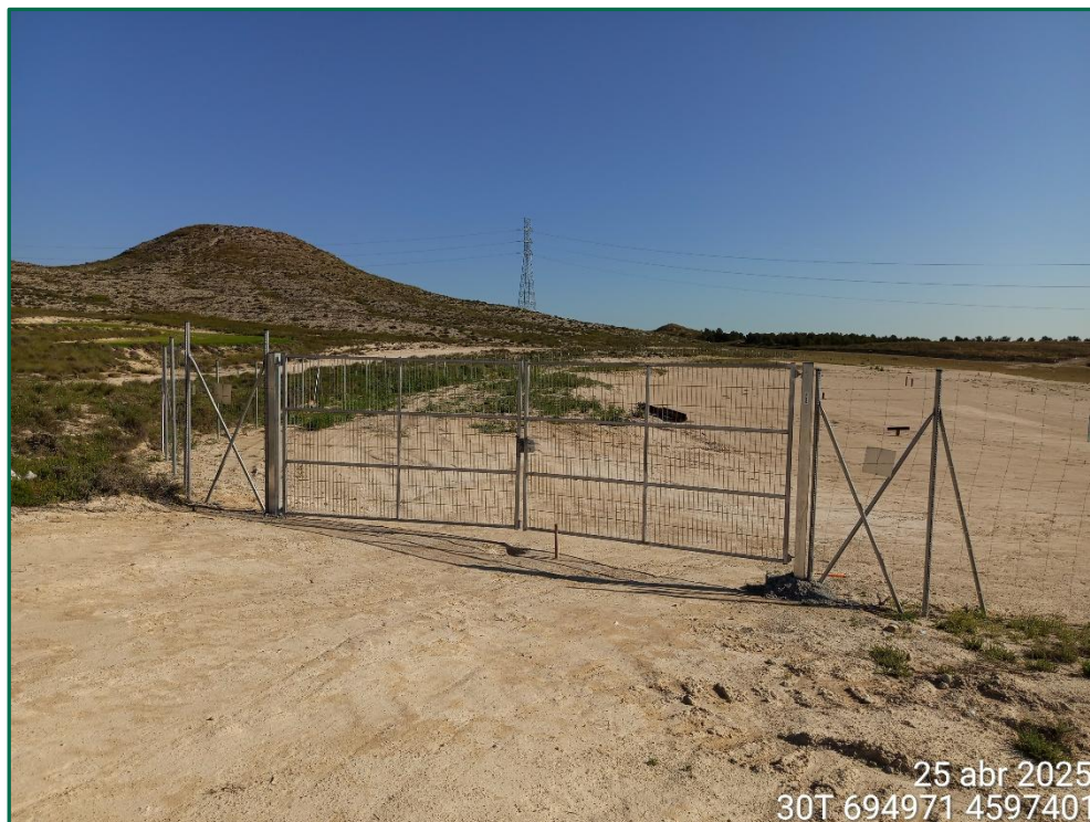
Fotografía 6. Vallado perimetral y puerta de acceso.
