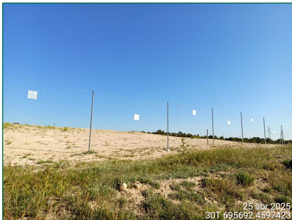
Fotografía 3. Vallado perimetral actualmente.
