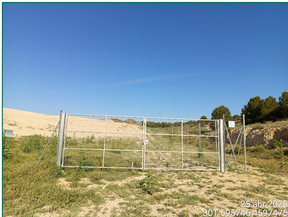
Fotografía 5. Vallado perimetral y puerta de acceso.
