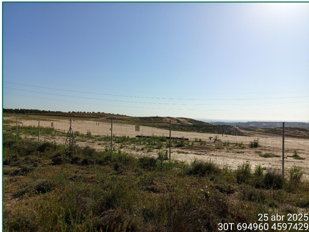
Fotografía 4. Vallado perimetral actualmente.
