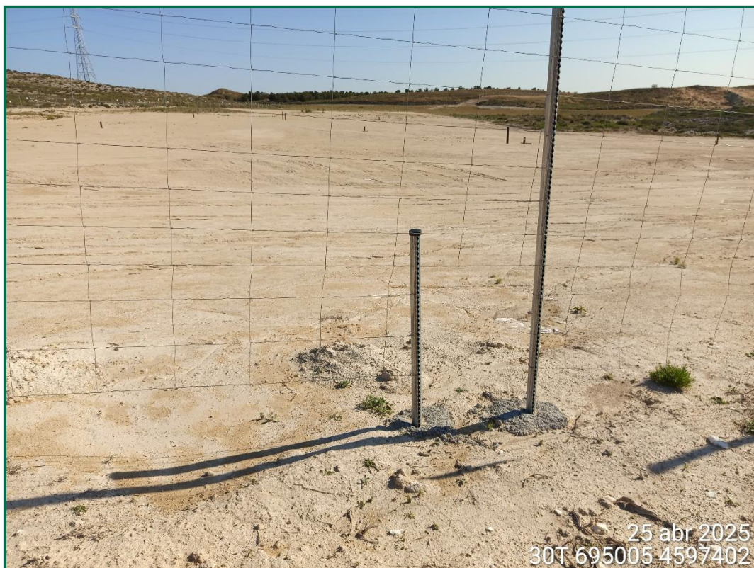
Fotografía 12. Paso de fauna en vallado perimetral.
