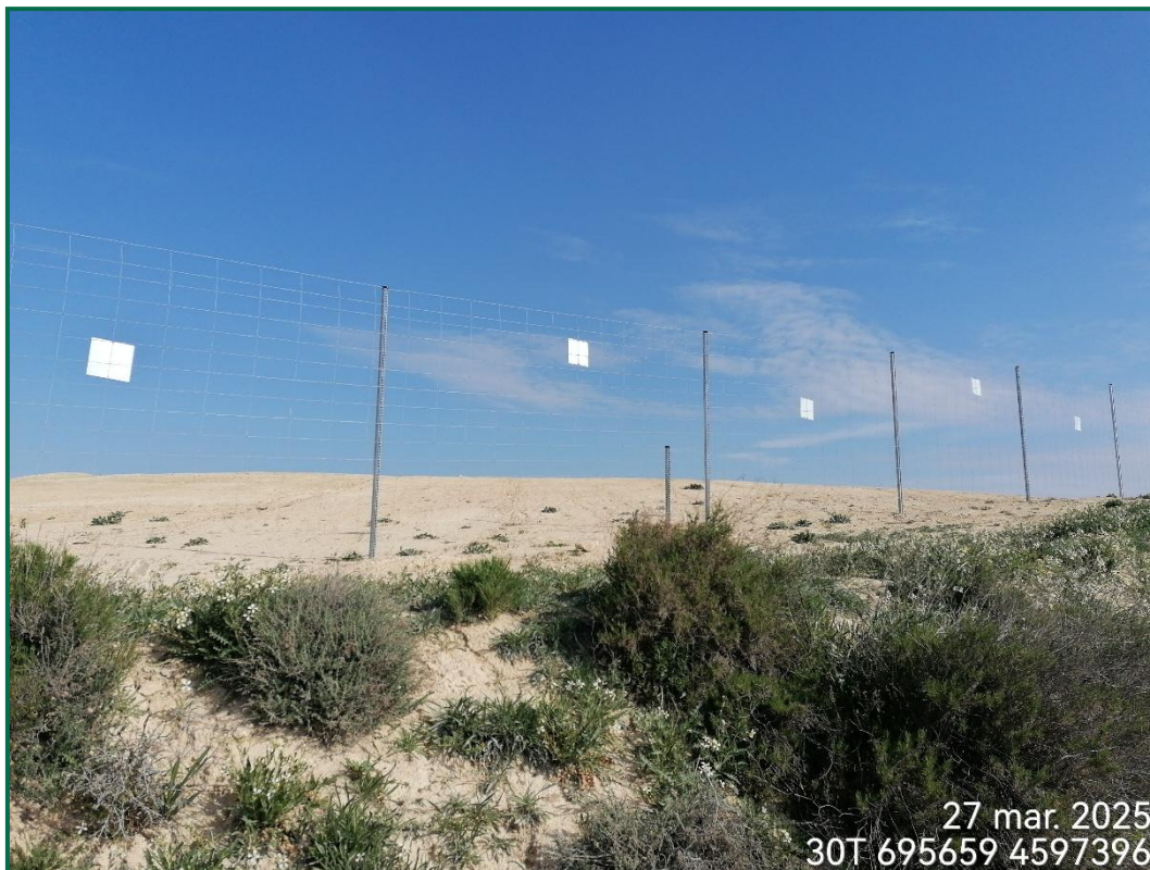
Fotografía 11. Vallado perimetral con placas anticolidión y pasos de fauna.
