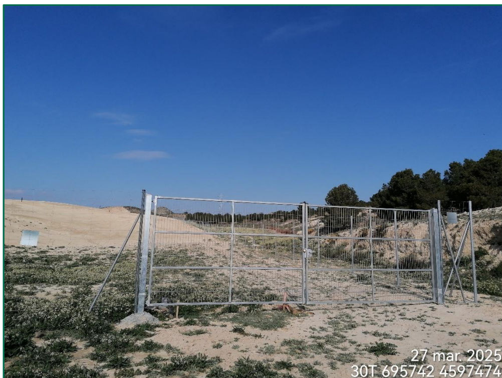
Fotografía 5. Vallado perimetral y puerta de acceso.
