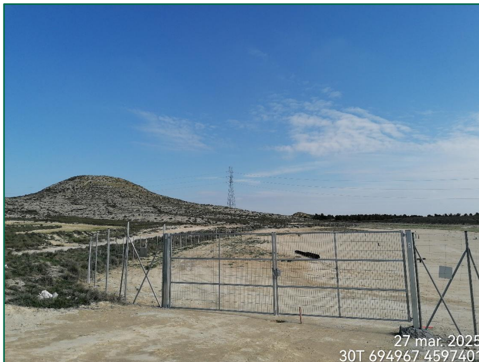
Fotografía 6. Vallado perimetral y puerta de acceso.
