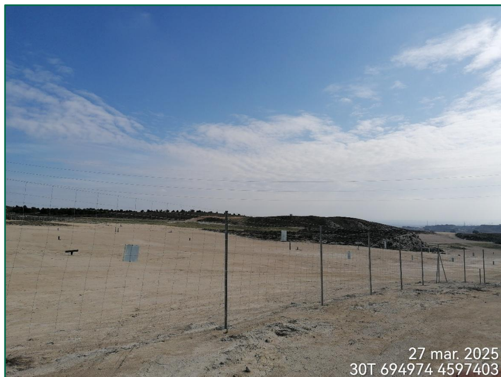
Fotografía 3. Vallado perimetral actualmente.
