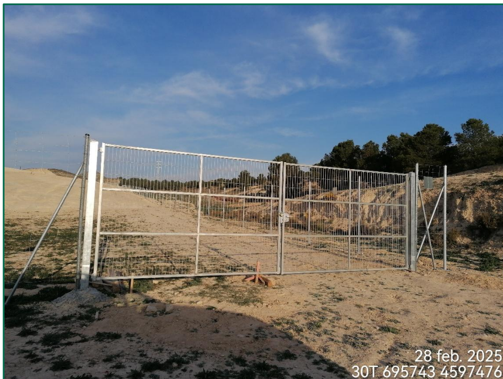
Fotografía 4. Vallado perimetral y puerta de acceso.
