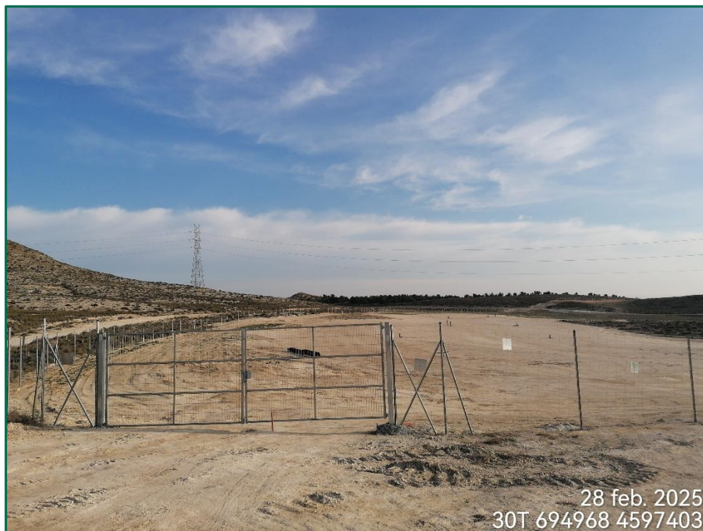
Fotografía 5. Vallado perimetral y puerta de acceso.
