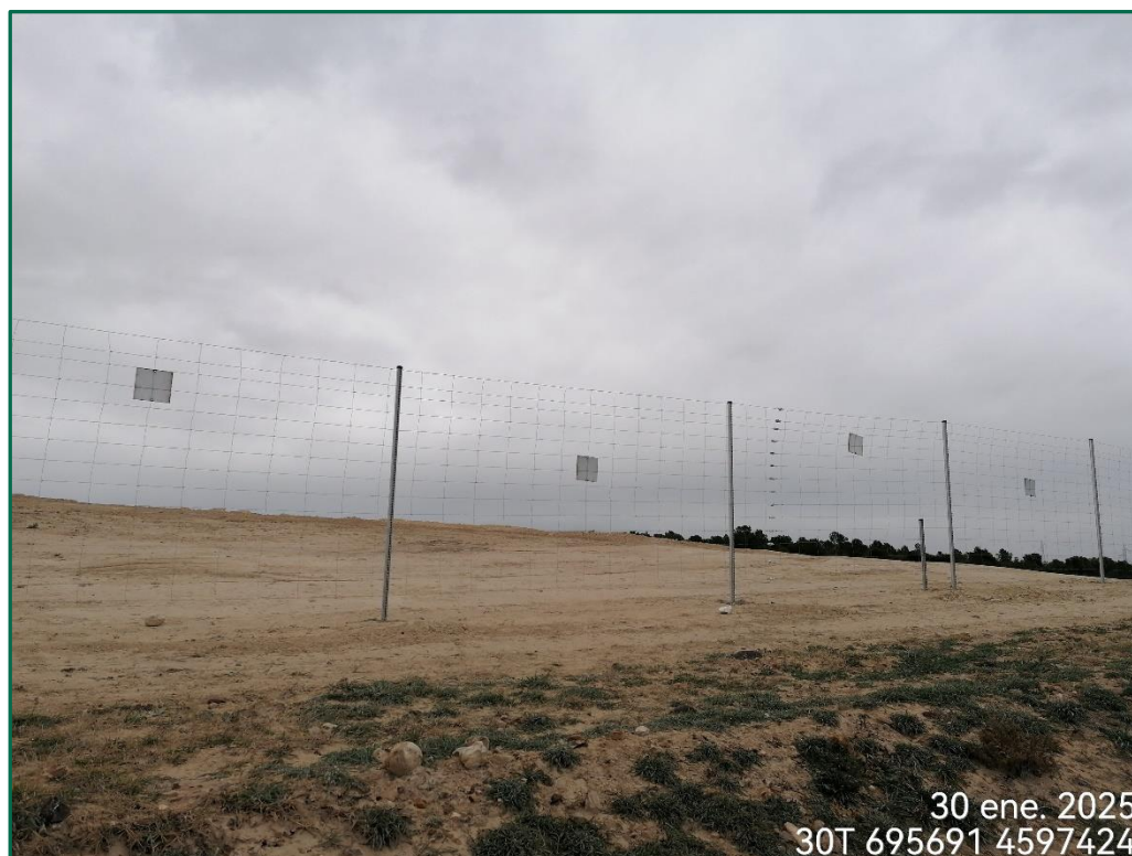
Fotografía 3. Vallado perimetral actualmente.
