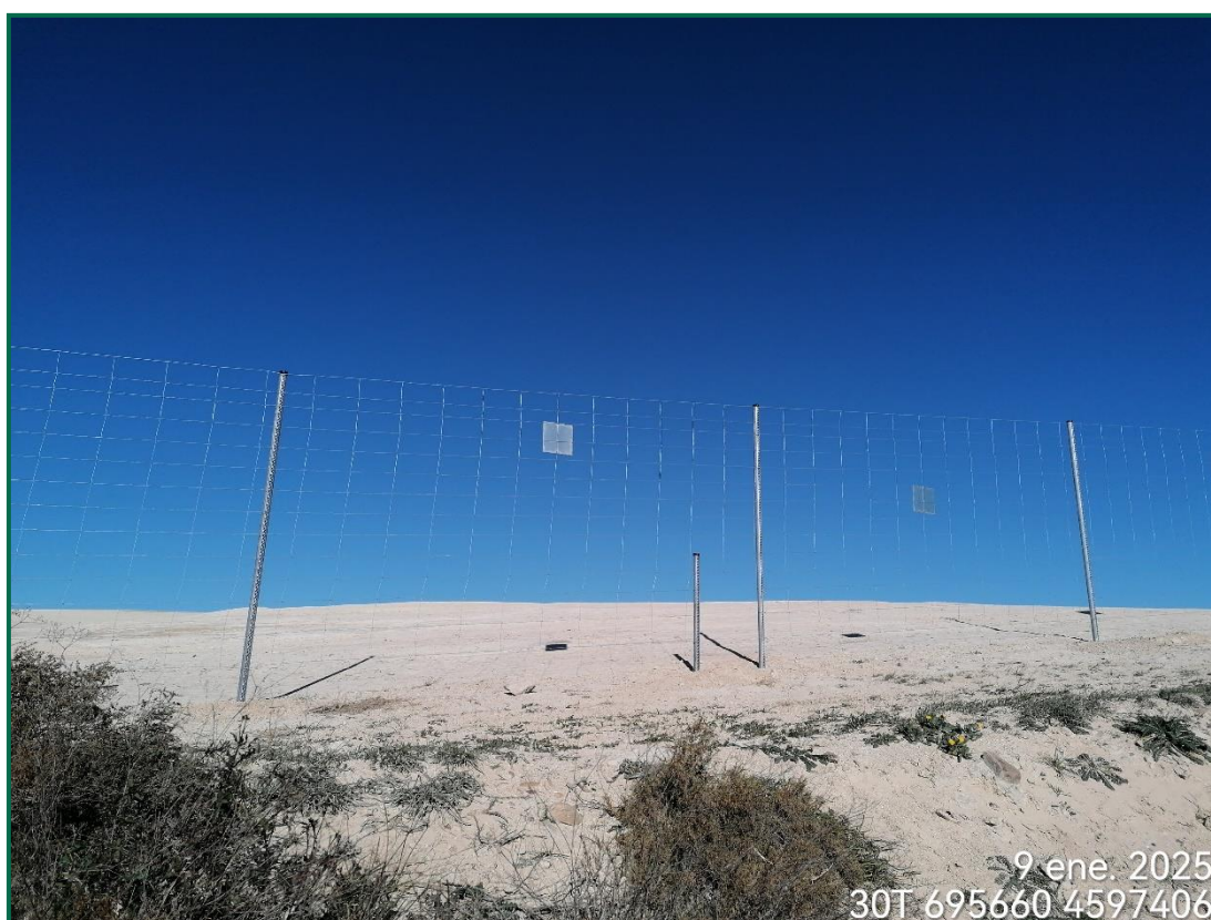
Fotografía 10. Vallado perimetral con placas anticolidión y pasos de fauna.
