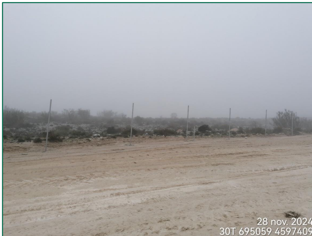
Fotografía 2. Postes de vallado (mes de noviembre).
