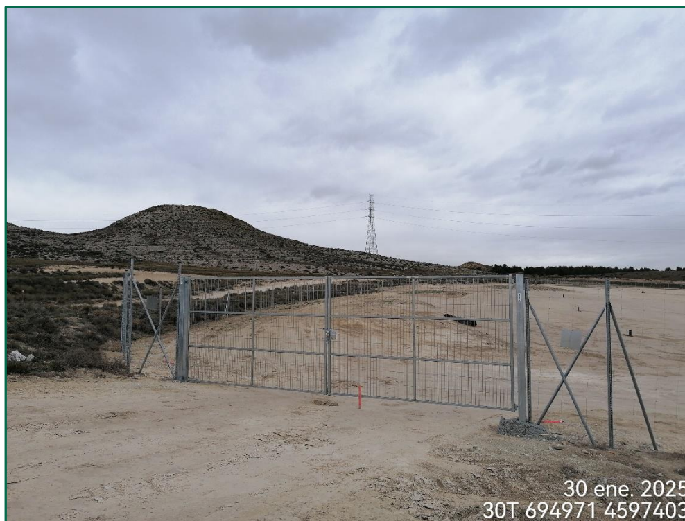
Fotografía 5. Vallado perimetral y puerta de acceso.
