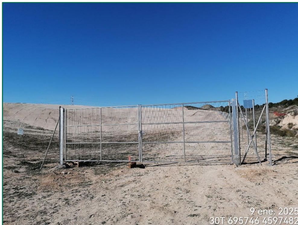
Fotografía 4. Vallado perimetral y puerta de acceso.
