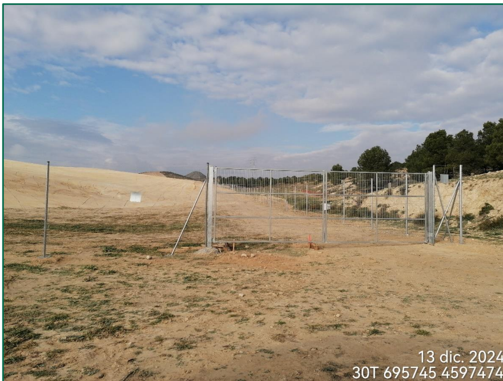
Fotografía 4. Vallado perimetral y puerta de acceso.
