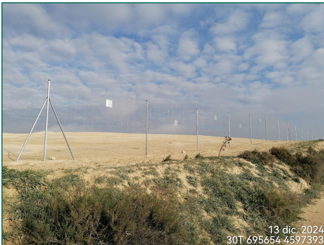
Fotografía 3. Vallado perimetral actualmente.
