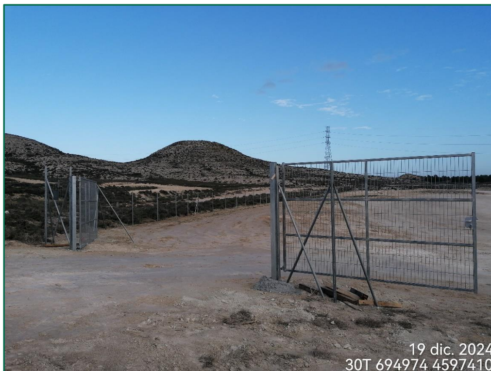
Fotografía 5. Vallado perimetral y puerta de acceso.
