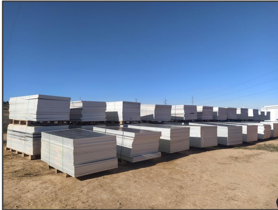
Fotografía 14. Zona de acopio de placas solares deterioradas.
