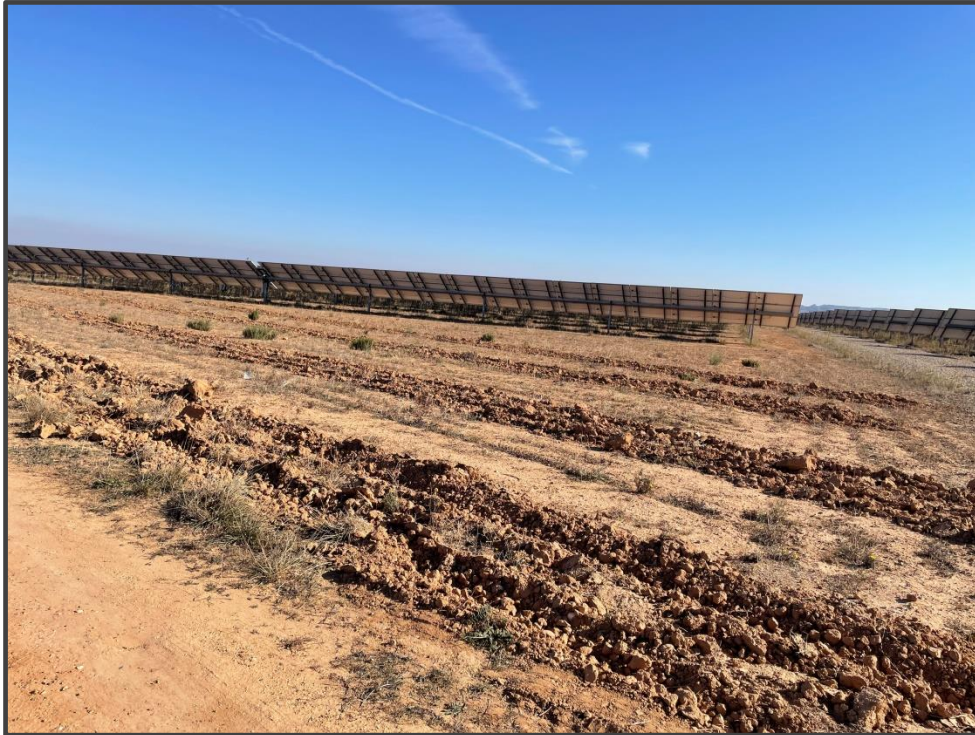
Fotografía 16. Reposición reciente de la restauración vegetal.
