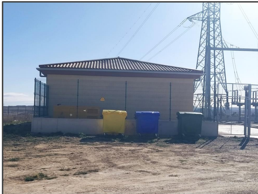
Fotografía 15. Contenedores de residuos junto a la subestación.
