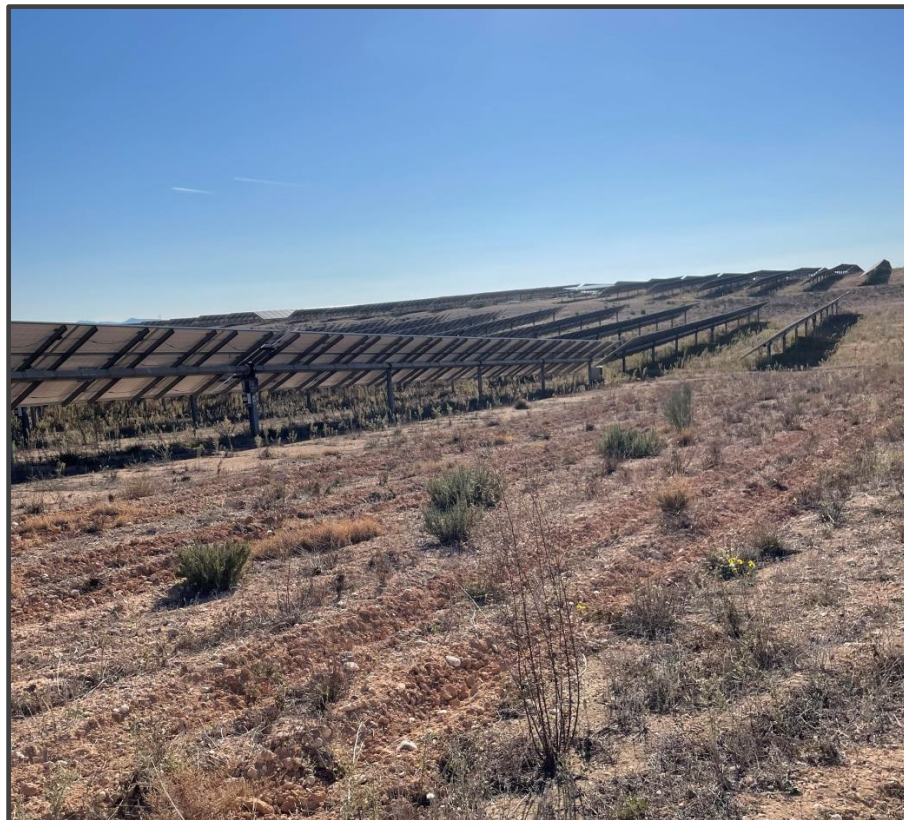
Fotografía 17. Reposición reciente de la restauración vegetal.
