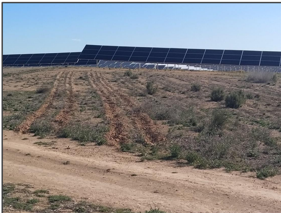
Fotografía 18. Reposición reciente de la restauración vegetal.
