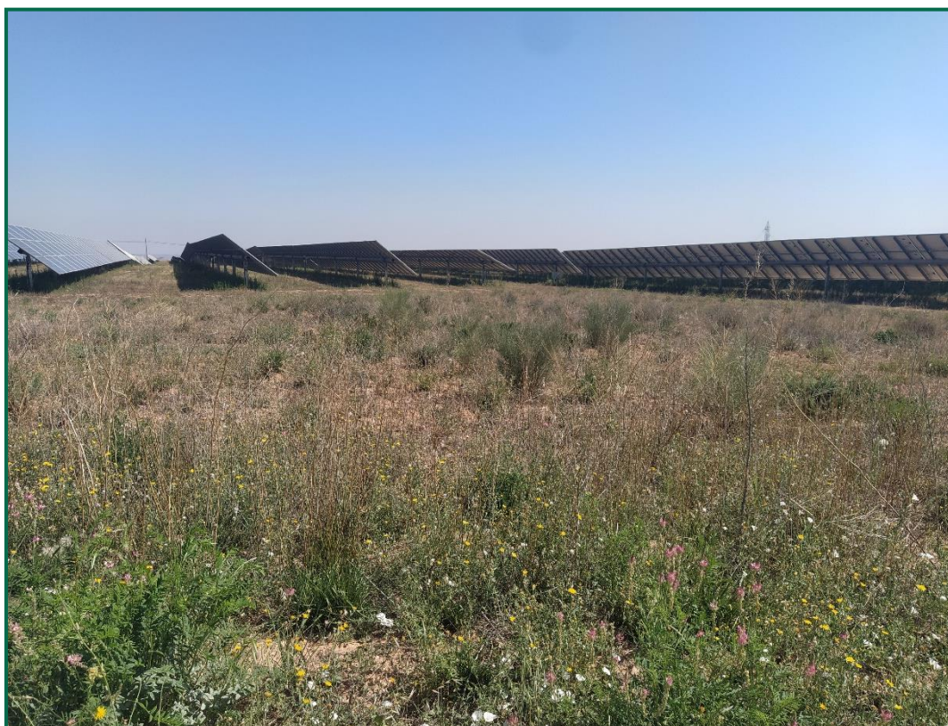
Fotografía 1. Vegetación entre placas en su estado actual.
