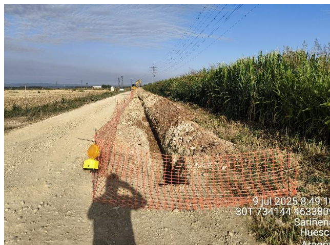
Figura 5: Construcción de zanja para la evacuación de la energía del parque.
