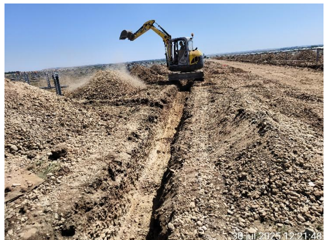
Figura 10: Realización de zanjas internas del Parque para la evacuación de energía.
