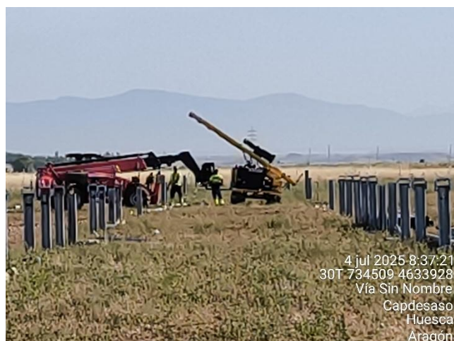
Figura 2: Labores de finalización del hincado de los postes verticales.
