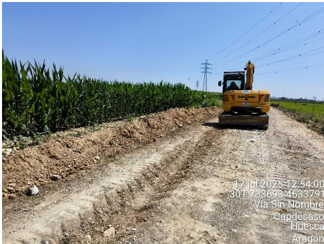
Figura 7: Construcción de zanja para la evacuación de la energía del parque.
