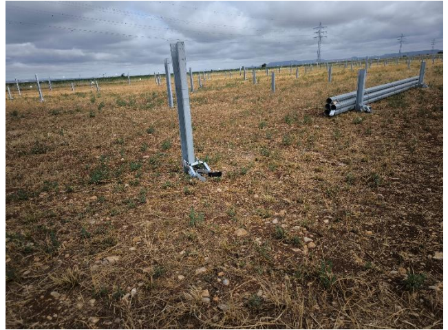
Figura 3: Zona de hincado de postes verticales
