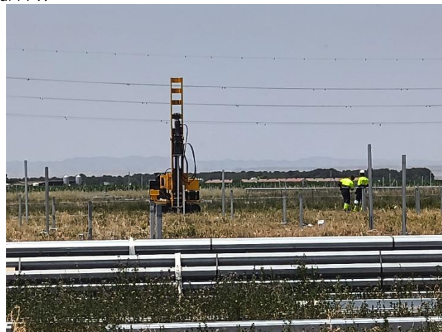
Figura 6: Trabajos de hincado sobre el PFV Espartal.
