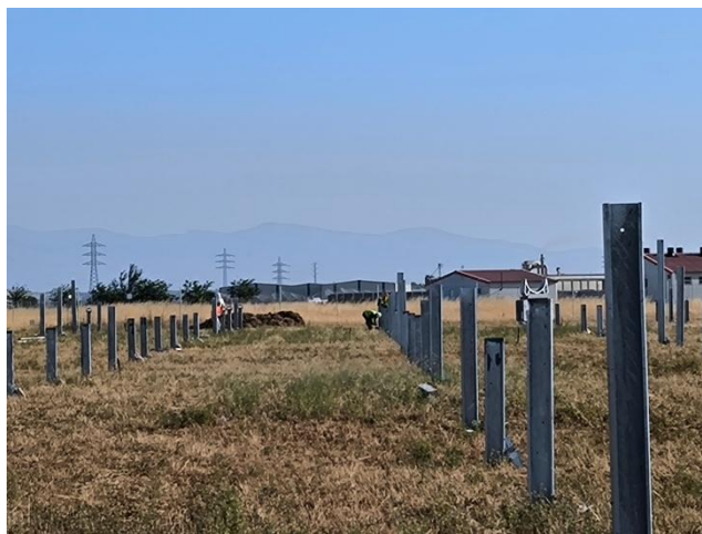
Figura 10: Superficie del PFV con la colocación de postes verticales.
