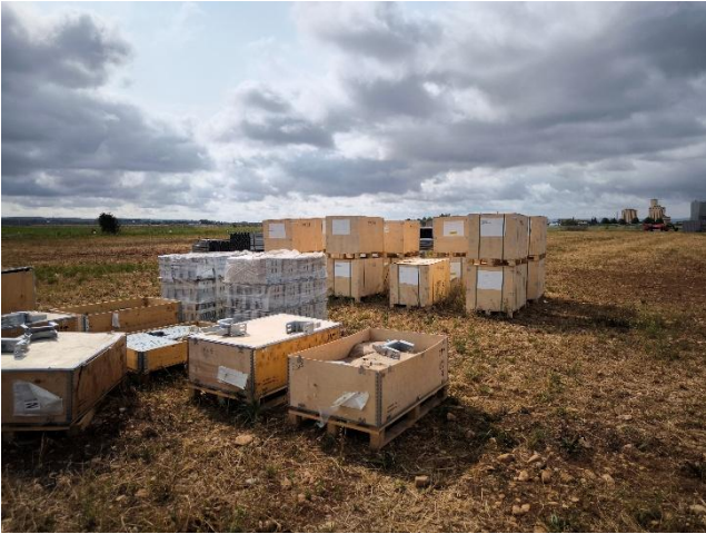
Figura 2: Acopios de materiales para la instalación de las placas del PFV Espartal.
