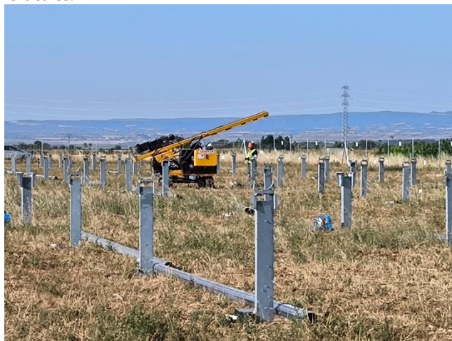
Figura 12: Trabajos de hincado sobre el PFV Espartal.
