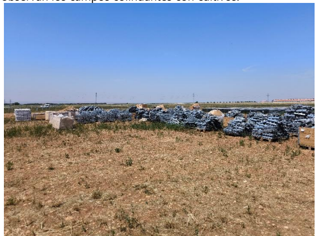
Figura 7: Acopios de materiales para la instalación de las placas del PFV Espartal.
