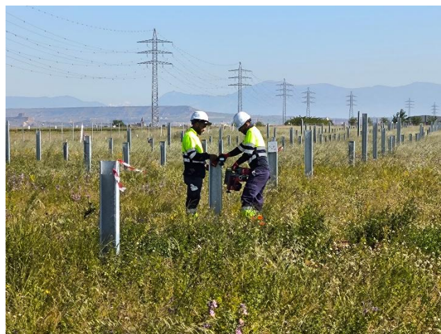
Figura 7: Trabajos de reglado de vigetas verticales.
