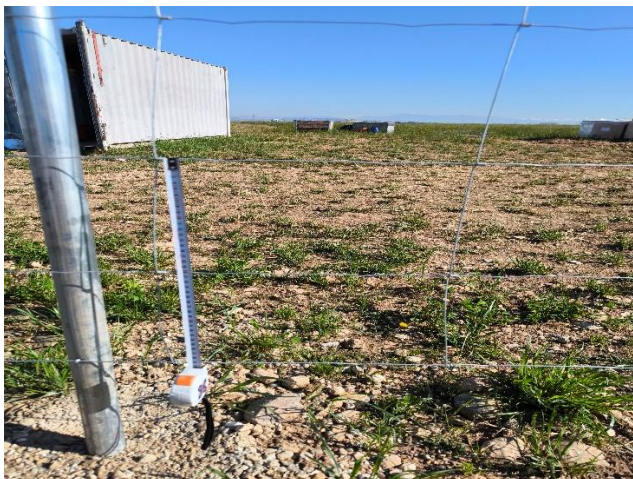
Figura 4: vallado perimetral del PFV, es preciso acabar los pasos de fauna verticales cada 50 metros.
