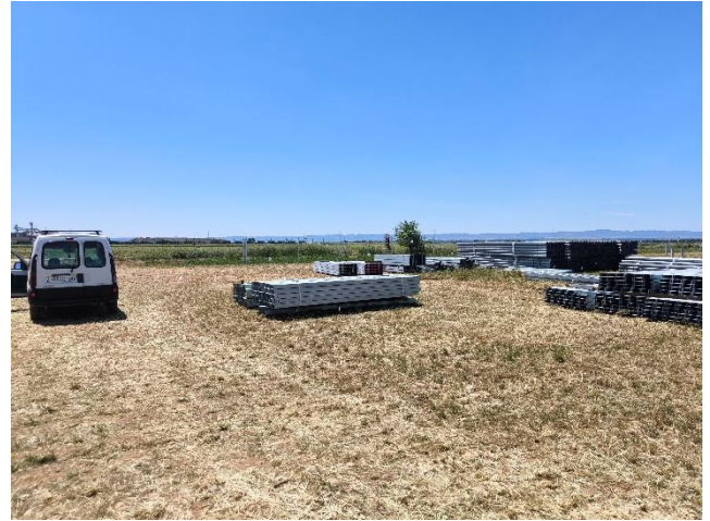
Figura 8: Zona de acopios de materiales del PFV.
