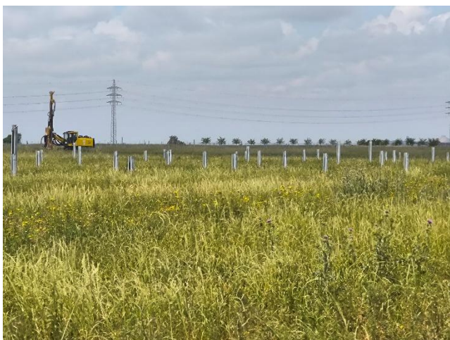
Figura 2: Trabajos de hincado sobre el PFV Espartal.
