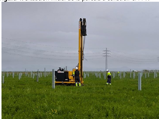
Figura 6: Operarios realizando los trabajos propios del hincado de viguetas.
