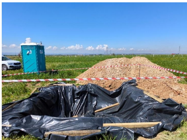
Figura 7: Construcción de vaso para el lavado de hormigoneras, en estos momentos no se ha llegado a utilizar.
