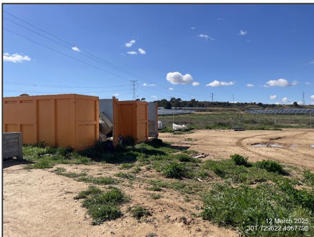
Fotografía 25. Zona de acopio de placas solares deterioradas.
