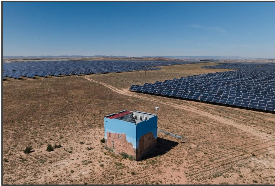
Fotografía 11. Exterior del primillar, pintado.
