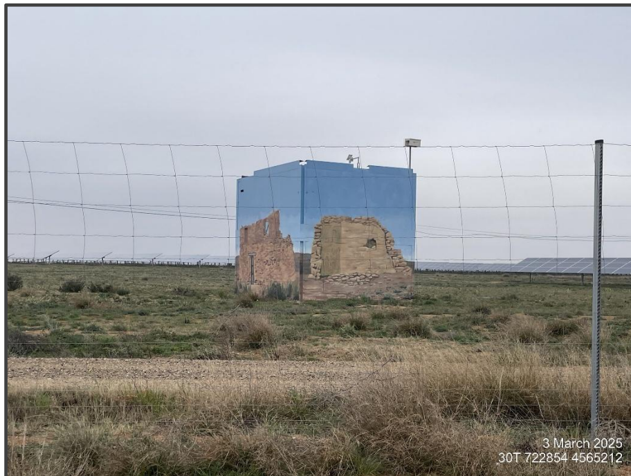
Fotografía 10. Exterior del primillar, pintado.
