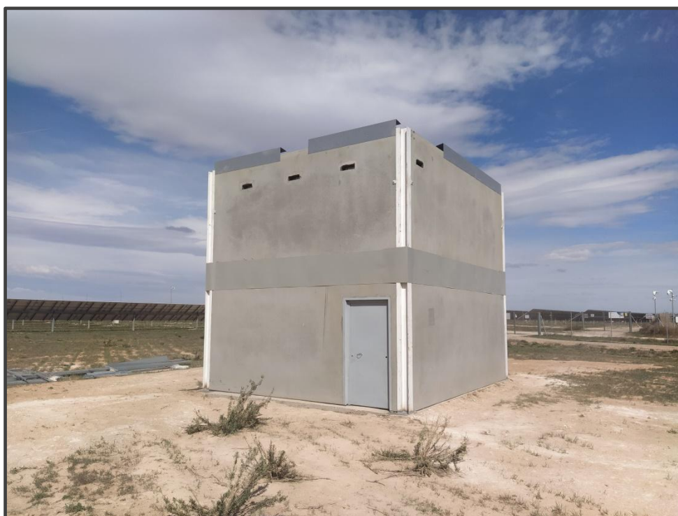
Fotografía 8. Exterior del primillar de nueva construcción.
