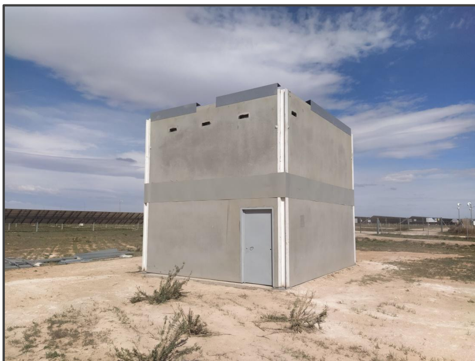
Fotografía 7. Exterior del primillar de nueva construcción.
