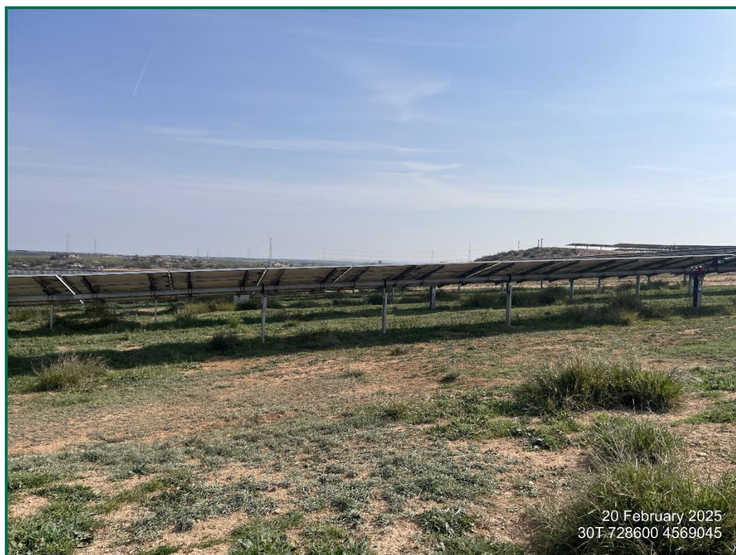
Fotografía 2. Vegetación entre placas actualmente.
