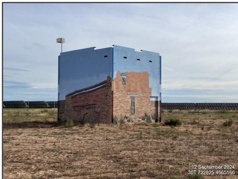
Fotografía 9. Exterior del primillar, pintado.
