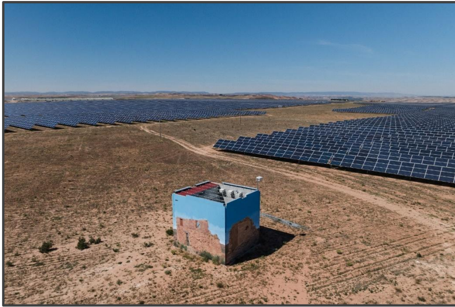
Fotografía 10. Exterior del primillar, pintado.
