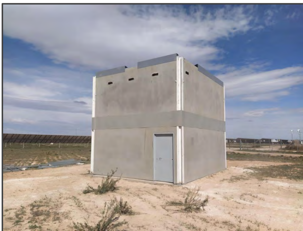
Fotografía 7. Exterior del primillar de nueva construcción.
