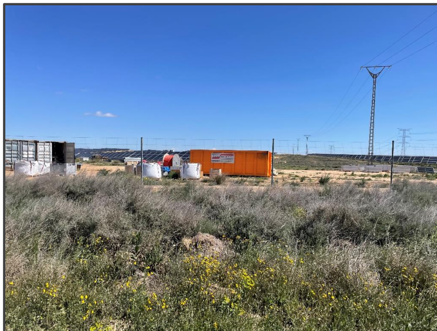
Fotografía 31. Zona de acopio de placas solares deterioradas.
