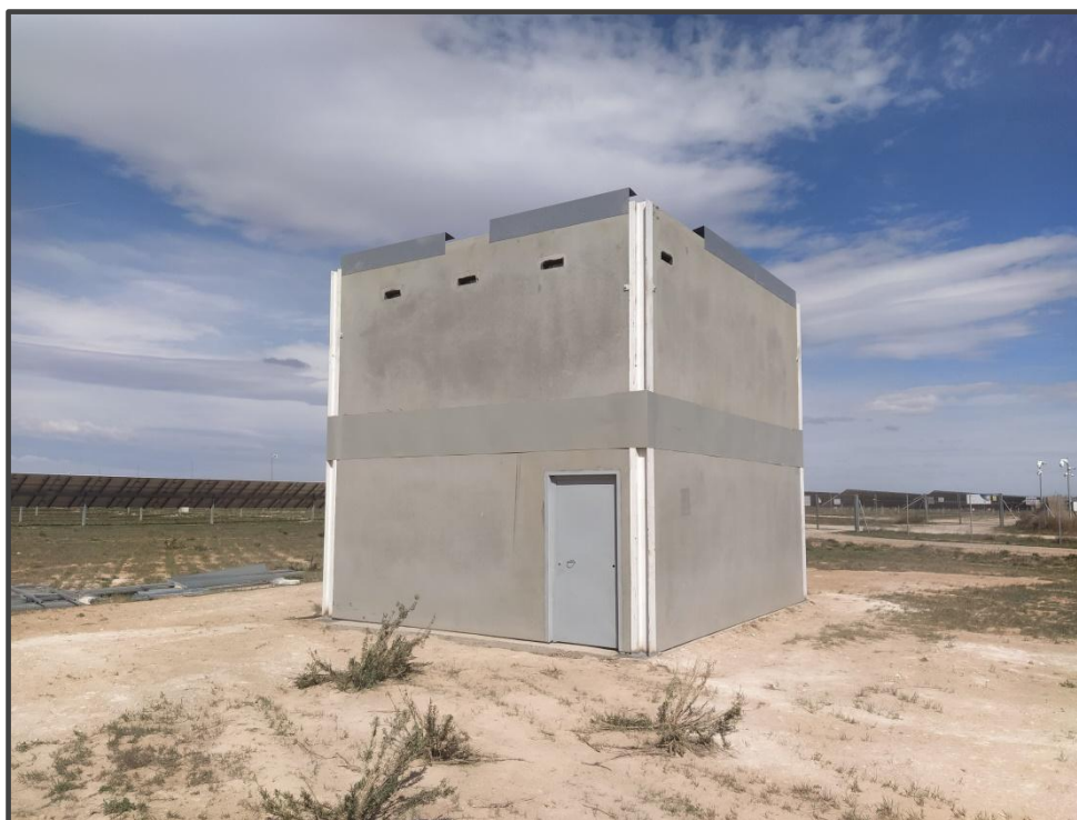
Fotografía 7. Exterior del primillar de nueva construcción.
