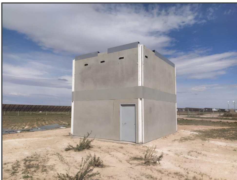
Fotografía 7. Exterior del primillar de nueva construcción.
