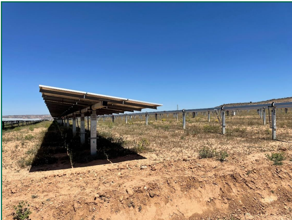
Fotografía 2. Vegetación entre placas actualmente.
