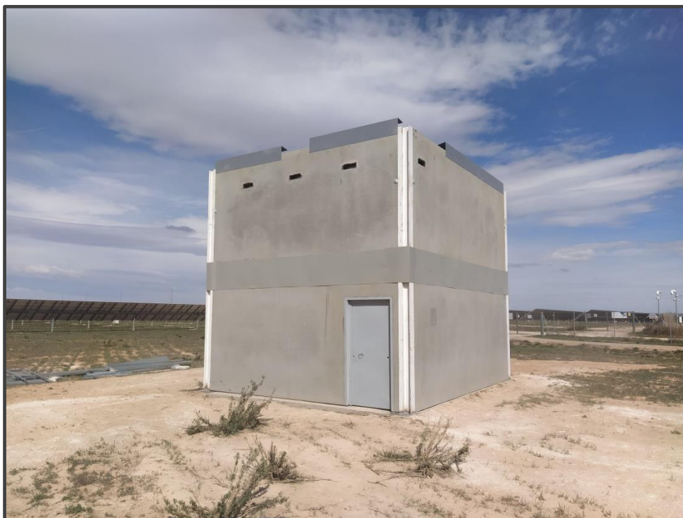
Fotografía 6. Exterior del primillar de nueva construcción.
