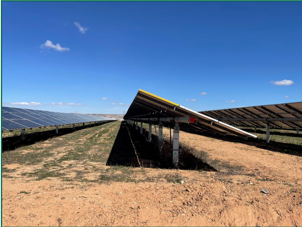
Fotografía 1. Vegetación entre placas actualmente.
