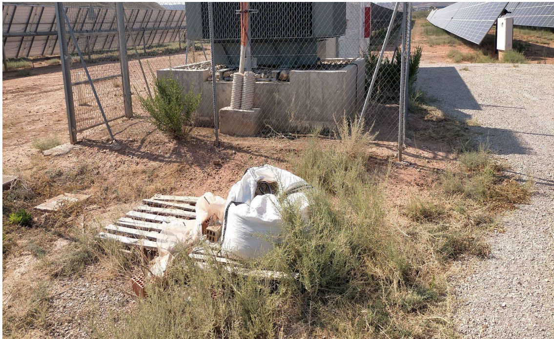
Fotografía 7: Material acopiado en el interior de la PFV
