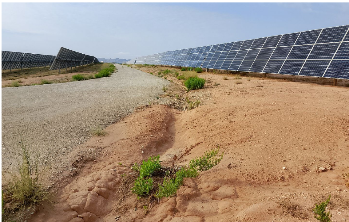
Fotografía 8: Vial principal de la PFV y drenaje que desemboca en el punto de acceso
