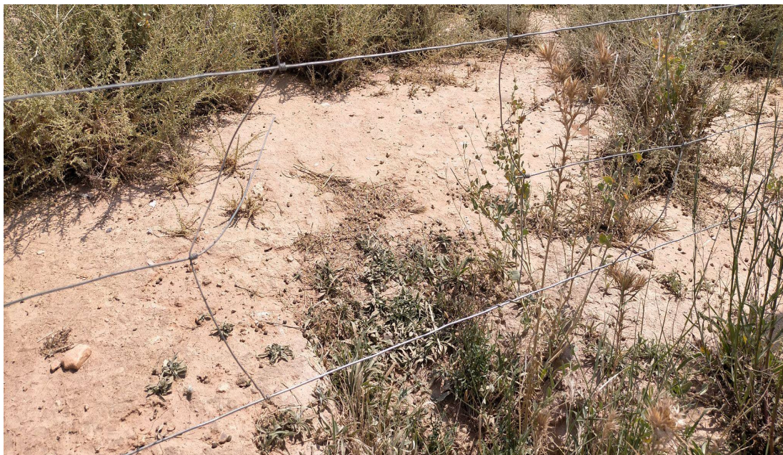
Fotografía 4. Punto de rotura en el vallado perimetral
