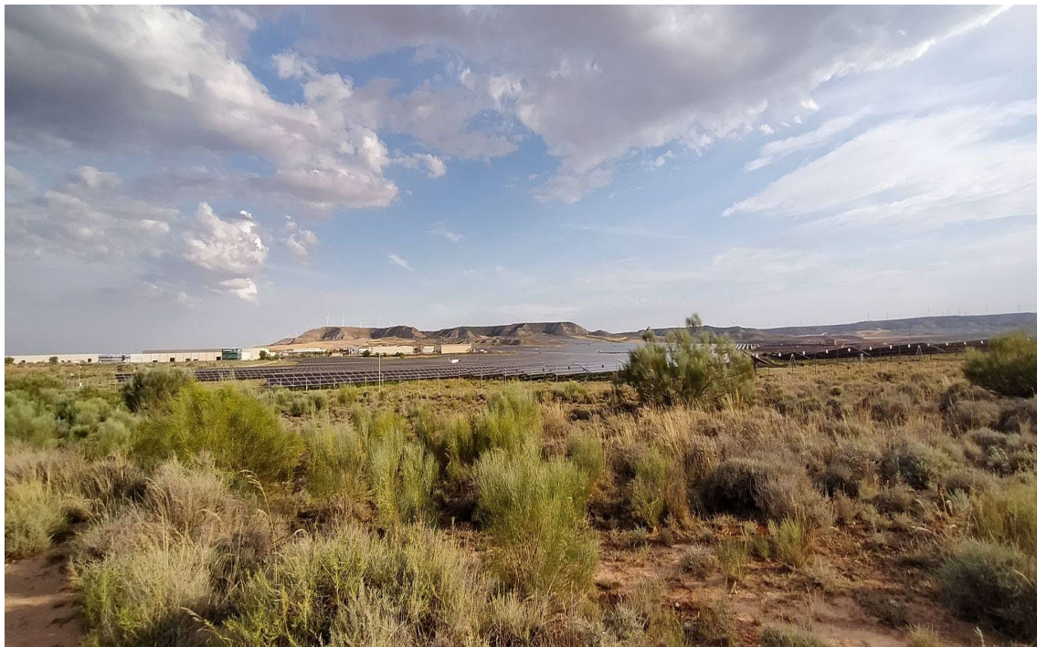
Fotografía 1: Vista de la PFV desde el sureste
