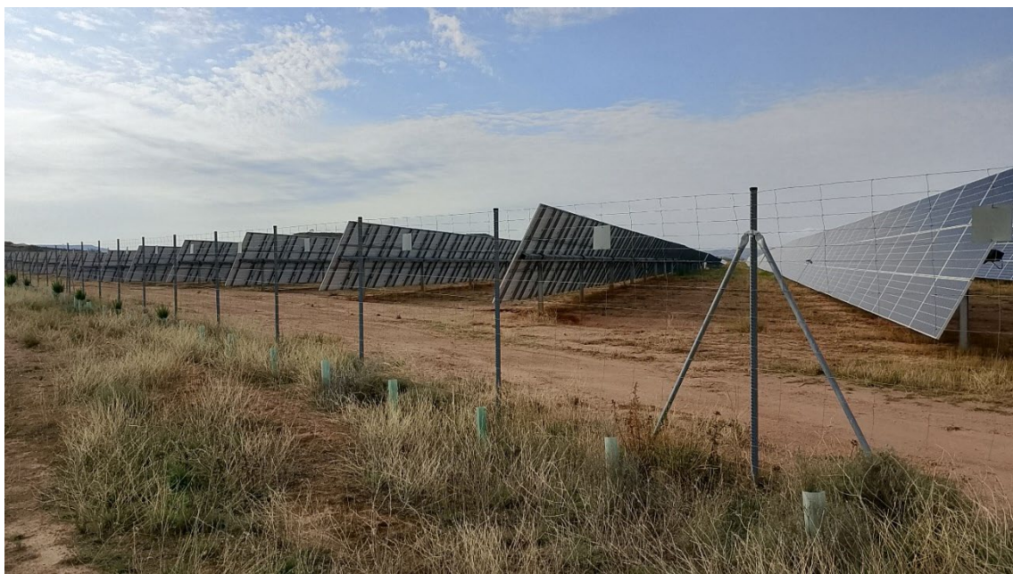
Fotografía 6: Vista al vallado perimetral
