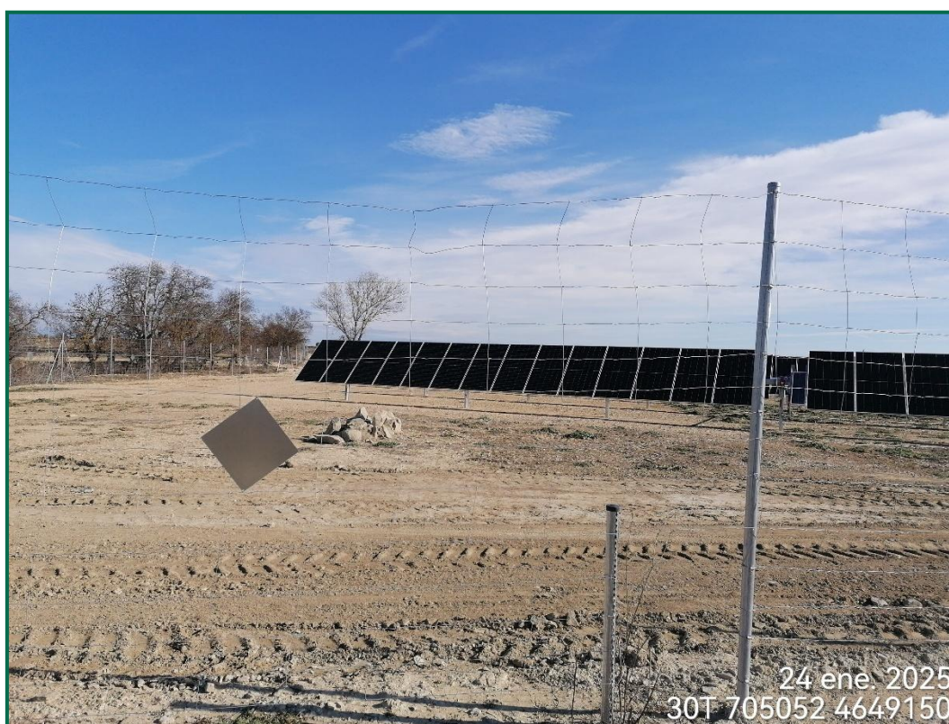
Fotografía 15. Vallado perimetral con el paso de fauna y placas anticolisión.
