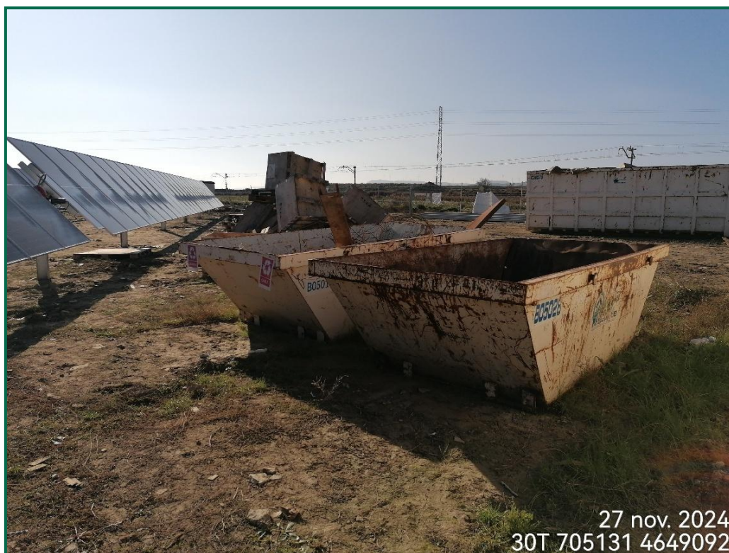
Fotografía 19. Zona de residuos inertes durante la obra.
