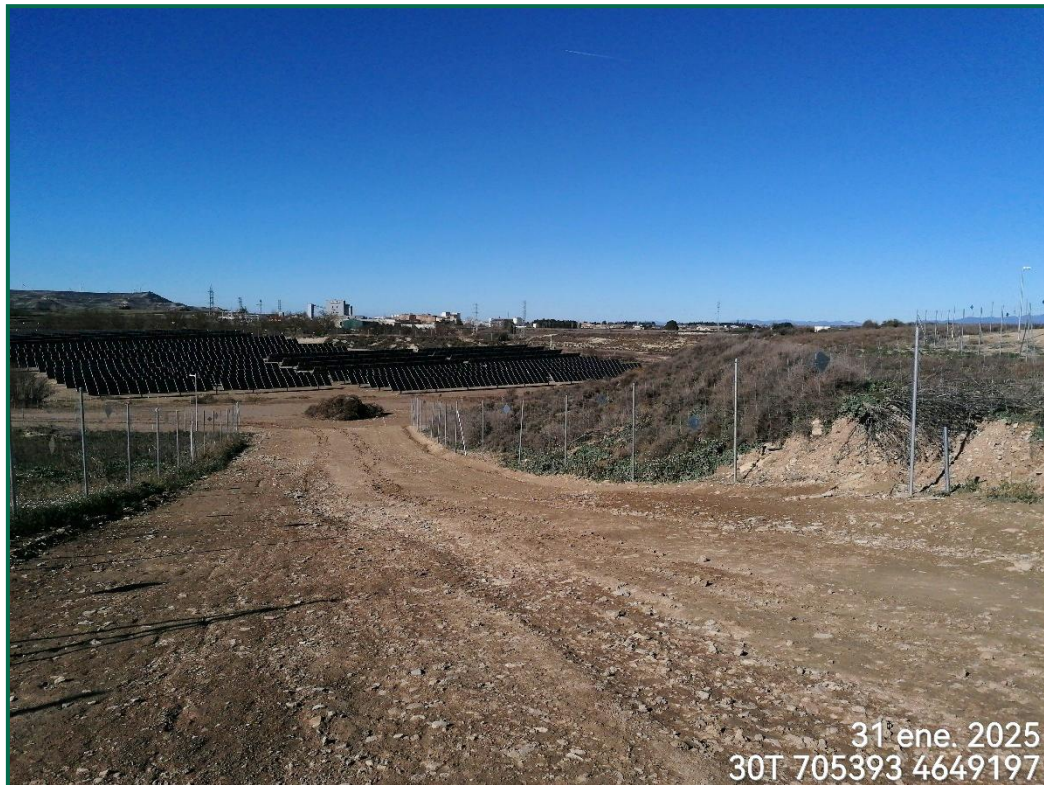
Fotografía 16. Vallado perimetral con pasos de fauna y placas anticollisión.
