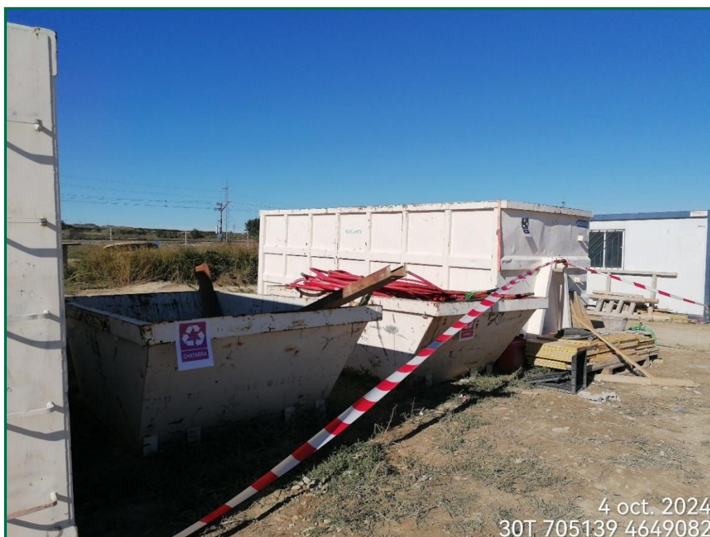
Fotografía 20. Zona de residuos inertes durante la obra.
