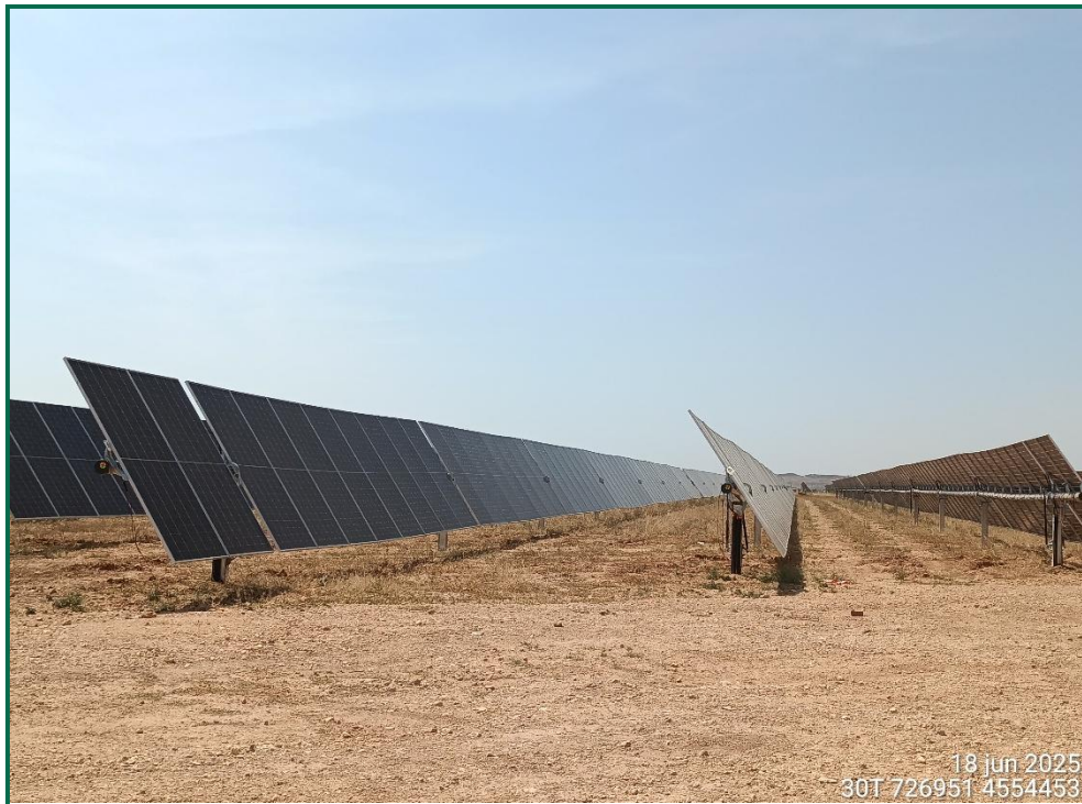
Fotografía 4. Superficie de la zona de hincado.
