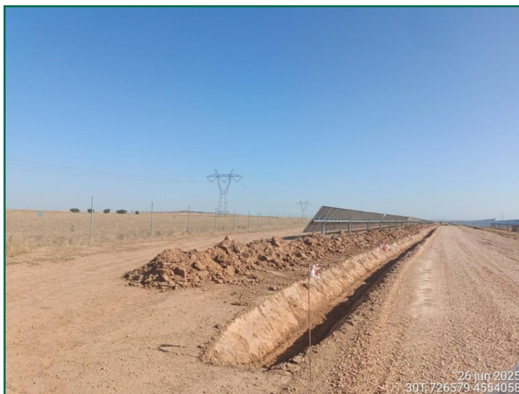
Fotografía 3. Creación de cunetas.
