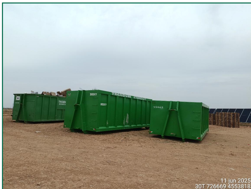
Fotografía 9. Punto limpio de residuos inertes.
